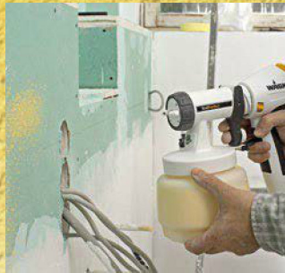
15. ... Sprühbild (rund, senkrecht oder waagrecht) eingestellt und eine Testsprüfung vorgenommen.
