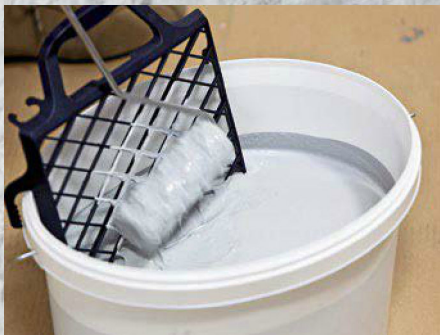
7. Material mit der Schaumstoffrolle aufnehmen und kreuz und quer an die Wand rollen.
