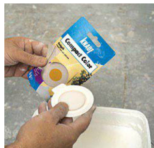
7. Für die gelben Wandflächen wird weißer 0,5-mm-Easyputz mit Compact Color-Pigmenten eingefärbt.
