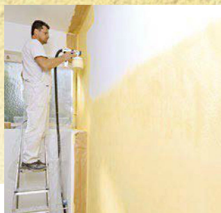
12. ... dabei mit gleichförmiger Geschwindigkeit und immer demselben Abstand zur Wand.
