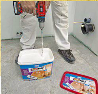
1. Der gebrauchsfertige weiße Mineralputz wird zunächst im Rechteckeimer gut durchgerührt.
