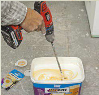
9. Das Ganze wird ordentlich durchgerührt, bis die Pigmente gleichmäßig verteilt sind, dann ...
