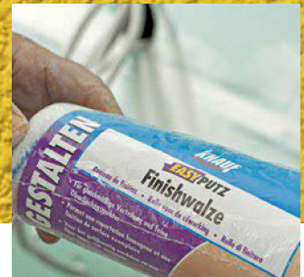
4. Anschließend kommt die zum System gehörende sogenannte Finishwalze zum Einsatz.
