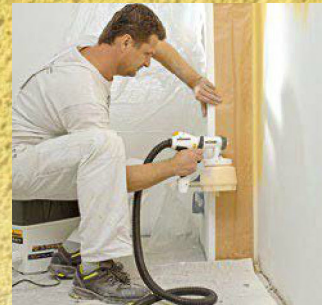
16. Passen Stärke und Sprühbild, werden erst die Grenzbereiche senkrecht und waagrecht, ...
