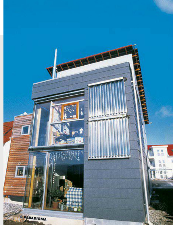
In besonderen Fällen ist auch eine Fassadenbefestigung (sinnvoll) möglich. www.paradigma.de
