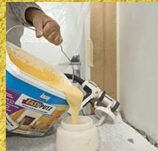
12. Beim Sprühauftrag muss nicht erst in einen sauberen Eimer umgefüllt werden, der Putz kann ...
