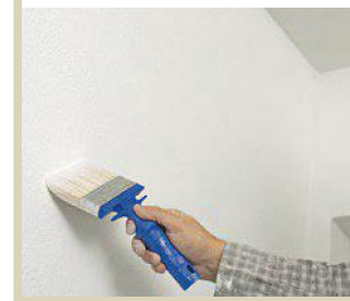
12. ... dabei mit gleichförmiger Geschwindigkeit und immer demselben Abstand zur Wand.
