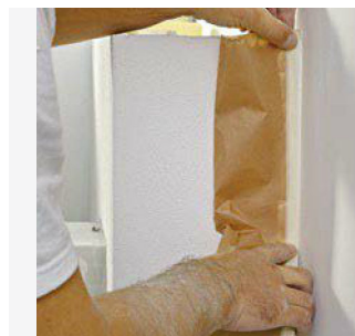
6. Vor dem folgenden Sprühauftrag werden die weiß verputzten Bereiche zum Schutz abgeklebt.
