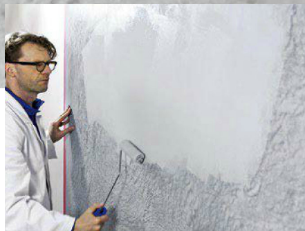
11. Dann folgt ein Farbauftrag (2 kg Weiß, 0,125 kg Schwarz, 25 g Tapetenkleister, 1 l Wasser), ...
