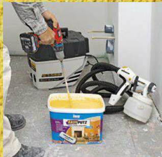
11. Dann wird solange weiter durchmischt bis die Farbpigmente völlig gleichmäßig verteilt sind.
