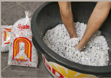
1. Das Material wird ins kalte Wasser gegeben und von Hand gut vermengt. Nach ...
