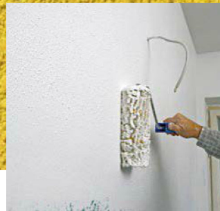
3. ... vollsatt kreuzweise aufgerollt. Das ist wichtig, um eine einheitliche Struktur zu erzielen.
