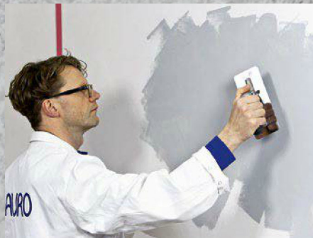
8. Das Farbe-Faserputz-Gemisch mit einer Glättkelle in schwunghaften Zügen ...
