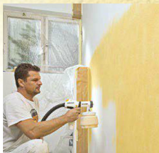
17. ... dann die innenliegenden Teilbereiche mit dem eingefärbten Putz versehen. Man arbeitet ...
