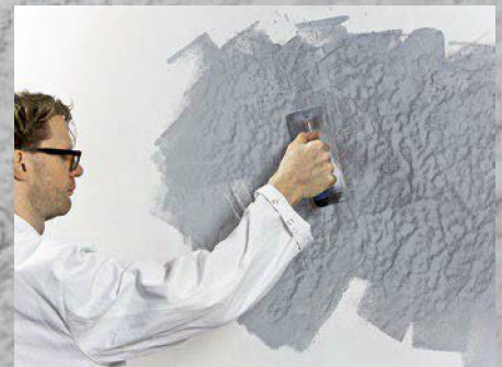
9. ... verziehen und leicht aufdrücken, bis sich der gewünschte Beton-Look zeigt.
