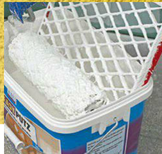
2. Mit der Easyputz-Auftragswalze wird das Material aufgenommen und auf der grundierten Wand ...
