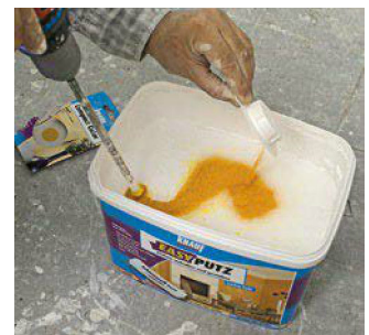
8. Erst wird nur eine Portion des Farbtönen in den mit 10 % Wasser verdünnten Putz eingestreut.
