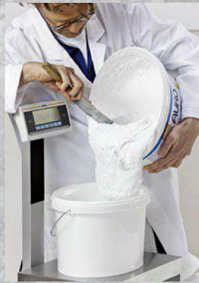
2. ... Reichweite von 15m 2 gibt man 1,5 kg Faserputz in einen sauberen Eimer.
