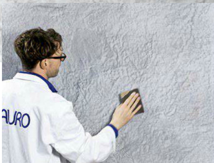
10. Ist die Wand getrocknet, erfolgt ein Zwischenschliff mit feinem Sandpapier.
