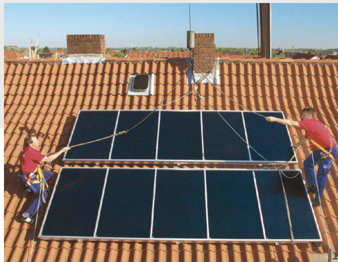
Mit speziellen Montagegestellen lassen sich Flach- und Vakuumröhrenkollektoren auch auf einem nach Süden ausgerichteten Flach- oder Garagendach aufstellen. www.vaillant.de
