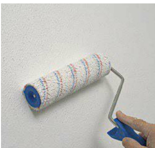
5. Mit dieser kurzflorigen Rolle lässt sich das Material gleichmäßig und ohne Nestbildung verteilen.
