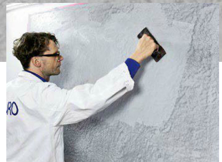
12. ... der mit der Glättkelle verteilt wird, bis ein leichter Glanz entsteht.
