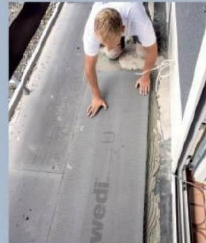
6. ... nach innen verklebt. Diese 3 cm dicken Platten dienen zum Höhenausgleich wegen der Türschwelle.
