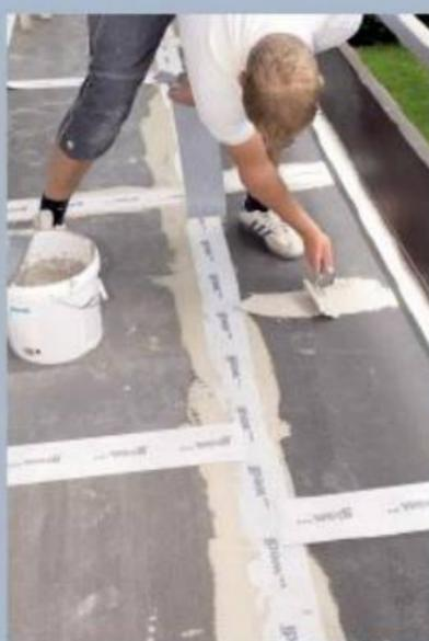
12. ... dann werden die Dichtbänder zugeschnitten, aufgelegt, eingedrückt und zugleich glattgestrichen.
