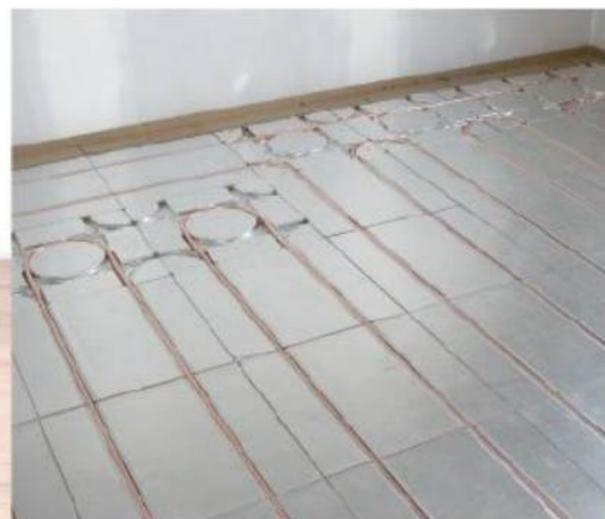
Die Fußbodenheizung mit den mit Aluminium verkleideten Elementen aus dem ökologischen Dämmmaterial ÖKOpor sowie Kupferrohren lässt sich z. B. ideal mit Gussasphalt kombinieren. Der Nassestrich kann dann einlagig eingebracht werden. [www.joco.de](http://www.joco.de)
