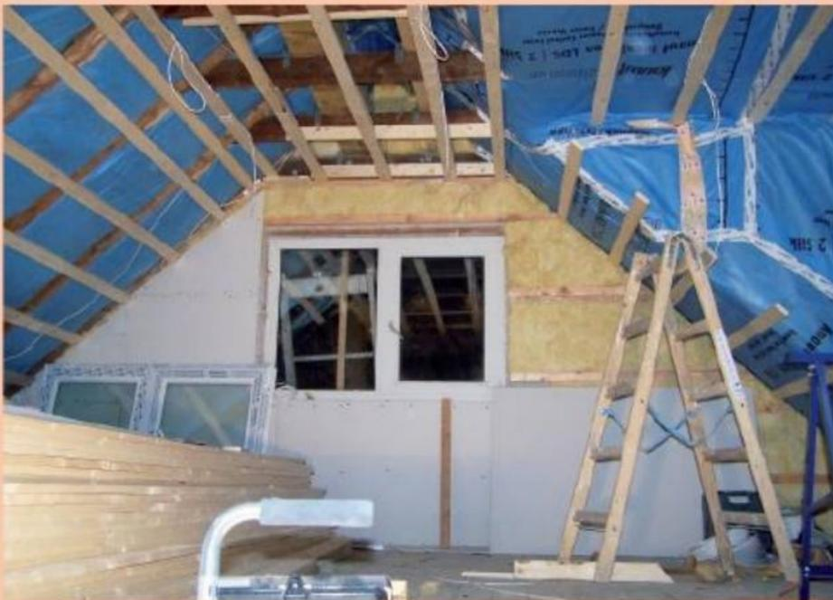
Mit einer Innendämmung und Gipskartonbeplankung konnte auch die Giebelseite gedämmt werden. Daraufhin folgte der Innenausbau der neuen Dachwohnung.
