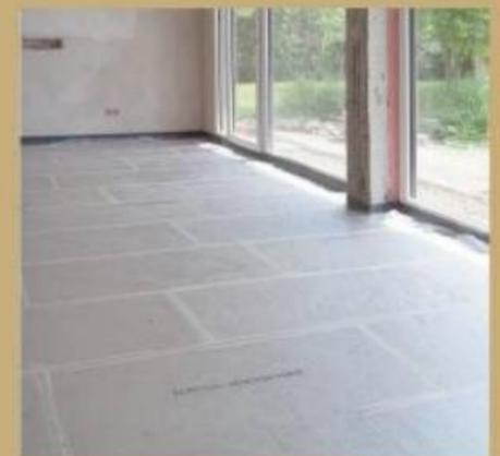
4. Die Stöße sind abgeklebt. Die ebene und tragfähige Unterkonstruktion ist fertig für die Heizung.
