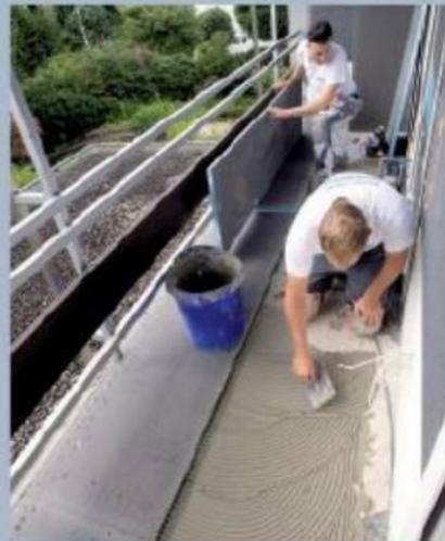
5. ... und mit einer Mittelbettkelle aufgekämmt. Hier hat man dann die erste Lage Bauplatten von außen ...
