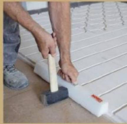
7. Die Platten werden per Fäustel und Verlegewerkzeug (Haudegen) dicht stoßend zusammengefügt.
