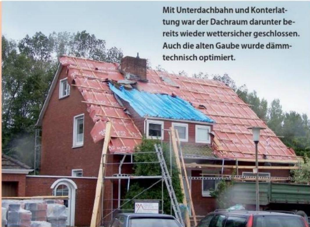
Mit Unterdachbahn und Konterlatung war der Dachraum darunter bereits wieder wettersicher geschlossen. Auch die alten Gaube wurde dämmtechnisch optimiert.
