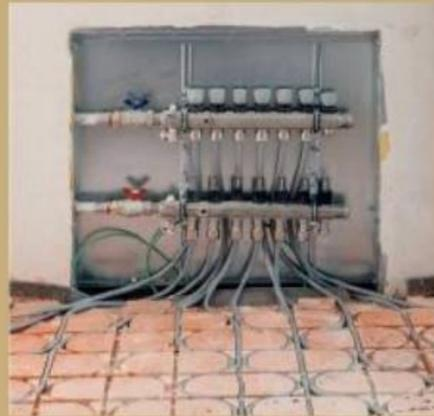
14. Alle Heizkreise sind an der Verteilstation angeschlossen und werden dann auf Dichtheit geprüft.
