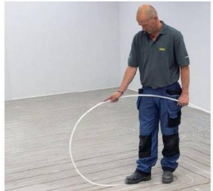
Fußbodenheizung nachrüsten: Der alte Bodenbelag wird entfernt und die Kanäle für die Rohre direkt in den vorhandenen Estrich geätzt. Die Heizungsrohre werden dann in die geätzten Kanäle eingelegt und an den Heizkreisverteiler angeschlossen. Anschließend kann der Boden vom Fliesen- bzw. Bodenleger verspachtelt und neu belegt werden. Vorteil: Die bestehende Gesamthöhe bleibt erhalten. System Rotex cut von [www.rotex.de](http://www.rotex.de).
