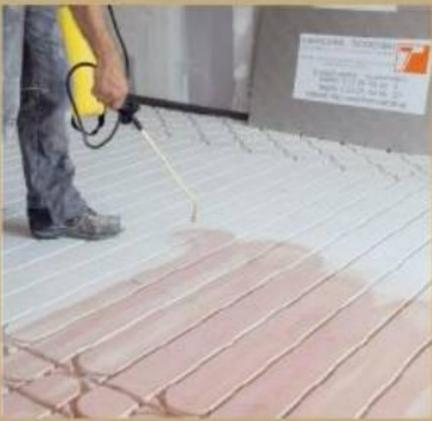
9. Ist die Fläche fertig und gereinigt, kann die Grundierung mit einem Drucksprüher aufgebracht werden.
