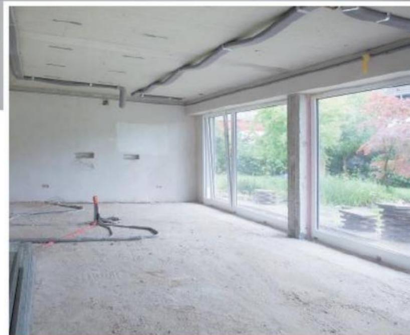
Der Wohnraum nach Entkernung und Rohsanierung: Für den neuen Heizboden mit Dämmung plus Belag standen nur neun Zentimeter Höhe zur Verfügung.
