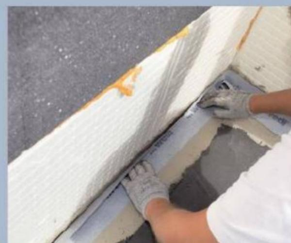
13. An den Hauswänden wird gleichermaßen – aber mit aufgewinkelten Bändern – abgedichtet.
