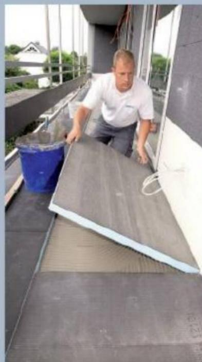
9. Die Gefälleplatten sind stoßversetzt – auch zur unteren Lage! – zu verlegen, um noch mehr Stabilität zu bewirken.
