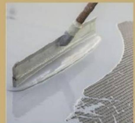
27. Mit einem Zahnrakel auf die entsprechende Höhe abziehen, mindestens jedoch 7 Millimeter.
