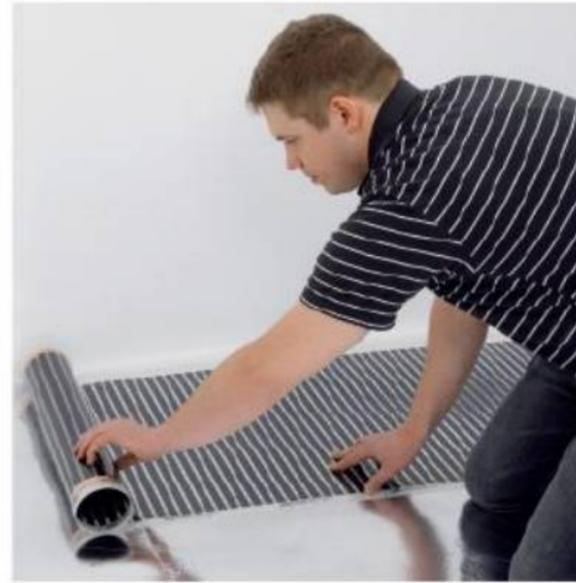
Auch mit einer Elektro-Fußbodentemperierungsfolie – speziell für Laminatböden – lässt sich der Wohnkomfort erhöhen, denn sie sorgt für eine angenehme, gleichmäßige Wärmeverteilung. [www.warme-fuesse24.de](http://www.warme-fuesse24.de)
