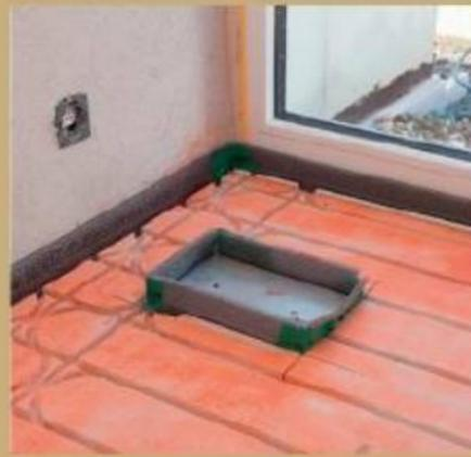
10. Bodenöffnungen werden einfach ausgeschnitten und mit Randdämmstreifen exakt eingefasst.
