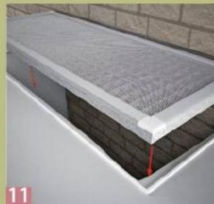
**11** Nun dreht man das Ganze um und legt den mit dem Schutzgewebe versehenen Rost wieder in die Lichtschachtzarge ein.
