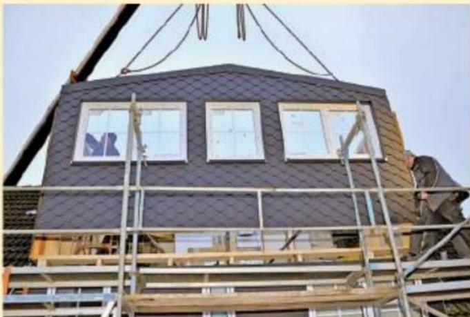
... dann folgte die Front, die bereits alle Fenster und die Wetterschutzbekleidung in Form von schuppenartig verlegten Fassadentafeln mitbringt.
