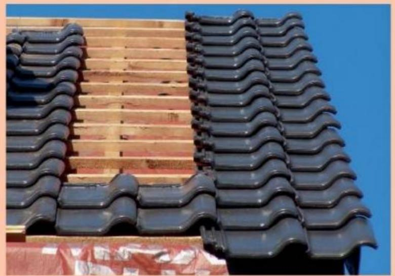
Die edle Dacheindeckung mit einem Flachdachziegel mit Sinter-Engobe im Farbton grau war auch wegen der schmutzabweisenden und besonders harten Oberfläche hier erste Wahl.
