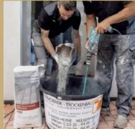
15. Erst dann wird die spezielle Vergussmasse mit Wasser zu einer homogenen Masse angerührt.
