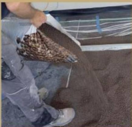
1. Zuerst wurde die Bodenplatte abgedichtet, dann die Ausgleichschüttung eingebracht.
