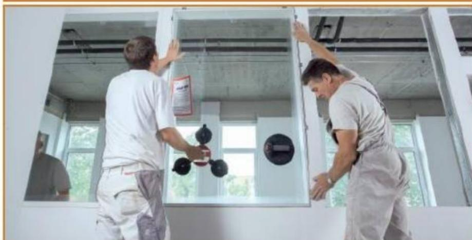
Ob als Fenster, Oberlichter oder raumhohe Verglasung, einzeln oder als Fensterreihe miteinander verkettet – Spezielle Trockenbaufenster sorgen auch innerhalb eines Gebäudes für Durchblick. Die EasyWin Fertigfenster werden montagefertig als Monoblock mit wandbündiger Doppelverglasung geliefert. Bereits in der Pro-
