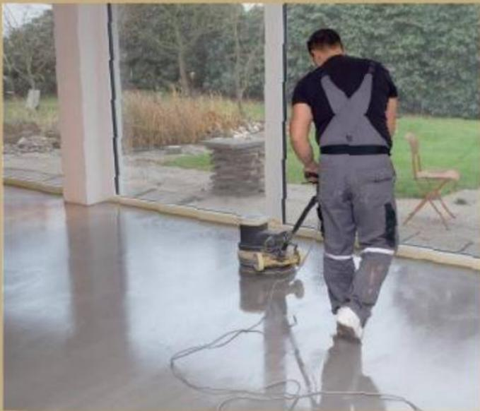
31. Zum Schluss wird der Boden porentief gereinigt und es folgt der Auftrag und das Einarbeiten der Dispersionspflegeemulsion.
