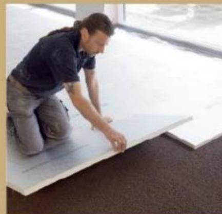
3. ... und mit druckstabilen und hochwärmedämmenden Wärmedämmplatten abgedeckt.
