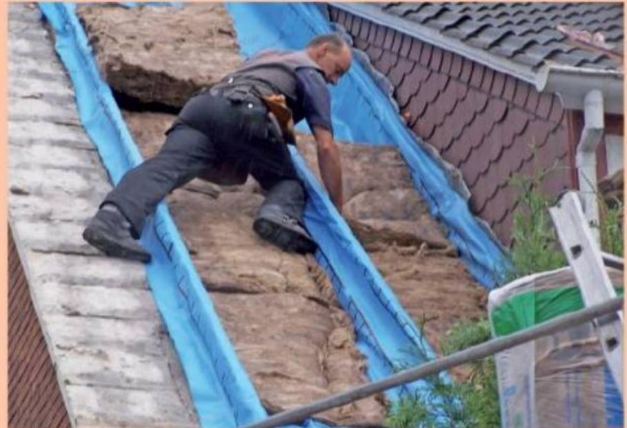
Die Dämmung wurde von außen her eingebracht. Dazu wurden die bestehenden Sparren mit Bohlen (4 x 25 cm) aufgedoppelt und die Dampfbremse wannenförmig ausgelegt. In die Zwischenräume kam zweilagig 30 cm Mineralwolle.
