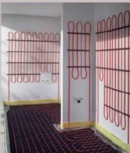
Bad ohne Heizkörper und dennoch angenehm temperiert: Das System Fonterra Side 12 Clip von Viega basiert auf einer Klemmschiene, die an der Wand befestigt und mit Heizrohren aus Kunststoff bestückt wird. Als Nasssystem eignet es sich zur Montage an Massivwänden und wird dann verputzt. Ergänzend lässt sich auch noch eine Fußbodenheizung installieren, hier mit einer Noppenbahn als Rohr-Fixierfläche. [www.viega.de](http://www.viega.de)
