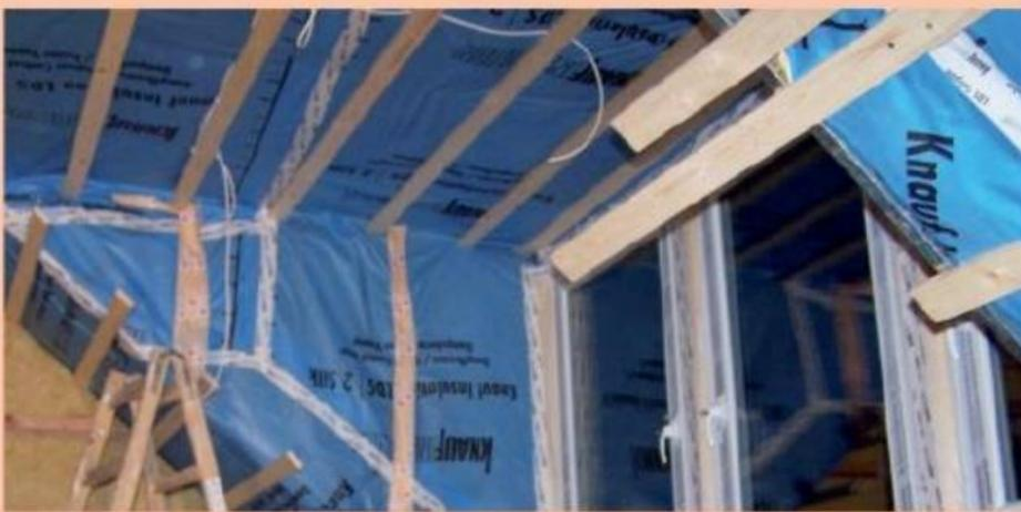
Die zwei neuen Gauben wurden perfekt in die alte Dachstuhlkonstruktion eingebunden und winddicht an die Dachschrägen angeschlossen.
