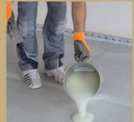
21. ... Okapox GF beugt die Armierung Schwund- und Spannungsrisbildung aus dem Untergrund vor.
