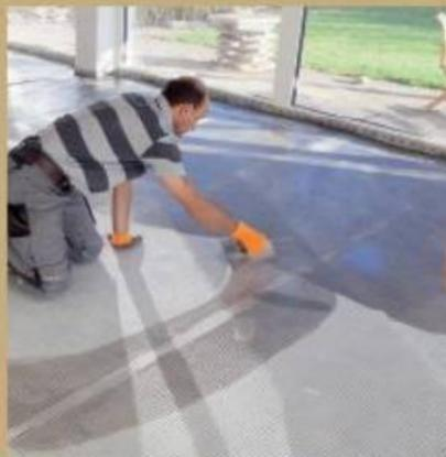
22. Die vergossene Grundierung wird mit einer kurzen Glättkelle verteilt, dann scharf abgezogen.
