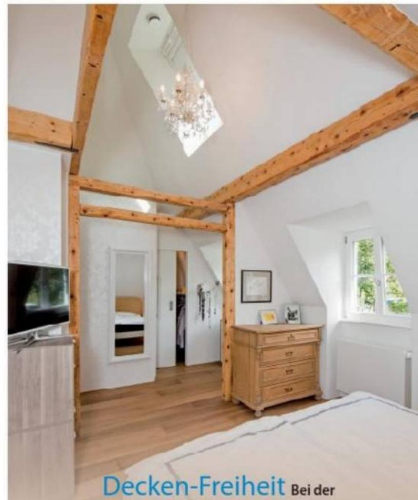
**Decken-Freiheit** Bei der Sanierung dieses Walmdachhauses hat man zum Teil Zwischendecken und -wände geöffnet, das tragende Balkenwerk renoviert und so spannende Innenraumeindrücke erzeugt. So etwa hat der Schlafraum mit vorhandener Gaube darüber noch eine Dachfläche mit Fensterbelichtung bekommen. Offenheit und Helligkeit werten den Dachraum überzeugend auf, das Konstruktive bleibt ebenfalls erlebbar.
