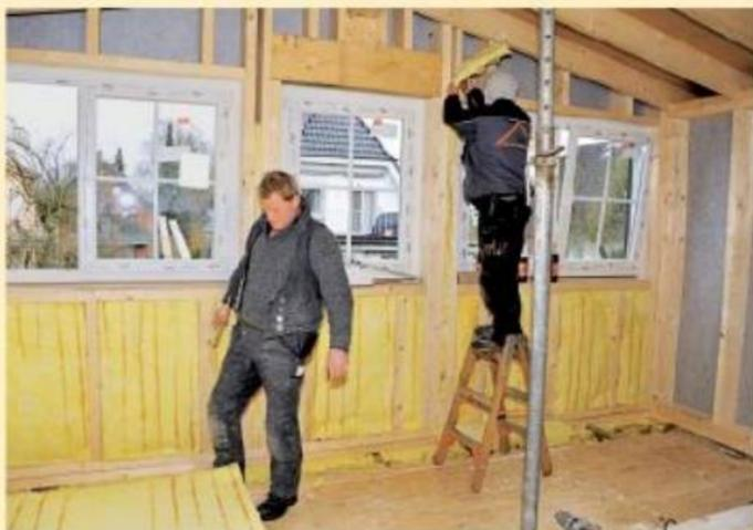
Zusammengeschraubt und mit dem sanft geneigten Satteldach überdeckt begannen dann die Dämm- und Innenausbauarbeiten.
