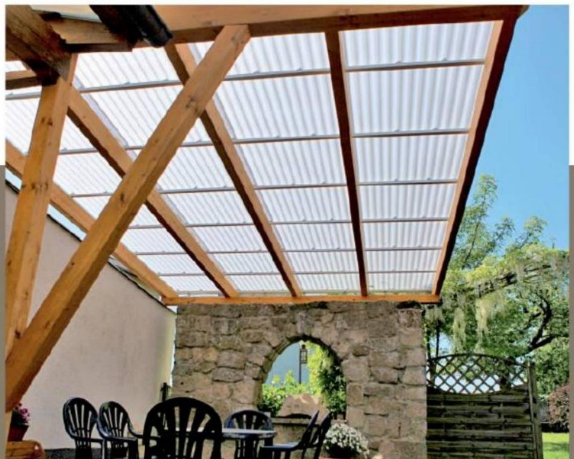
Unter einem „Flüsterdach“ bekommen Sie die Materialbewegungen nicht mehr zu hören. Die Gleitprofilkonstruktion ermöglicht das freie Bewegen, bei gleichzeitig sicherem Halt.
