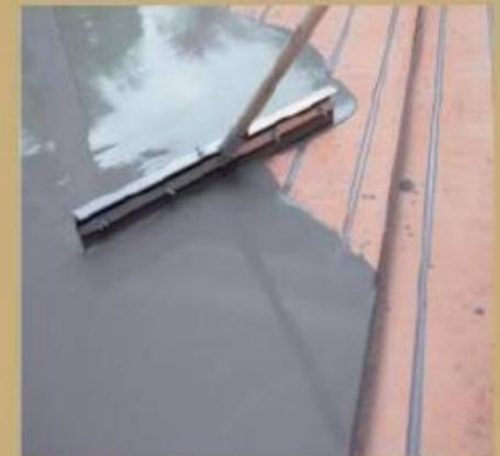
18. Für eine Schichtdicke von 3 mm wird der Verguss mit der Zahnrakel (Draufgänger) abgezogen.
