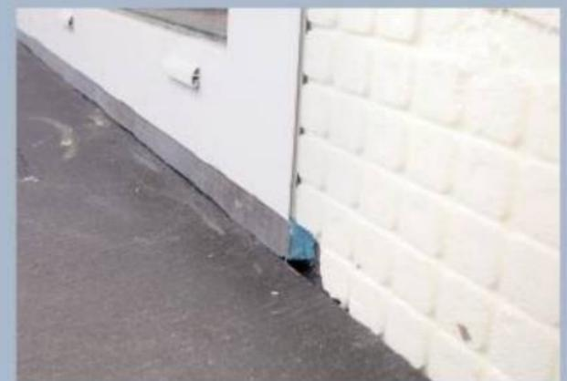
10. Gut zu sehen, wie die Balkonbodendämmplatten an die neue Fassadendämmung und am Balkontüranschluss angearbeitet wurden.
