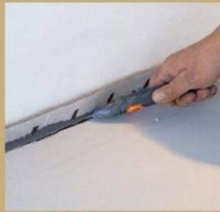
29. Erst nach dem Aushärten bzw. Trocknen der Spachtelmasse wird der Randdämmstreifen entfernt.
