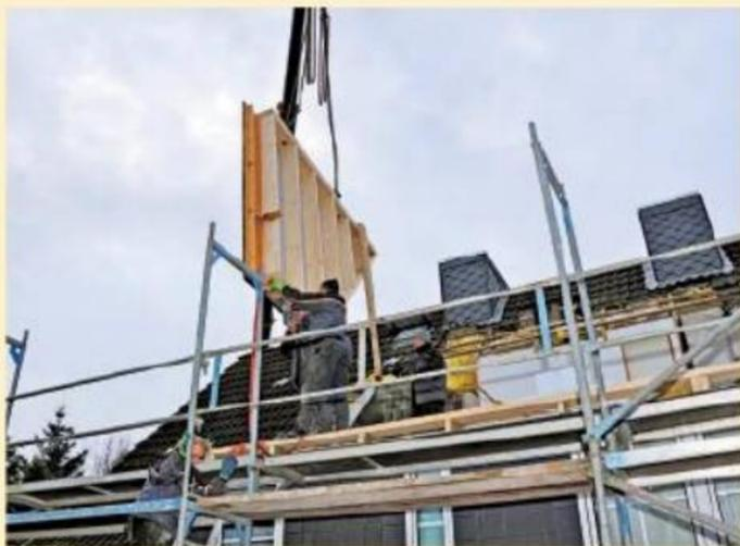
Dank Vorfertigung in der Betriebshalle konnten die Gaubenteile dann schnell an Ort und Stelle gebracht werden. Erst die Seitenteile, ...
