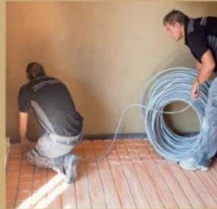
12. Vom Heizkreisverteiler aus nun die Heizrohre in die Fräsungen der Gipsfaserplatten einlegen.
