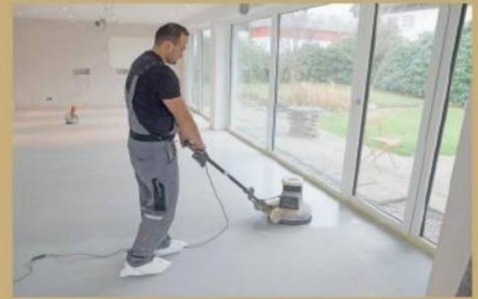
30. Das Vergüten der Oberfläche mit Hilfe einer Einroller-Schleifmaschine und speziellen Pads sorgt für eine ebene und elegant mattglänzende Oberfläche.
