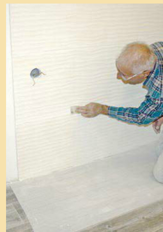
11. Nach Trocknung heißt es Feinarbeit: Die Nahtstellen werden der Profilierung gemäß beigeschliffen.
