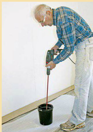
5. Kurz einsumpfen lassen, dann gut verrühren damit das mehrlartige Pulver keine Klumpen bildet.
