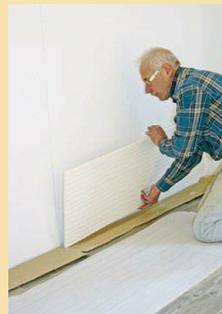
8. ... an der Orientierungslinie ansetzen und unter leichter Schiebewegung an die Wand drücken.
