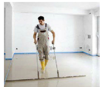
7 Durch Schwabbeln des frisch eingebrachten Nivellierestrichs entsteht eine planebene Oberfläche.
