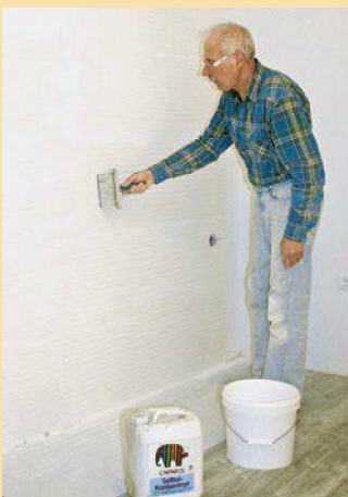
12. Alle 10 Stuckelemente werden anschließend noch grundiert, um ihr Saugverhalten zu reduzieren.
