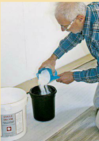
4. Am besten kleinere Teilmengen anmischen, da die Verarbeitungszeit bei zirka 30 Minuten liegt.
