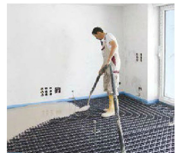
6 Das Material umschließt die Kunststoffrohre und sorgt so für einen idealen Wärmetransport.
