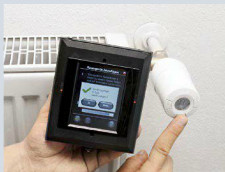
17. Danach folgen alle Heizkörperthermostate, die dann entweder konventionell oder über das Zentralgerät geregelt werden können.
