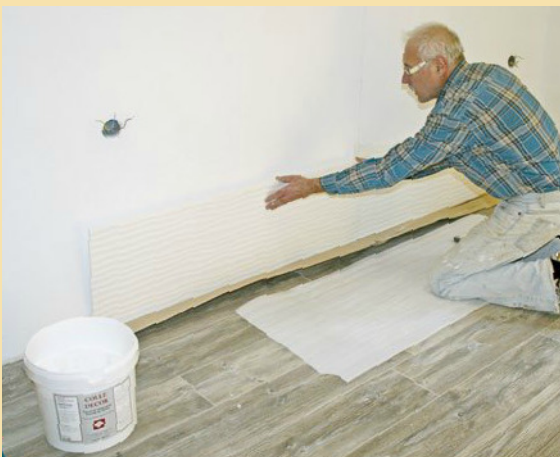
9. Die nächste Platte ist dann die zweite Basisplatte. Auf vollflächigen Wandkontakt und versatzfreien Kantenverlauf zur ersten Platte achten. Der Mittelstoß wird ebenfalls verklebt.
