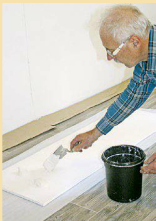
6. Dann wird der Klebemörtel batzenweise auf der Plattenrückseite aufgetragen und anschließend ...
