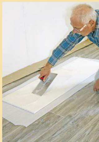
7.... mit einer 8er-Zahntraufel gleichmäßig auf der gesamten Fläche verteilt. Die erste Platte ...
