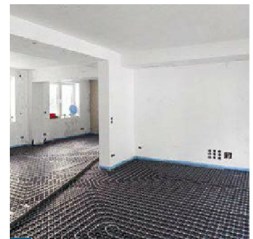
3 Die Trägerplatten des Systems Minitec und die Kunststoffrohre der Fußbodenheizung sind verlegt.
