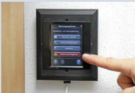
18. Jetzt kann der abschließende Netzwerk-Test durchgeführt werden. Danach läuft das funkbasierte Regelungssystem reibungslos.
