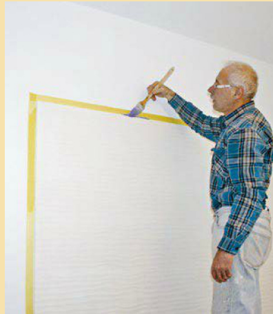
14. Denn die profilierte Fläche ist ja etwas erhaben und so sollten auch die Außenkanten einen Farbanstrich bekommen.
