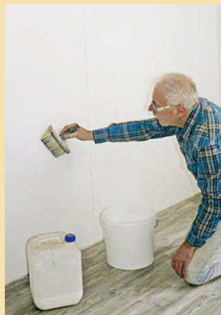
2. Da die Wand bereits mit Dispersionsfarbe gestrichen war, wurde sie angeschliffen und grundiert.
