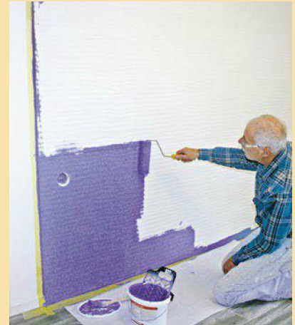
15. Beim Abrollen der Wandfarbe ist darauf zu achten, dass man auch gut in die Täler kommt. Deshalb sowohl horizontal ...
