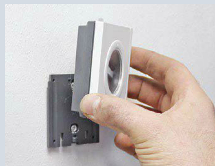
15. Der ebenfalls funkbasierte und mit Mignon AA-Batterien betriebene Raumthermostat muss dann nur noch in die Halterung gesteckt werden.
