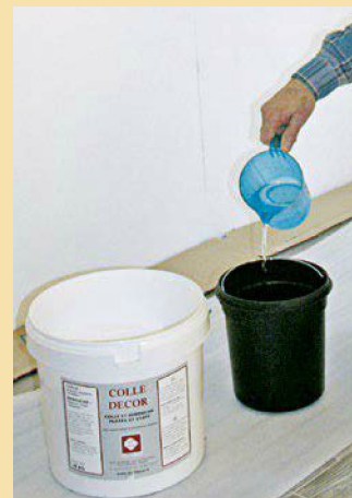
3. Den Pulverkleber im Verhältnis 1 kg Pulver auf 0,5 l Wasser anmachen. Erst das Wasser einfüllen.
