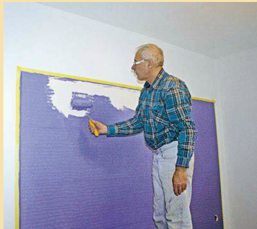
16. ... als auch vertikal mit der Fellwalze drübergehen. Zwei Farbaufträge sind ratsam. Das Abklebband am besten gleich danach wieder entfernen.
