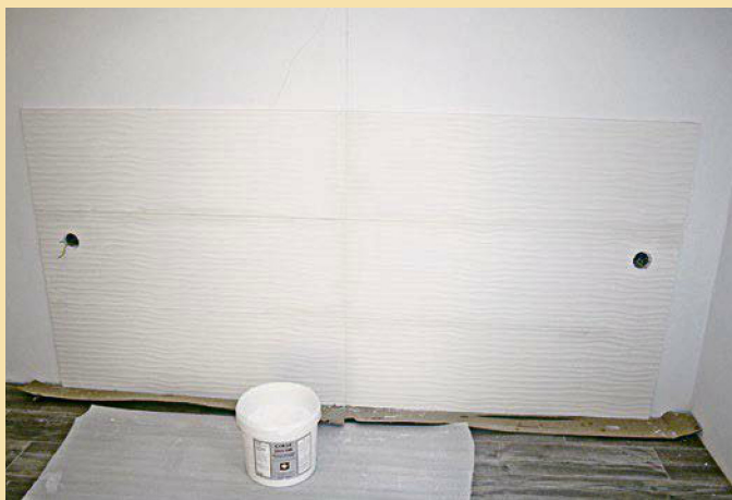
10. In der zweiten Plattenreihe wurden mit der Locksäge die Steckdosenöffnungen erstellt. Die Plattenstöße wurden nach dem groben Abtragen des Kleberaustritts etwas angenässt, um die Fugen leicht anzuformen.
