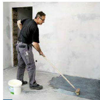
2 Knauf Schnellgrund festigt den Untergrund. Wird gut gelüftet, ist er nach zwei Stunden trocken.
