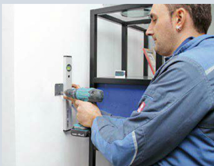
14. Befinden sich mehrere Heizkörper in einem Raum, können diese über einen Raumthermostat zusammengeschaltet werden.
