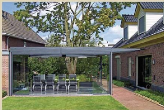
Freisitz unter und hinter Glas: Dank schwertförmiger Tragsparren sind große Spannweiten und damit auch stützenfreie Seitenverglasungen möglich. Resultat: Größtmögliche Transparenz. www.gladius-dach.de
