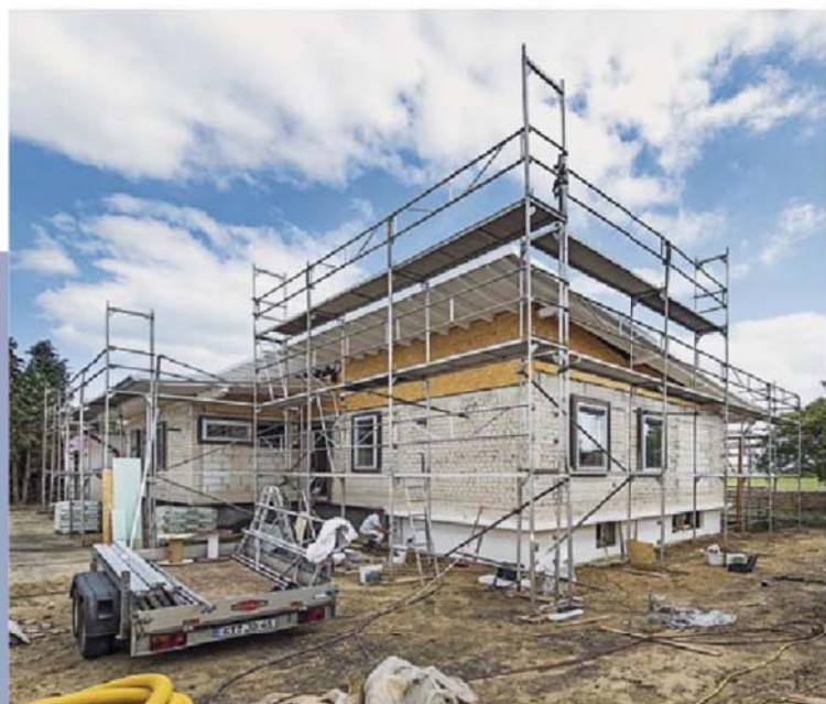
1. Neues Pultdach mit Wanderrhöhung und Dachüberstand, neue Fenster, die nach vorne versetzt wurden und die freigelegten Kalksandsteinwände – die neue Fassade kann kommen.
