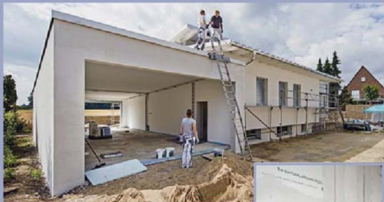
9. Nachdem die Plattenfugen mit Spachtel und Armierungsband geschlossen waren, wurden vollflächig Gewebepapier eingespachtelt. Abschließend konnte der dekorative Scheibenputz aufgebracht und die neue Fassade samt Garagenanbau mit einer Silikonharzfarbe gestrichen werden.
