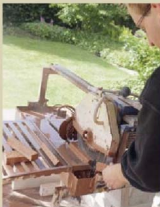
Die Schamotteplatten werden auf Maß geschnitten. Unter anderem werden sie zum Bau der Züge benötigt oder, wie hier, jetzt zum Bauen der Front des Ofens.
