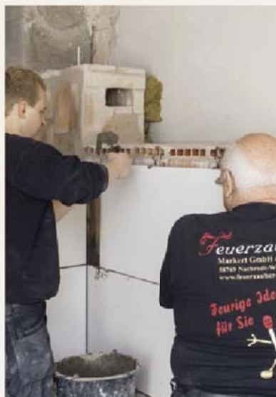
5. Die fünf bis sechs Zentimeter dicken Keramikelemente werden von den Profis mit Versetzmörtel oder Lehm gesetzt.
