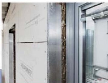
8. ... und zwar so, dass eine 40 mm breite Hinterlüftung hinter den Zementplatten entstand.
