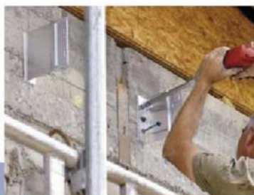
2. Die Wandhalter für die Profile wurden mit thermischen Trennelementen montiert.
