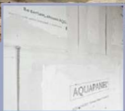
9. Nachdem die Plattenfugen mit Spachtel und Armierungsband geschlossen waren, wurden vollflächig Gewebepapier eingespachtelt. Abschließend konnte der dekorative Scheibenputz aufgebracht und die neue Fassade samt Garagenanbau mit einer Silikonharzfarbe gestrichen werden.
