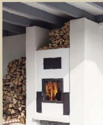
Nachdem die Front aufgebaut war, konnte direkt mit einem mineralischen Ofenputz weitergearbeitet werden. Nun kann der Feuerspaß im Garten beginnen.
