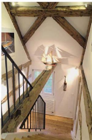
Mit dem Denkmalamt und dem Architektenbüro Payer wurde die sensible und doch grundlegende Sanierung durchgeführt – inklusive Eigenleistung.
