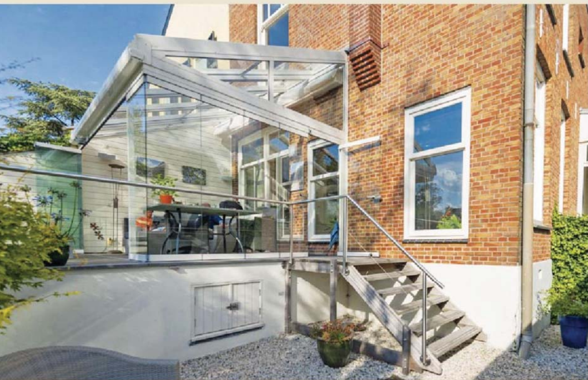
Die Aluminiumprofile des Glashauses wirken in Weiß unauffällig und leicht und passen perfekt zur angrenzenden Trennwand. Die Glaswände setzen sich aus zehn Einzelelementen zusammen, die sich über eine Führungsschiene seitlich verschieben lassen. Eine integrierte Drehflügeltür direkt an der Hauswand ermöglicht schließlich über eine Treppe den Zugang hinunter zum Garten.
