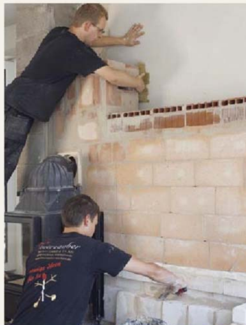
3. Die liegenden Züge des Warmluft-ofens sind bereits an den alten Schornstein angeschlossen. Die Ofenbank wird aufgemauert.
