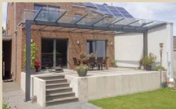
Moderne Glasdach-Variante mit schörkelloser, mittig platzierter Pfetten-Konstruktion aus Aluminium und gemauerter Seitenwand als Blick- und Windschutz. Zum Garten hin bleibt die Anlage offen. www.gladius-dach.de
