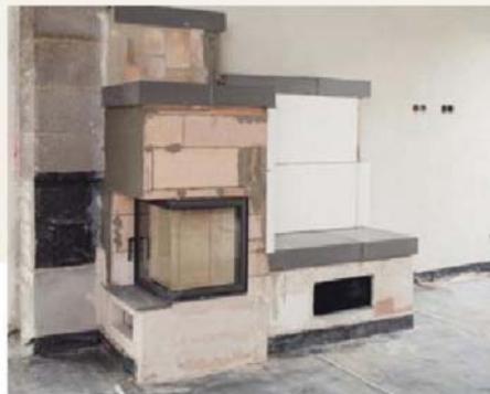
7. Bis auf die Verputzarbeiten ist die Anlage jetzt bereits fertiggestellt. Man kann schon sehen, wie sie in den Raum hineinpasst.
