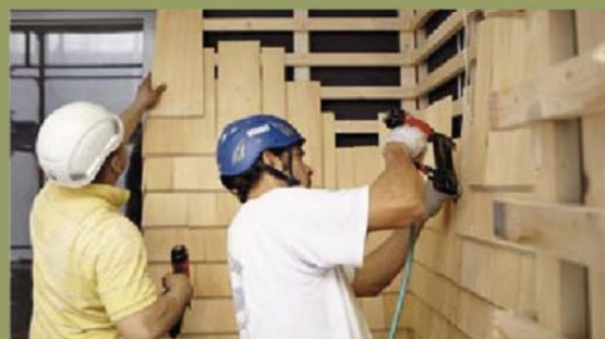
Traditionelles Material Schindeln: Als Wetterschutzmantel vor einer Außendämmung werden sie auf einer Konter-Trag-Lattung fixiert.
