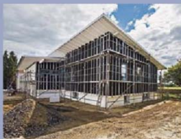
6. Je nach Windlastberechnung variiert der Achsabstand der Profile im entsprechenden Bereich.
