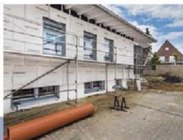
7. Jetzt konnten die Zementbauplatten mit Edelstahl-Fassadenschrauben fixiert werden, ...
