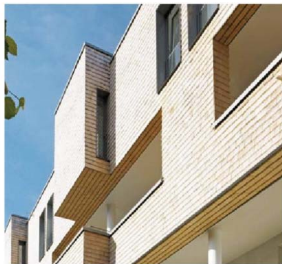
Traditionelles Material Schindeln: Als Wetterschutzmantel vor einer Außendämmung werden sie auf einer Konter-Trag-Lattung fixiert.
