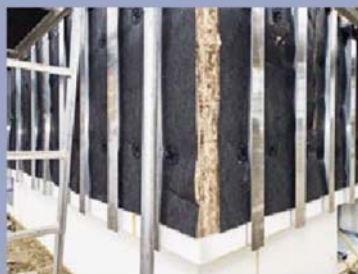
5. ... Alu-Tragprofile senkrecht auf den Wandhaltern mit Verbindungselementen befestigt.
