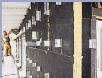
3. Gedämmt wurde mit hydrophobierten Glasfaser-Dämmmatten in 200 mm Stärke.
