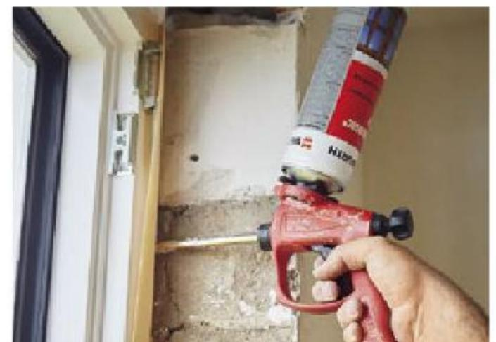
**15.** Erst wenn der Rahmen fest sitzt, schäumt man die Maueranschlussfuge mit Bauschaum aus und verklebt dann die Rundumdichtung (vgl. Abb. 11) an der Laibung.
