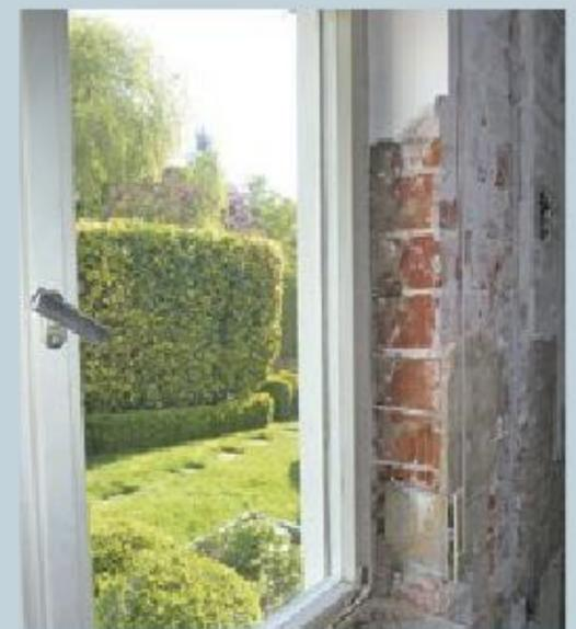
2. Damit die alten Fenster leicht ausgebaut werden konnten, arbeitete der Bauherr etwas vor und entfernte den Putz.
