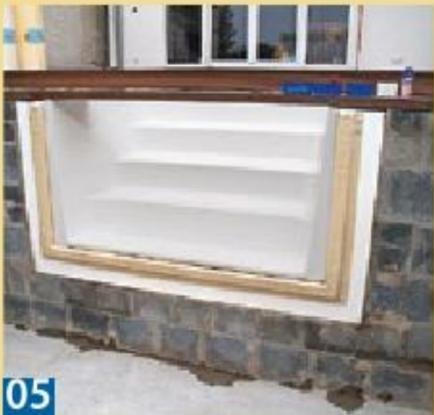
**05** Falls noch eine Fertigtreppe gewünscht ist, lässt sich diese gleich beim Aufmauern – z. B. an der Frontseite – mit einbinden.
