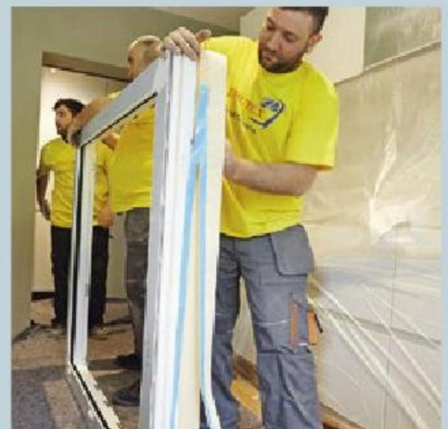
**11. ... am Rahmen** rundum eine spezielle Dichtmanschette von der Rolle angeklebt, die später für den winddichten Maueranschluss sorgt.
