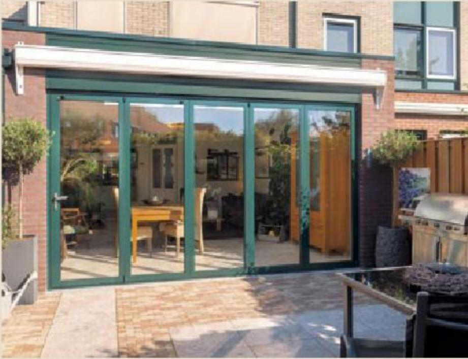
Die neue fünfteilige Glas-Faltwand erstreckt sich mit 4,20 Metern fast über die gesamte Hausbreite. Passend zu den übrigen Fenstern des Reihenhauses wurden die äußeren Rahmenprofile in Grün ausgeführt.
