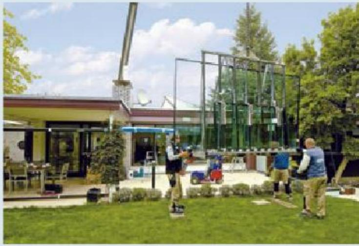
1. Mit Hilfe eines Krans werden die großen Fensterelemente übers Haus gehievt.
