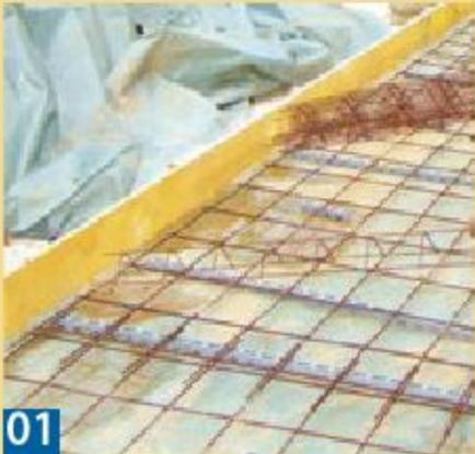
**01** Auf einer verdichteten Mineralbetonschicht werden eine PE-Folie (0,5 mm dick) verlegt, Stahlmatten sowie Stahl-Abstandshalter.
