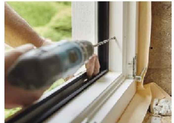
**13.** Dann folgt die mechanische Befestigung: An der jeweiligen Position (hängt von der Fensterhöhe ab) wird am seitlichen Rahmen durchs Holz gebohrt.
