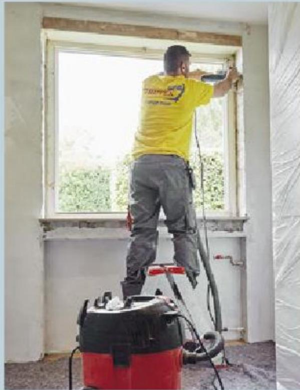
**4. Entlang der freigelegten Laibung** führte man eine Fugenfräse (mit Staubabsaugung) herunter, um die metallenen Montagelaschen abzutrennen.
