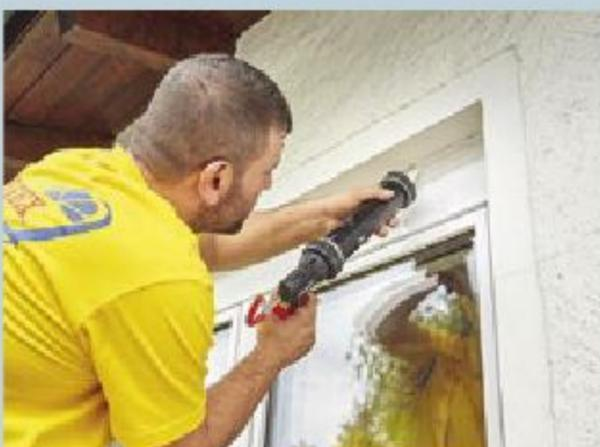
22. Und auch oben schließt in gleicher Weise der Fensterahmen mit einem Blendprofil ab. Damit ist der Fenstertausch fassadenseitig abgeschlossen.
