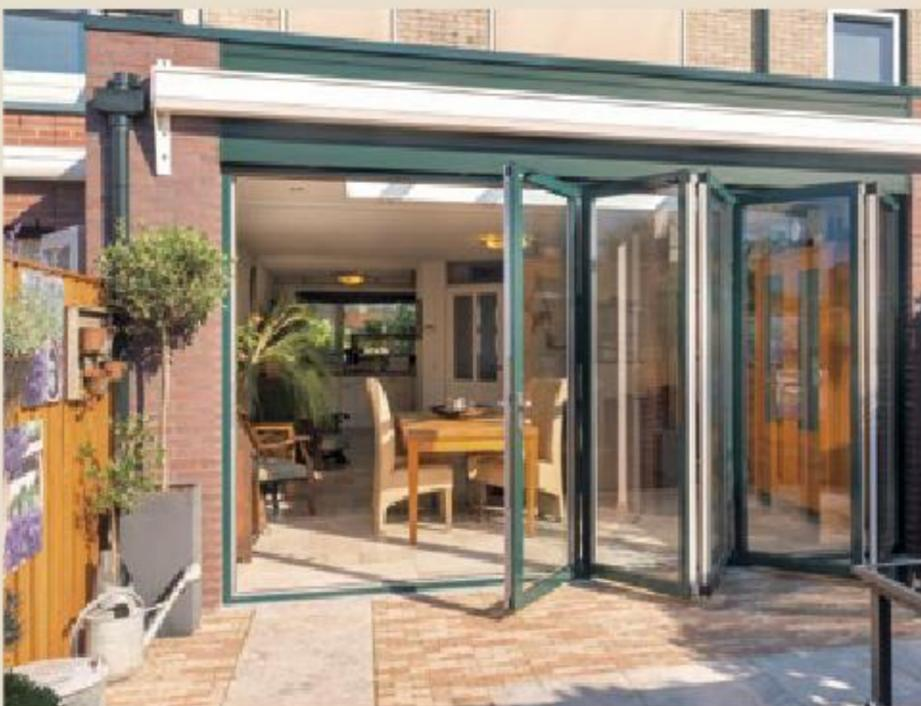
Und mit wenigen Handgriffen lässt sich die Glas-Faltwand leicht und leise nach öffnen, zusammenfallen und schließlich platzsparend zu einer Seite schieben. Hier wurde die nach außen öffnende Variante gewählt.
