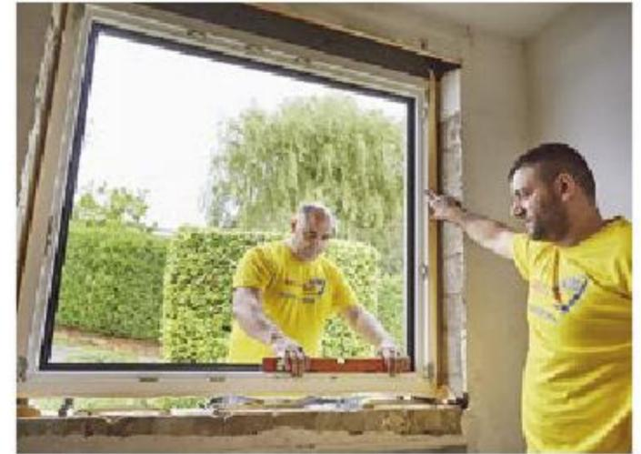
**12.** Der Rahmen wird innerhalb der Öffnung auf Höhe gebracht (mit entsprechenden Keilen bzw. Plättchen) und horizontal wie auch vertikal exakt ausgerichtet.
