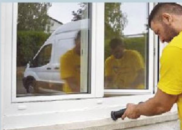
21. ... angedrückt. Oben und unten wird das Profil ebenfalls mit Silikon abgedichtet. Von der Raumseite her wird zudem der Hohlraum wärmedämmend ausgeschäumt.
