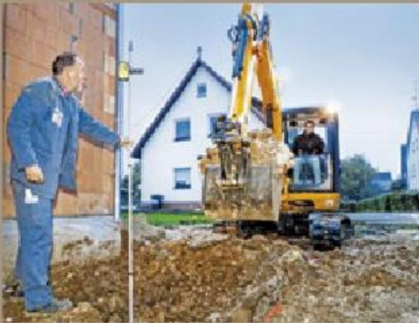
1. Den Dimensionen des Flüssiggasbehälters entsprechend wird mit einem Bagger die Grube ausgehoben.
