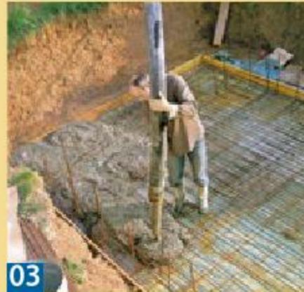
**03** Den Beton am besten per Pumpe einbringen, gleichmäßig verteilen und per Rechen und Richtscheit glatt abziehen.
