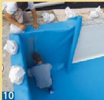
**10** ... auch an der Wand mit einem Aktivierungsmittel versehen und kalt verschweißt. Gewichte am Rand helfen, die Bahn zu fixieren.
