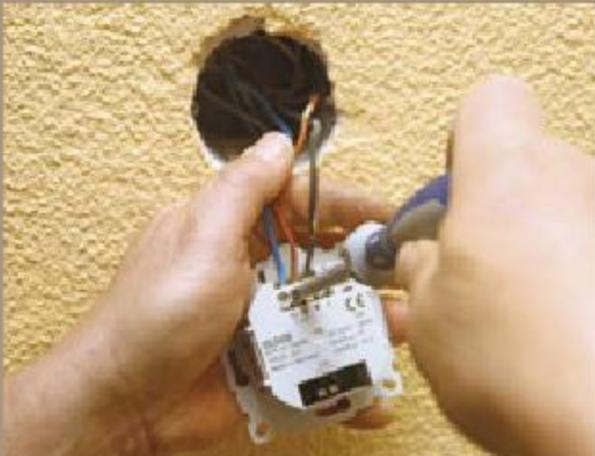
4. Vor dem Einbau in die Unterputzdose werden auf der Rückseite des Einsatzes die Anschlüsse für Netz- und Schaltstrom hergestellt.
