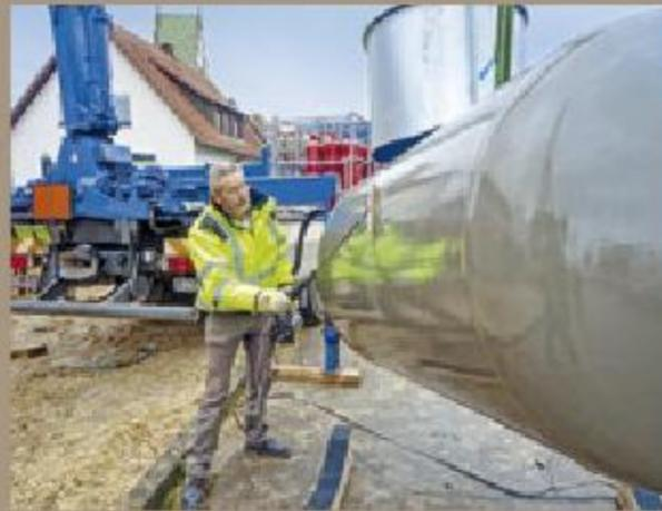
2. Bevor der Flüssiggasbehälter in die Grube kommt, wird erst noch dessen Korrosionsschutz geprüft.
