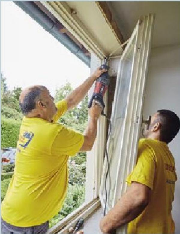
**3. Der Ausbau:** Zuerst durchtrennten die Monteure mit einer Säbelsäge die Kippstange zum Flügel, der sich dann einfach aushebeln ließ.
