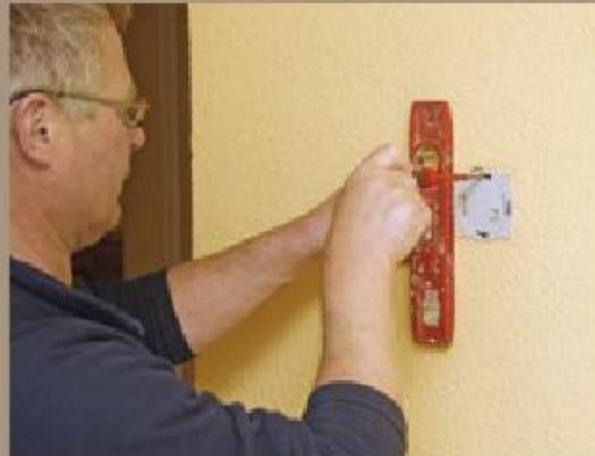
5. Dann wird das Unterputz-Bauteil mit Hilfe einer Wasserwaage passgenau in der Geräte-dose ausgerichtet und festgeschraubt.
