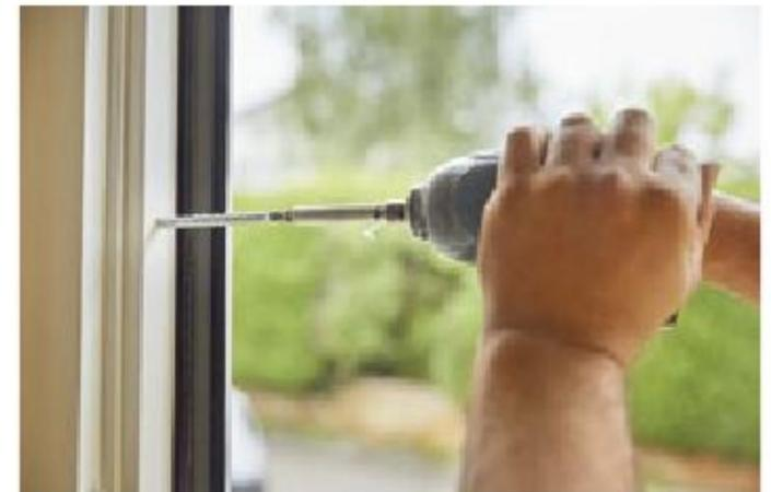
**14.** Die hier verwendeten Rahmenschrauben (Würth Amo III,  $7,5 \times 152 \text{ mm}$ ) ohne Kopf kann man direkt ins Mauerwerk drehen, ohne Dübel setzen zu müssen.
