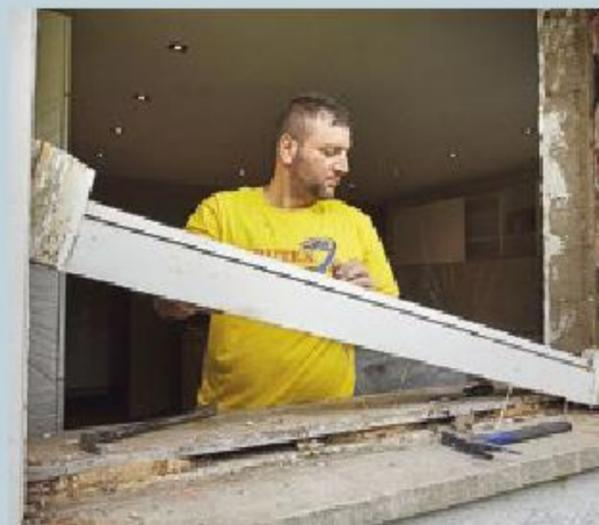
**7. ... dann auch der obere und untere Rahmenschinken** ausgebaut werden können. So wird die Laibung auch am wenigsten beschädigt.
