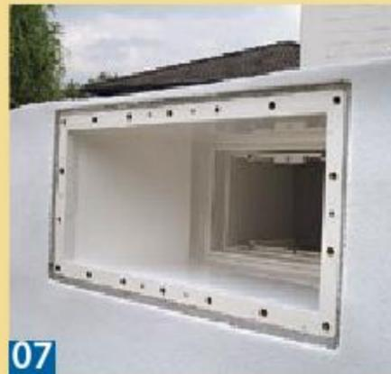
**07** Zur Oberflächenabsaugung dient dann der Skimmerkasten, der oben randnah sitzt und für den die Schaumfolie ausgeschnitten ist.
