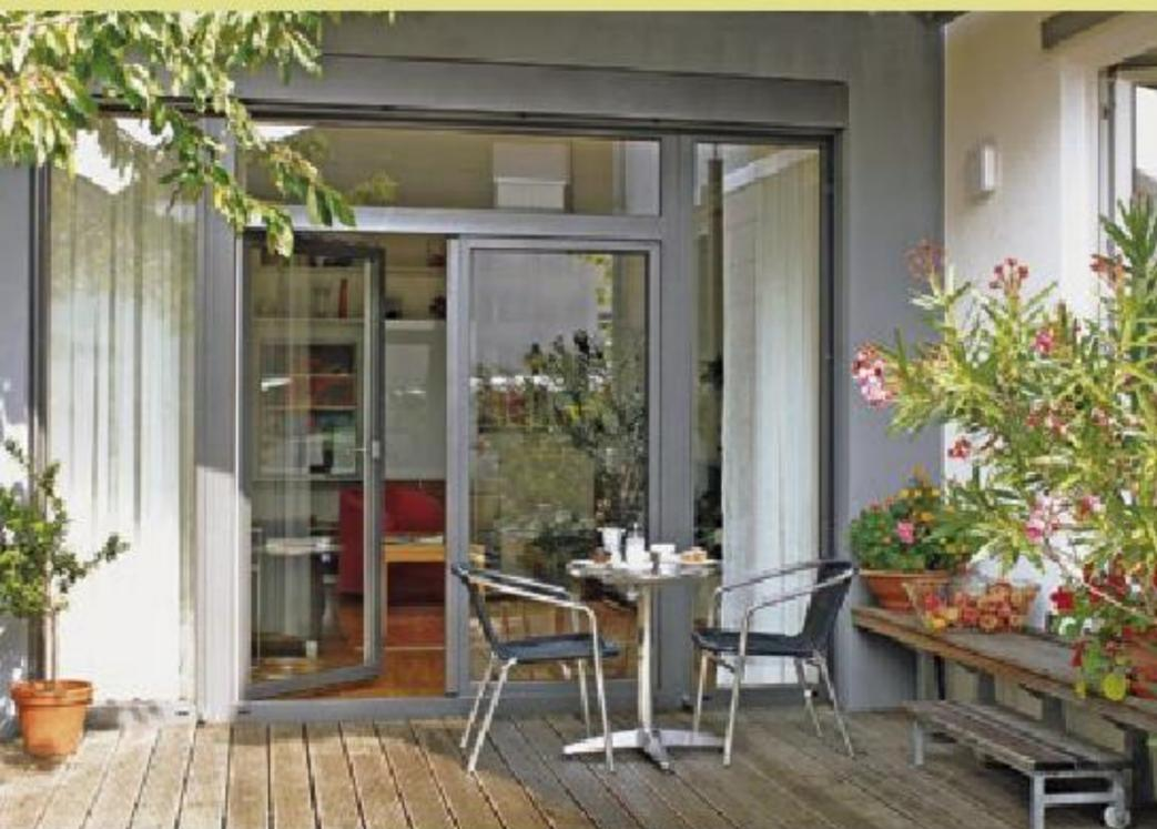
Tür integriert: Die Drehtüren sitzen in einem Festglas-Umfeld, bestehend aus Oberlicht und sturzhohen Seitenteilen. Die Aluminiumkonstruktion weist eine unempfindliche Feinstruktur-Oberfläche auf. [www.gugelfuss.de](http://www.gugelfuss.de)
