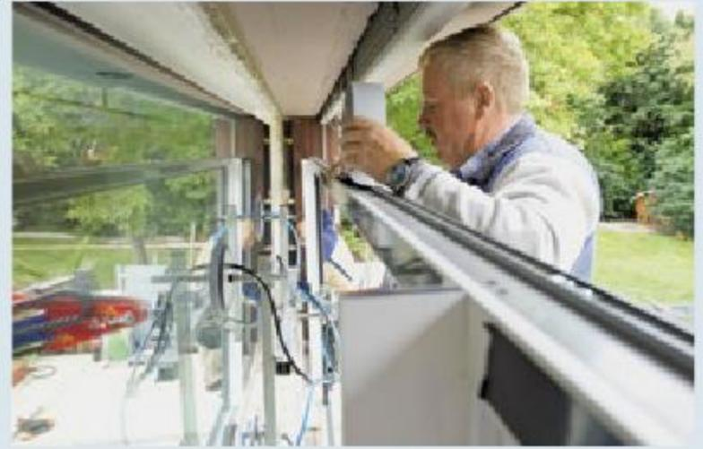
4. Die neuen, energieeffizienten Fensterelemente werden mit Hilfe von Dichtbändern fachmännisch eingebaut.
