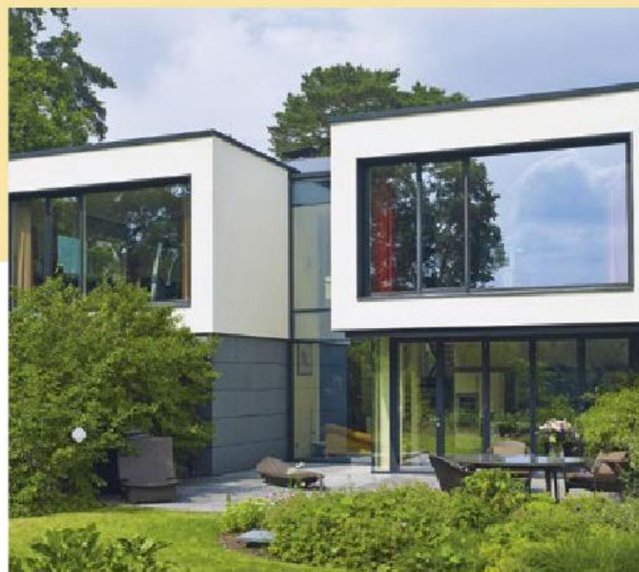
Bei allem Wunsch nach größtmöglicher Transparenz sollte hier auch bei den Fenstern nachhaltige Technik zum Einsatz kommen – das hoch isolierte Fassadensystem Schüco FW 50+.HI als Structural Glazing-Fassade und Schüco AWS 70 WF.HI mit extraschmalen Profilen. Als Sonnenschutz sind auf der Südseite außenliegende Raffstores verbaut. [www.schueco.de](http://www.schueco.de)
