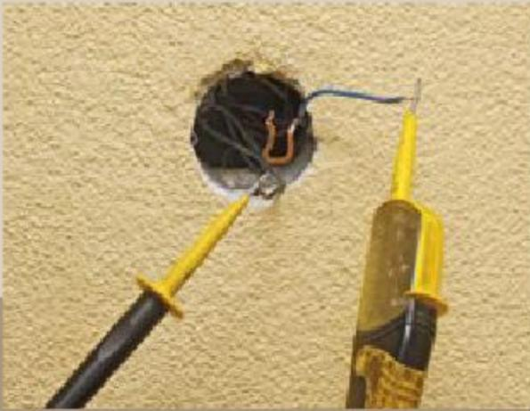
1. Vor der Montage prüft der Elektriker zunächst einmal die entsprechende Anschlussleitung und schaltet diese danach zur Sicherheit frei.
