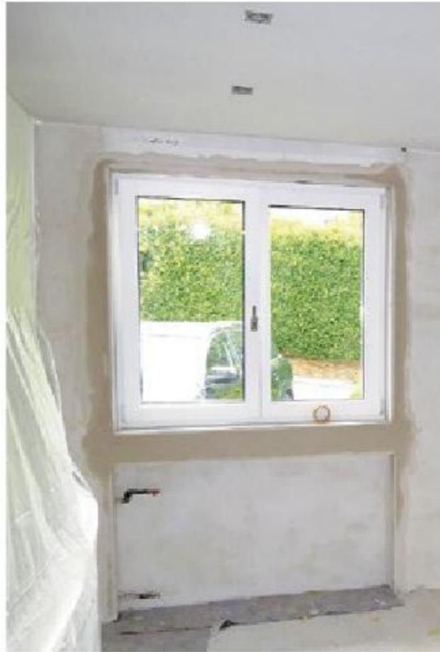
24. Wenn dann die letzten Gips- bzw. Putzarbeiten abgeschlossen sind, sind die neuen Fenster fertig eingebaut. Auf einen Sims hat man hier verzichtet.
