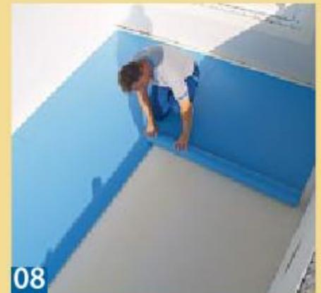
**08** Die vorgerichteten Bahnen der speziellen Schwimmbadfolie werden über Boden und Wände faltenfrei ausgelegt. Erst ist die ...
