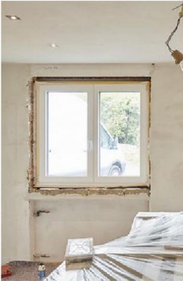
23. Innen müssen jetzt noch die Wunden an der Laibung geheilt werden und der leere Rollladenkasten wird noch dicht mit Dämmstoff verfüllt.
