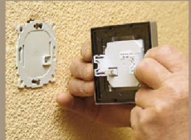
6. Jetzt wird das Bedienteil in die Buchse für den Steckkontakt aufgesetzt. Damit sitzt das Element auch schon fest, denn es genügt ein ...
