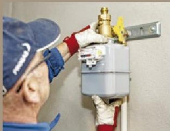
5. Innerhalb des Hauses wird der Gaszähler mit dem Hauptabsperrventil angebracht und mit der Versorgungsleitung verbunden.
