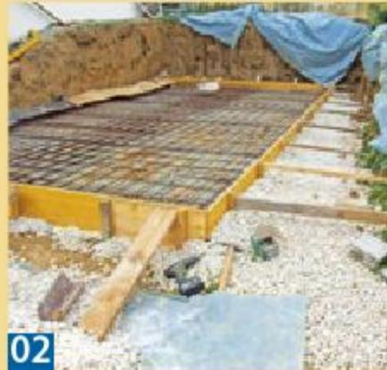
**02** Innerhalb der Schalung dann eine weitere Mattenlage einbauen und beide Matten mit Bügeln im Ein-Meter-Abstand verbinden.
