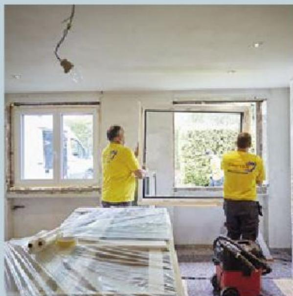
**10. Das erste neue Fenster** sitzt bereits (links), der zweite Rahmen wird in die danebenliegende Wandöffnung gesetzt. Zuvor hat man ...
