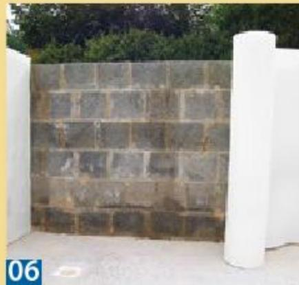
**06** Sechs Reihen hochgemauert ergeben dann 1,5 m Höhe. Dann kleidet man Boden und Wände mit der isolierenden Schaumfolie aus.
