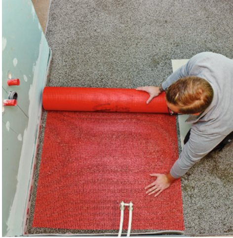
12 Auf der erhärteten Leichtschiüttung wird dann das Panzergewebe als Armierungslage lose ausgerollt.
