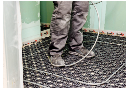
22 ... in die Noppenfolie mit geeignetem Verlegeabstand eingeklickt.
