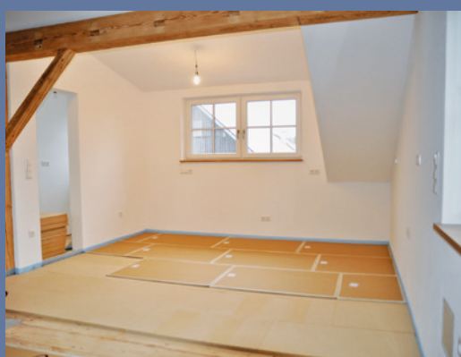
5 Alles bleibt trocken, denn in diesem Altbau sollte keine unnötige Feuchtigkeit durch Nassbautechniken eingetragen werden. Die erste Plattenlage liegt im versetzten Verbund.
