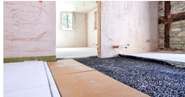
Präzise verdichtet: Die Ummantelung mit Bitumen sorgt bei Bituperl dafür, dass sich die Perlit-Granulate zu einer belastbaren Fläche verkleben und verkrallen.
