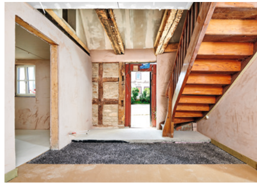
Altes Holz trifft neuen Boden: Im Eingangsbereich konnten die Treppe und viele Balken erhalten bleiben.
