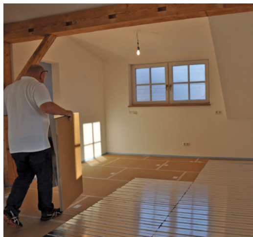
7 Damit ist eine solide Grundlage geschaffen für die Fußbodenheizung. Die Aluminiumbleche mit ihren Kanalführungen dienen als Basis und werden entsprechend verlegt.
