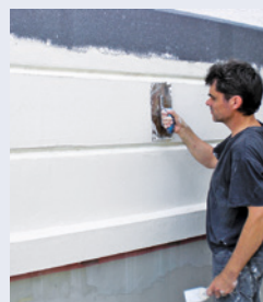
D ... Eckwinkelprofil eingebettet. Die Armierungsschicht gut durchhärten lassen, danach die Deckschicht aufziehen.
