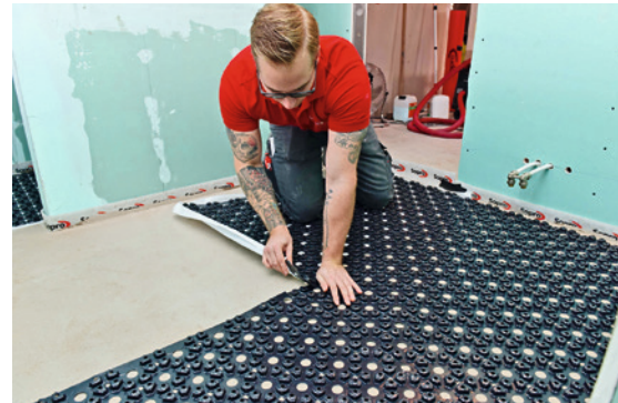
19 Die selbstklebende Kermi x-net C15-Noppenfolie wird nun auf dem Untergrund verklebt.
