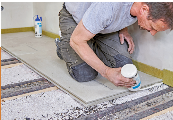
12 Die Verlegung der Elemente zum Unterbau hin erfolgt schwimmend. Nur an den Nut/Feder-Verbindungen wird sorgfältig mit Systemkleber gearbeitet. Rundum eine durchgängige Raupe aufziehen, unten und auf der Feder des ...
