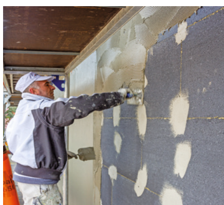
30 Im nächsten Schritt den Armierungsmörtel mit der Zahntraufel großflächig in der Breite eines Gewebestreifens aufziehen und darin das Armierungsgewebe faltenfrei ...
