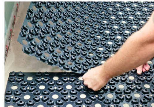
20 Die Noppen der Platten lassen sich überlappend ineinander in Verlegerichtung einlegen.
