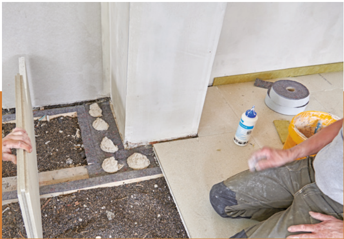
15 An der Wand dürfen die Elemente nicht mehr als 30 Millimeter über das letzte Auflager auskragen. Wo keine Unterfangung gegeben war, setzten hier die Verleger Batzen aus Ansetzgips und hatten so eine Unterstützung geschaffen.
