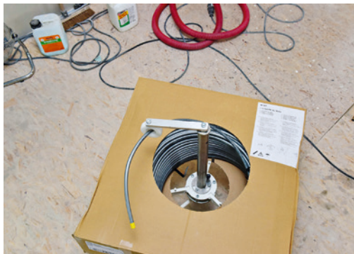
21 Das 12-mm-Systemrohr von Kermi wird in die Abrollvorrichtung eingelegt und anschließend ...
