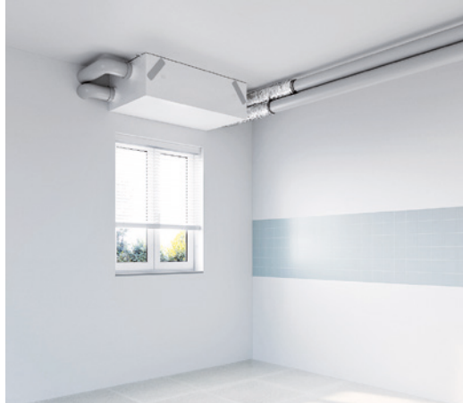
Im Rahmen einer Küchensanierung wurde hier ein flaches Lüftungsgerät im neu gestalteten, abgehängten Deckenbereich montiert. Unterhalb des Lüftungsgeräts befindet sich eine unauffällige Revisionsöffnung für Wartungsarbeiten. www.kermi.de
