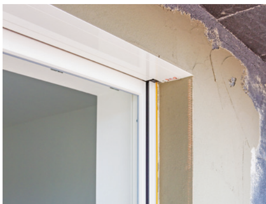
29 ... Diagonalgewebearmierungstreifen im Armierungs-mörtel eingebettet. Damit sind die Vorbereitungen abge-schlossen.
