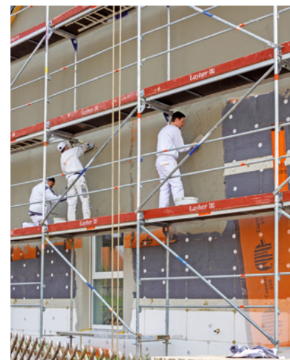
32 ... an die Ränder nach links und rechts mit der glatten Seite der Traufel fest. Nachdem die erste Lage ...
