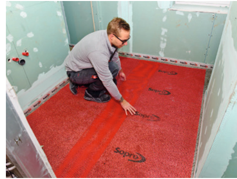
13 Verlegt wird mit einer Überlappung von 50 mm und einem Randabstand von 20 mm.
