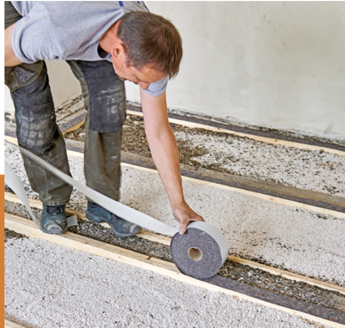
7 Ebenso ganz wichtig: Das Aufbringen eines textilen Trennstreifens auf den Oberkanten der Brettanlaschungen. Denn hierauf verlegt man ja dann die Estrichelemente und die sollen ja schallentkoppelt liegen.
