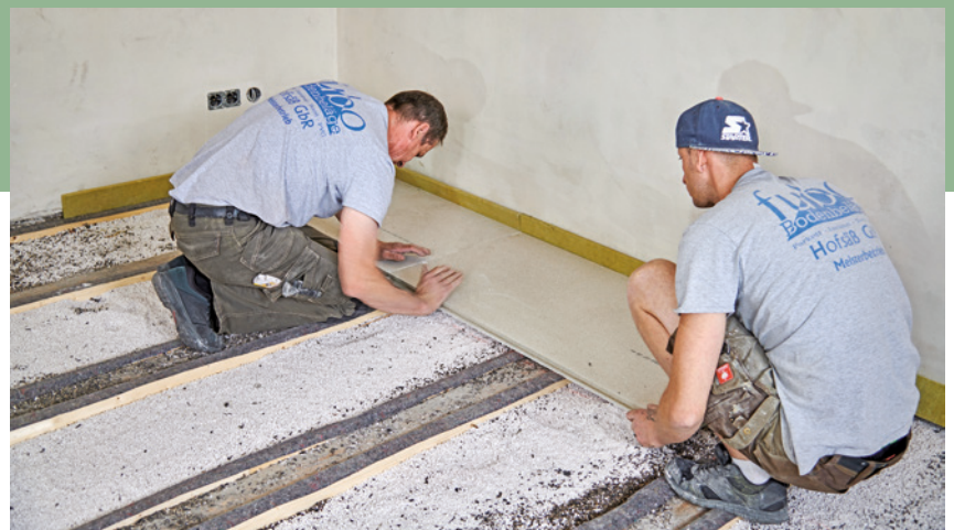
11 Die nächste Platte wird – nach Leimangabe – dicht an die bereits liegende geschoben und die Feder ganz eingeführt.
