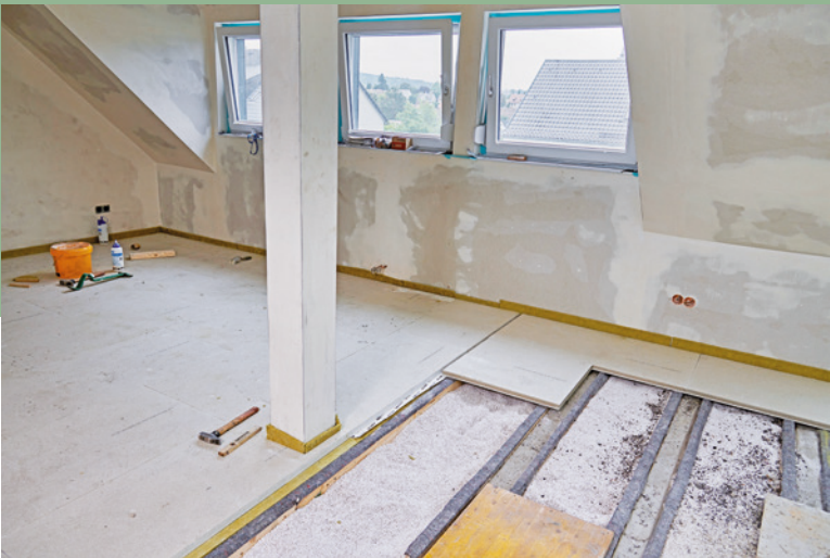
22 In der Folge legt man dann wie gehabt stoßverleimt die wandnahe erste Plattenreihe durch und beginnt die zweite mit dem Reststück der Vorreihe. Auch dieses erste Stück wird mit breitem Fugenabstand zur linken Teilfläche verlegt.
