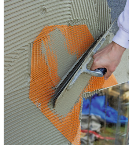
28 Weiterhin werden auf der Dämmplattenoberfläche zur Rissvermeidung in allen Eckbereichen sogenannte ...
