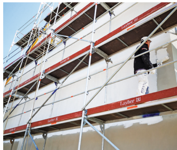
34 Nach dem vollständigen Aushärten der Armierungsschicht wird ein Grundierungsanstrich im Farbton des späteren Putzes aufgetragen.
