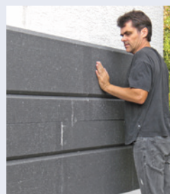
B ... Verfahren an die Fassade kleben. Die Platten untereinander mit einer Richtlatte fluchtgerecht ausrichten.
