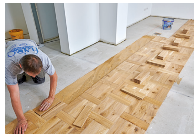
47 Und so langsam entwickelt der Holzboden seine eigene Dynamik. Das Flechtmuster wird schon deutlich erkennbar.
