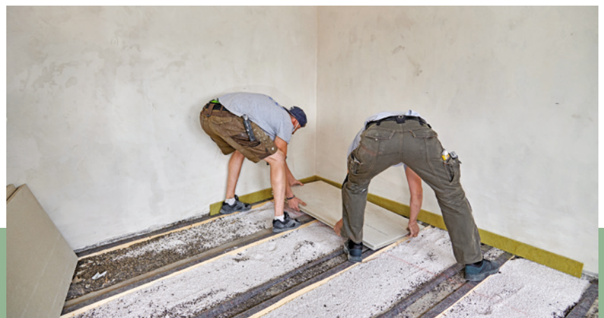
10 Die erste Platte wird also ganz ins linke Raumeck geschoben, die Nuten zeigen dann nach vorne und rechts. Eine Platte wiegt knapp 40 kg, sodass es zu zweit leichter ist, die Elemente zu verlegen. Darauf achten, dass keine Körner aus der Schüttung auf die Textilstreifen kommen.
