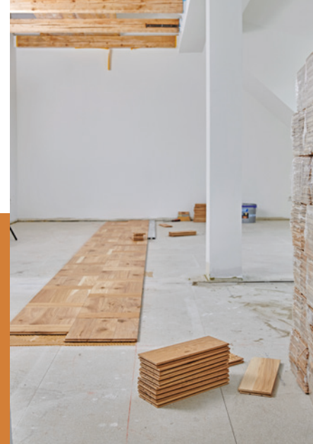
42 Die zwei ersten Reihen sind verklebt, nun arbeitet man in die Gegenrichtung.
