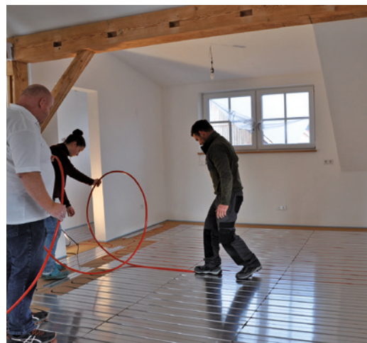
8 Die Fläche ist fertig. Nun können die flexiblen Wasserleitungen in die Vertiefungen gedrückt werden. Ein Verlegeplan hilft bei der Ausführung bzw. der Heizkreisordnung.
