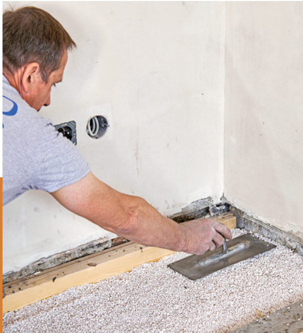
6 Das Material in den Zwischenfeldern wird etwas verdichtet und gleichmäßig abgezogen. Das kann man auch lagenweise machen. Damit lässt sich der Schallschutz noch ein wenig verbessern.
