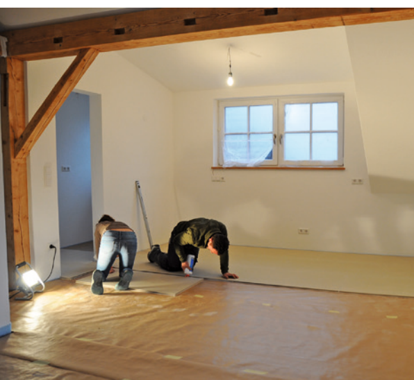
11 Bahnenweise reiht man die Elemente aneinander und verklebt sie mit einem speziellen Kleber. Reststücke der Vorreihe dienen als Startelement für die nächste Reihe.
