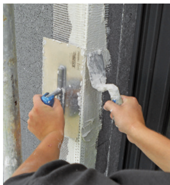
26 Zur weiteren Vorbereitung der Armierungsschicht an den Hausecken, Fensterlaibungen und an den Stürzen ...
