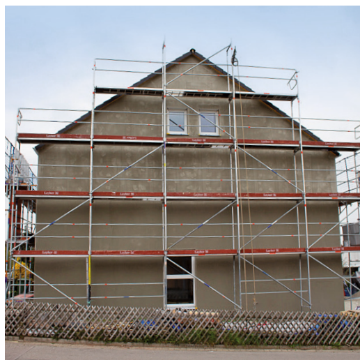
33 ... Armierungsmörtel aufgezogen wurde und das Gewebe noch gut erkennbar ist, wird sofort danach die Deckschicht „frisch in frisch“ aufgezogen.
