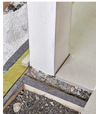
18 ... zu verlegen, mit entsprechendem Fugenabstand und schmalen Reststeg zur nächsten Platte.
