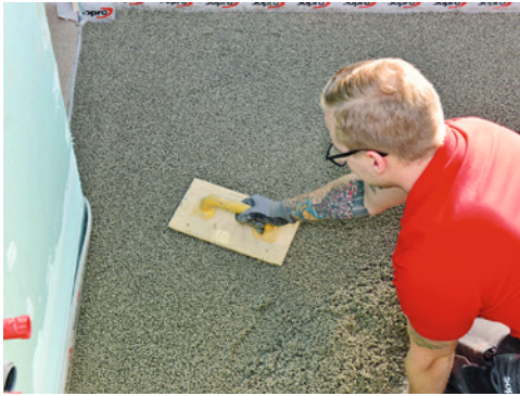
11 Mit einem Reibebrett wird die gebundene Schüttung nochmals händisch verdichtet.
