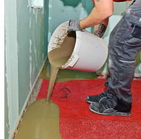
14 Die Armierung wird 3 mm dick mit Fließspachtel eingegossen. So wird ein glatter ...
