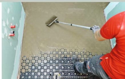
26 Auch hier wird noch mit der Stachelwalze durchgerollt. Nach Trocknung ist die Fläche dann belegereif.
