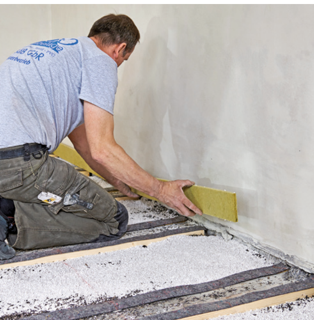
9 Mit frei aufgestellten Mineralwolle-Randdämmstreifen sorgt man noch für einen 10 mm breiten Wandabstand. Die Estrichplatten können dann daran direkt anstoßen.
