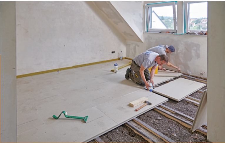
14 Hier in der ersten größeren Fläche erkennt man gut, dass zum einen die Plattenreihen mindestens um 30 Zentimeter versetzt angeordnet sind, zum anderen, dass fließende Stöße möglich sind, also Plattenstöße ohne direkte Unterfangung.
