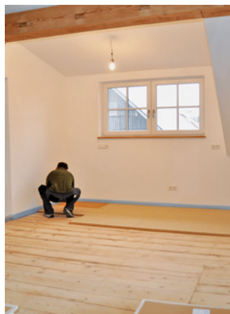
3 ... Schritt zur Schalldämmung gemacht. Es folgt die Verlegung der formstabilen Holzweichfaserplatten.
