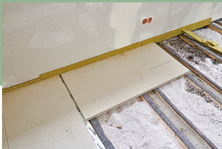
21 Auf einem Gleitpapierstreifen (hier weiß), der nach unten hin entkoppelt, wird die erste Platte mit abgesägter Feder so aufgelegt, dass etwa ein zwei Zentimeter breiter Spalt bleibt (zum Beispiel als Maß ein Richtscheit einlegen).
