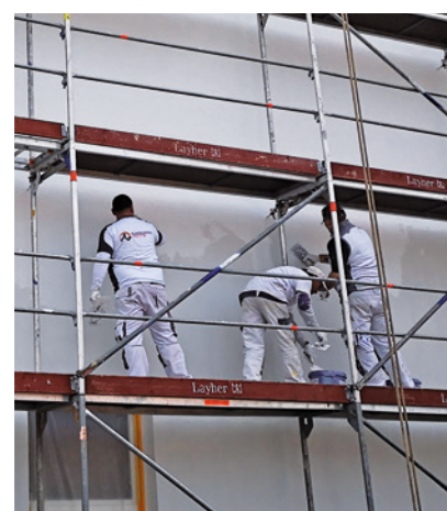
35 Den Oberputz immer im Team in einem Rutsch aufziehen. Arbeitspausen würde man für immer an der Fassade als ärgerliche Übergänge sehen.
