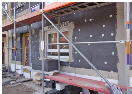
27 ... Eckwinkel mit Anschlussgewebe in Klebemörtel setzen und diese Bereiche sauber glätten. Es dürfen keine Grate stehen bleiben.
