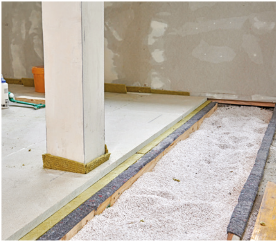
19 Hier sind wir angelangt, wo eine neue Balkenlage beginnt. An der gerade abgeschnittenen Plattenkante müssen nun die nächsten Platten um 90 Grad gedreht verlegt werden.
