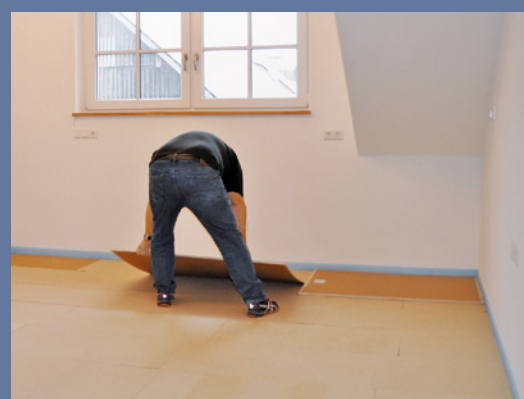
4 Darauf kommt – ebenfalls lose verlegt – eine erste Lage der speziellen Tritt- und Luftschallschalldämmplatten. Die sandgefüllten Elemente haben ein handliches Format.
