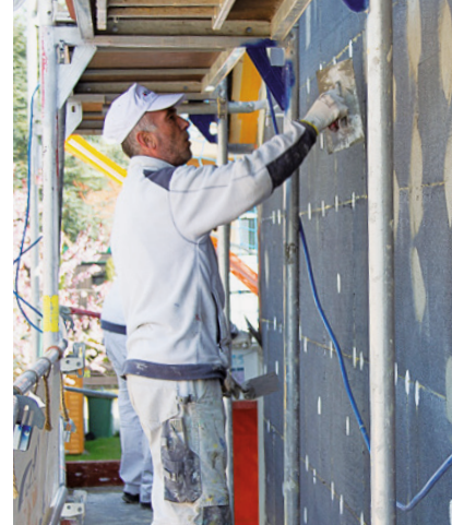
25 ... und vor der Armierung die Oberfläche mit Mörtel eibenen. Die Dübel sind als Teil der Systemkomponenten zugelassen.
