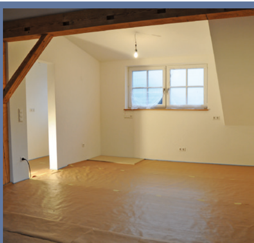
10 ... Trockenestrich aus Gipsfaserelementen sollte sich frei „bewegen“ können. Mit dessen Verlegung beginnt man dann links, da so die Nut-Feder-Verbindung funktioniert.
