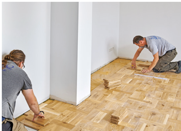
43 Dazu wird auch wieder eine Teilstrecke mit Klebstoff versehen. Hier ist gleich auch ein Wandsegment im Weg.
