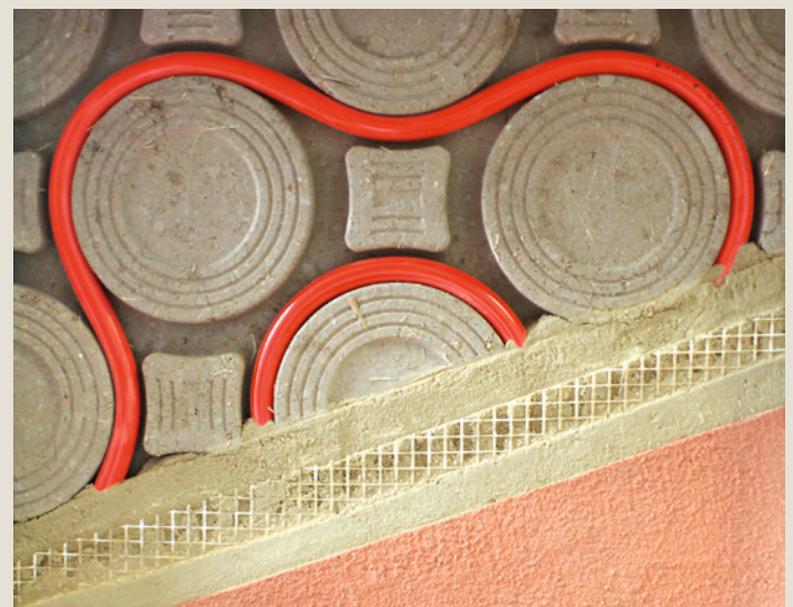
Die Rillenplatten mit den Rohren werden anschließend mit Lehmputz und Lehmfarbe beschichtet.
