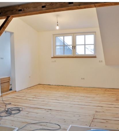
1 Nachdem Dachschräge, Wände und Decken renoviert waren, ging es an den Bodenaufbau. Der Riemenboden ...
