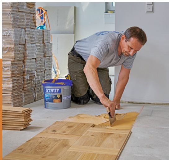
43 Dazu wird auch wieder eine Teilstrecke mit Klebstoff versehen. Hier ist gleich auch ein Wandsegment im Weg.
