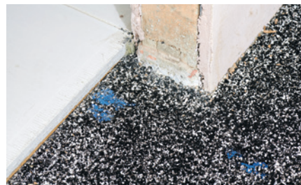
Präzise verdichtet: Die Ummantelung mit Bitumen sorgt bei Bituperl dafür, dass sich die Perlit-Granulate zu einer belastbaren Fläche verkleben und verkrallen.
