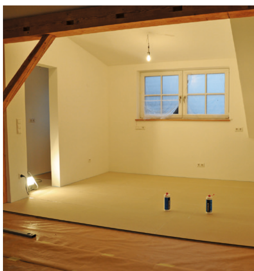
12 Und so vervollständigt sich die neue Estrichfläche recht zügig. Auch hierbei darauf achten, dass die Platten nirgends einen Wandkontakt haben (Schallbrücke!).
