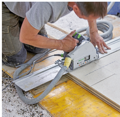
17 Mit der Kreissäge lassen sich auch diffizile Zuschnitte oder Aussparungen erstellen. Hier zum Beispiel geht es darum, eine Platte um eine Stütze herum ...
