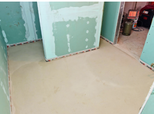
17 Einige Stunden später ist die Masse fest und der weitere Aufbau kann erfolgen.
