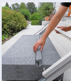
A Die Dämmplatten zunächst mit dem Heißdrahtschneider für die Bossenstruktur profilieren und dann im üblichen ...
