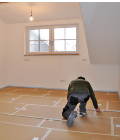
6 Dazu ebenfalls wieder deutlich fugen- und reihenversetzt kommt die zweite Plattenebene zu liegen.
