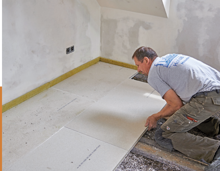
13 ... nächsten Elements. Dann die Platten press stoßen und andrücken. Nur so ist gewährleistet, dass die Plattenkanten versatzfrei durchlaufen für die nächste Reihe. Der Kleber muss oben herausquillen.
