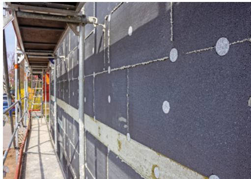
24 Im Binnenland werden bei Ein- und Zweifamilien-häusern zwischen vier und zwölf Dübel pro Quadratmeter Fläche gesetzt. Dübel mit Abdeckplatten verschließen ...
