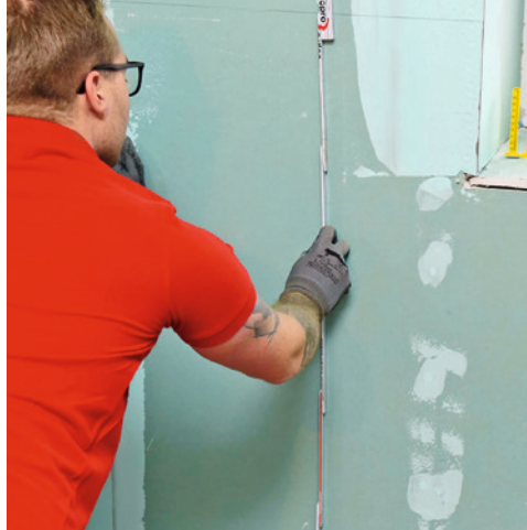
15 ... Untergrund fürs Heizsystem geschaffen. Erneut wird dabei die Höhenlage kontrolliert.
