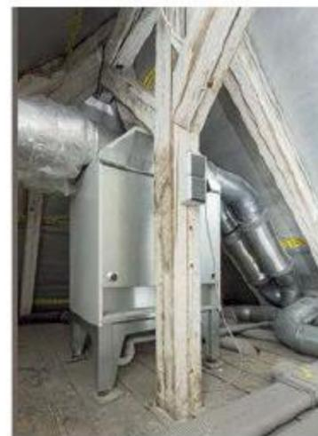
Der Wärmetauscher der kontrollierten Wohnraumlüftung mit Wärmerückgewinnung (Zehnder) sitzt unter dem Dach und steuert ebenfalls seinen Teil zur exzellenten Energiebilanz des Hauses bei.
