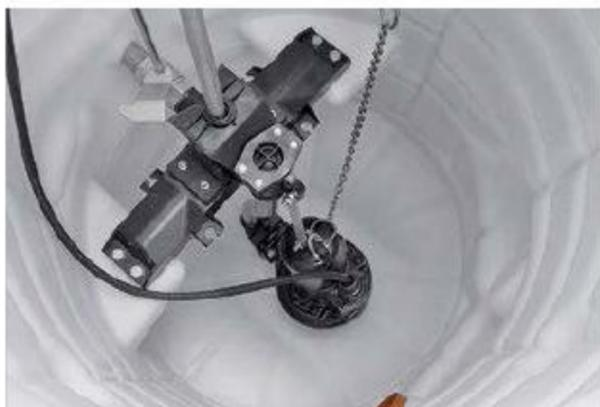
Die Pumpe, die bei einem definierten Was- serstand das Schmutzwasser in die Kanali- sation pumpt, wird in den Behälter gestellt.
