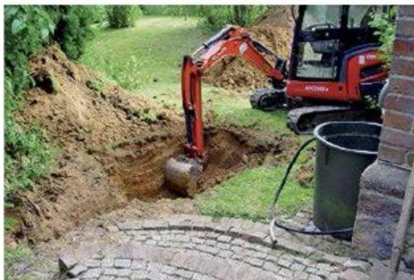
Der Kunststofftank, der das Schmutzwasser sammeln soll, wird unterirdisch aufgestellt. Der Bagger hebt dafür ein Loch aus.
