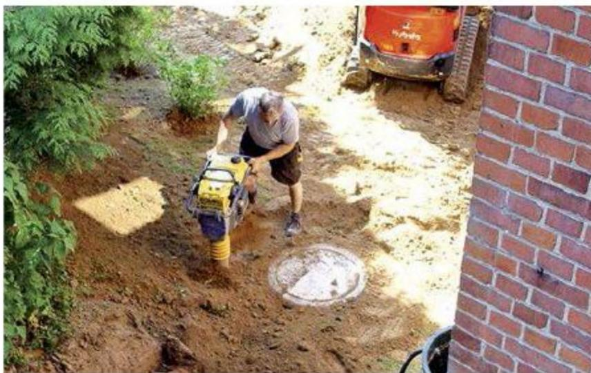
Die Abwasseranlage wurde fachgerecht installiert. Der Hand- werker füllt das Loch wieder mit Erde auf und ebnet die Stelle sorgfältig ein.
