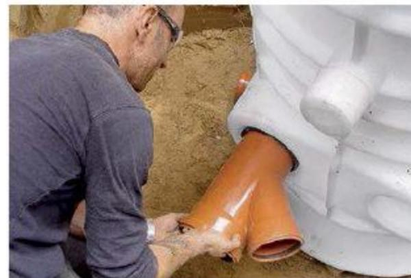
Der Handwerker schließt die Zu- und Ab-laufrohre an den Kunststofftank an und verbindet diese mit Haus und Kanalisation.
