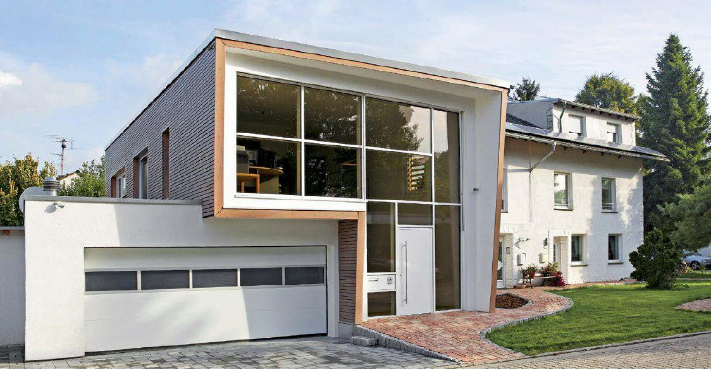
Der Flachdachanbau schließt sich an die Giebelseite der Doppelhaushälfte an.
