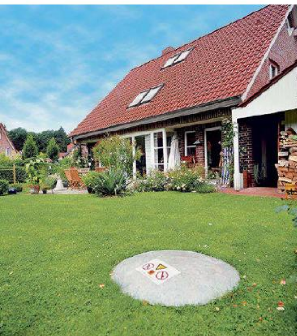
Nach Abschluss der Erdarbeiten ist vom unterirdischen Behälter fast nichts mehr zu sehen. Nur der runde, auch zum Öffnen vorgesehene Domschacht-Deckel ragt noch etwas aus dem Boden. Westfalengas
