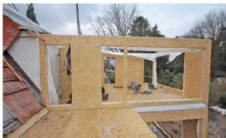
Der Neubau fußt auf einer Holzrahmenbauweise mit einer Art Sandwich-Wandkonstruktion.
