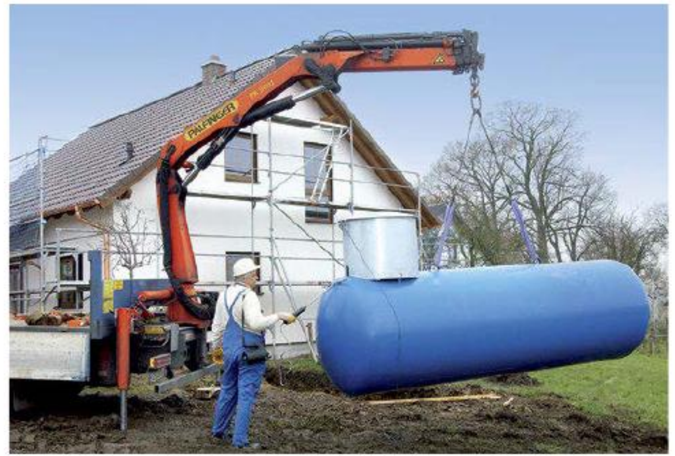
Ein unterirdischer Flüssiggastank wird per Kran in die vorher ausgegrabene Erdgrube gehievt. Dann wird die Gasleitung zur Heizung im Haus verlegt und die Grube verfüllt. Progas
