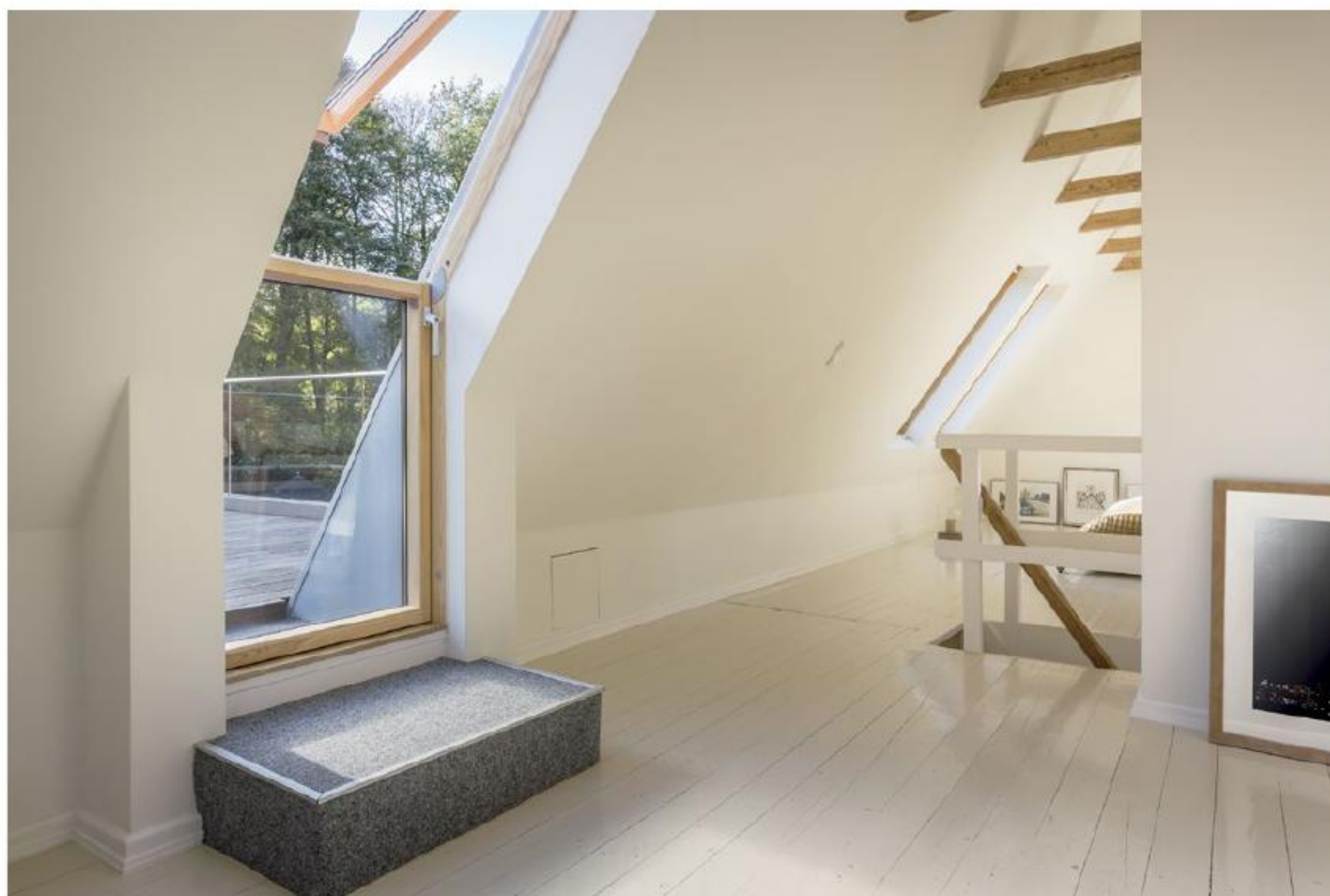
Die beiden Fotos oben zeigen, wie die 18 Quadratmeter große Dachterrasse vor dem Spitzboden über ein Fenster mit spezieller Türfunktion erschlossen wird. Ein kleines Podest erleichtert den Zugang von innen.
