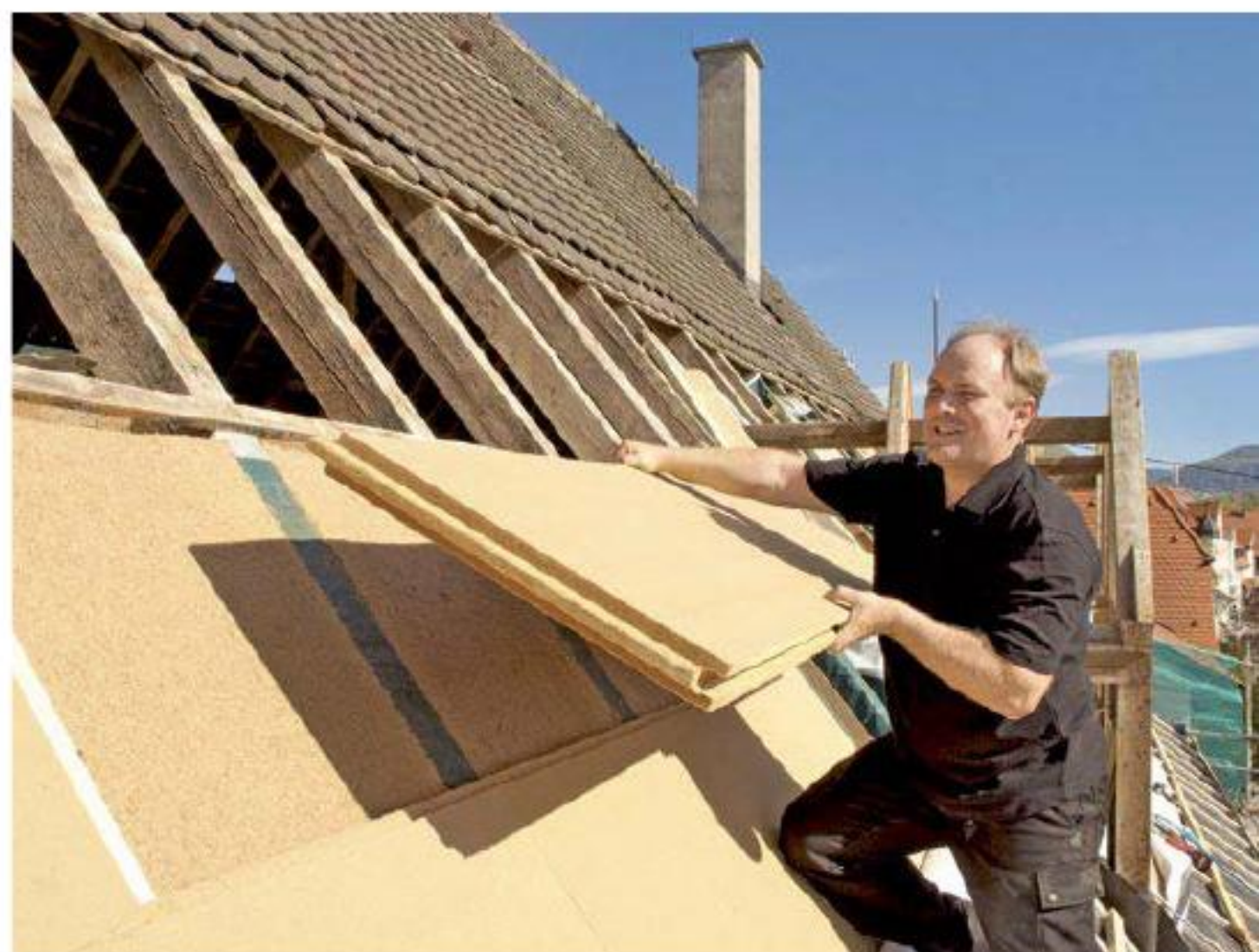
Da eine Holzfaserdämmung Wärme besonders gut speichern kann, hält sie im Winter warm und lässt im Sommer die Hitze erst gar nicht ins Haus. Und: Die Unterdeckplatten sind wasserabweisend. VHD
