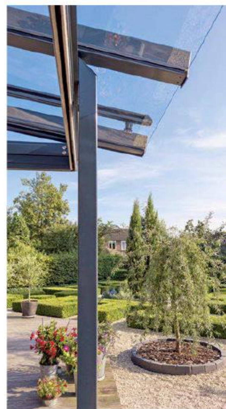
Ein Dachüberstand schützt die seitliche Verglasung der hochwertigen Aluminiumkonstruktion „SDL Atrium plus“.
