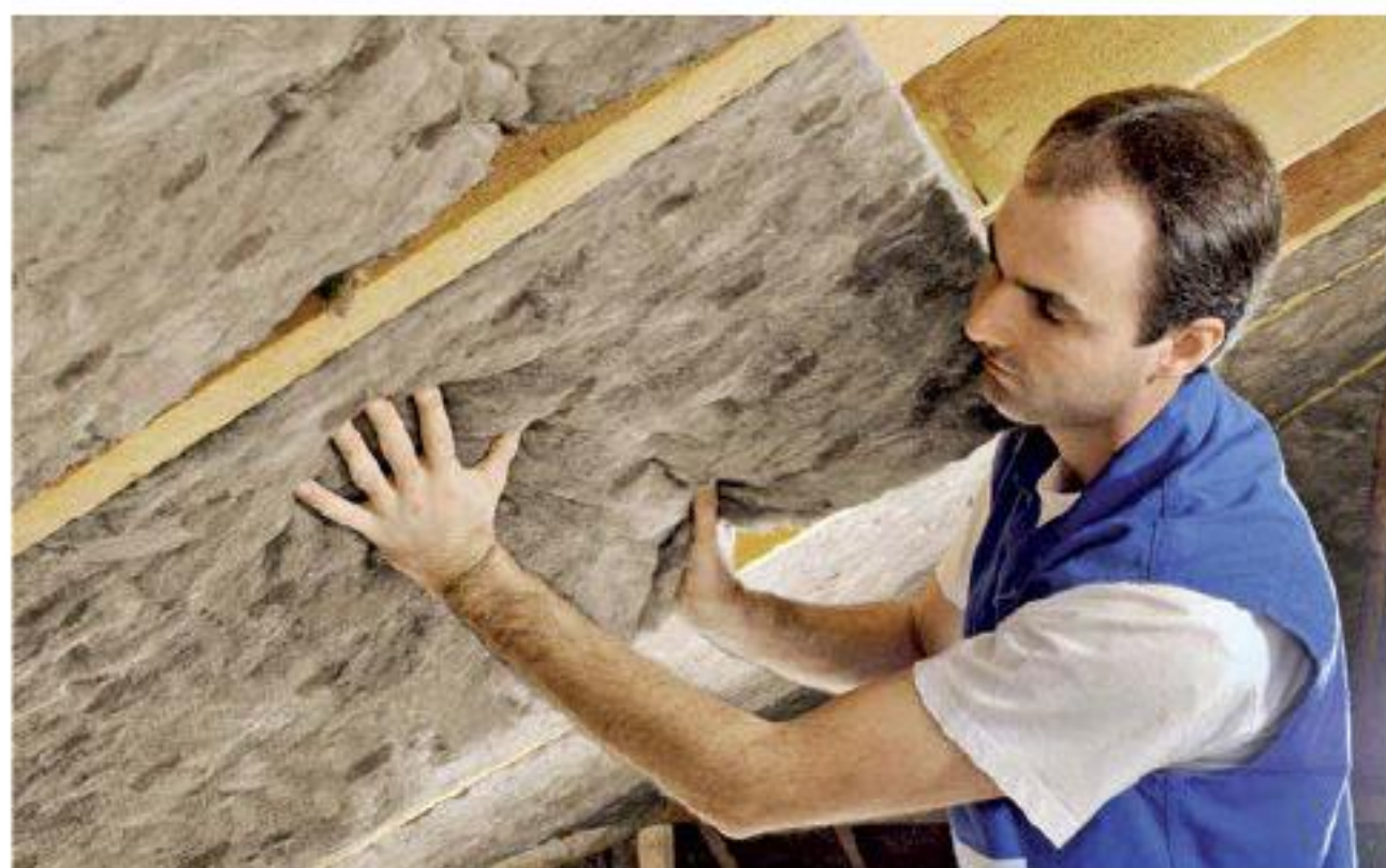
Mit dem Einsatz von elastischen Mineralwolleplatten ist es kein Problem, die Dämmung fugenfrei einzubauen, um eine optimale Wärmedämmung zu gewährleisten. FMI
