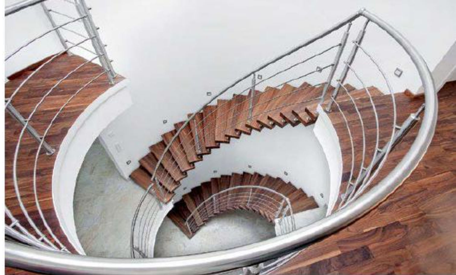
Diese freitragende Treppe mit Stufen aus Nussbaum Massivholz überwindet schwungvoll und anmutig zwei Stockwerke. Kenngott
