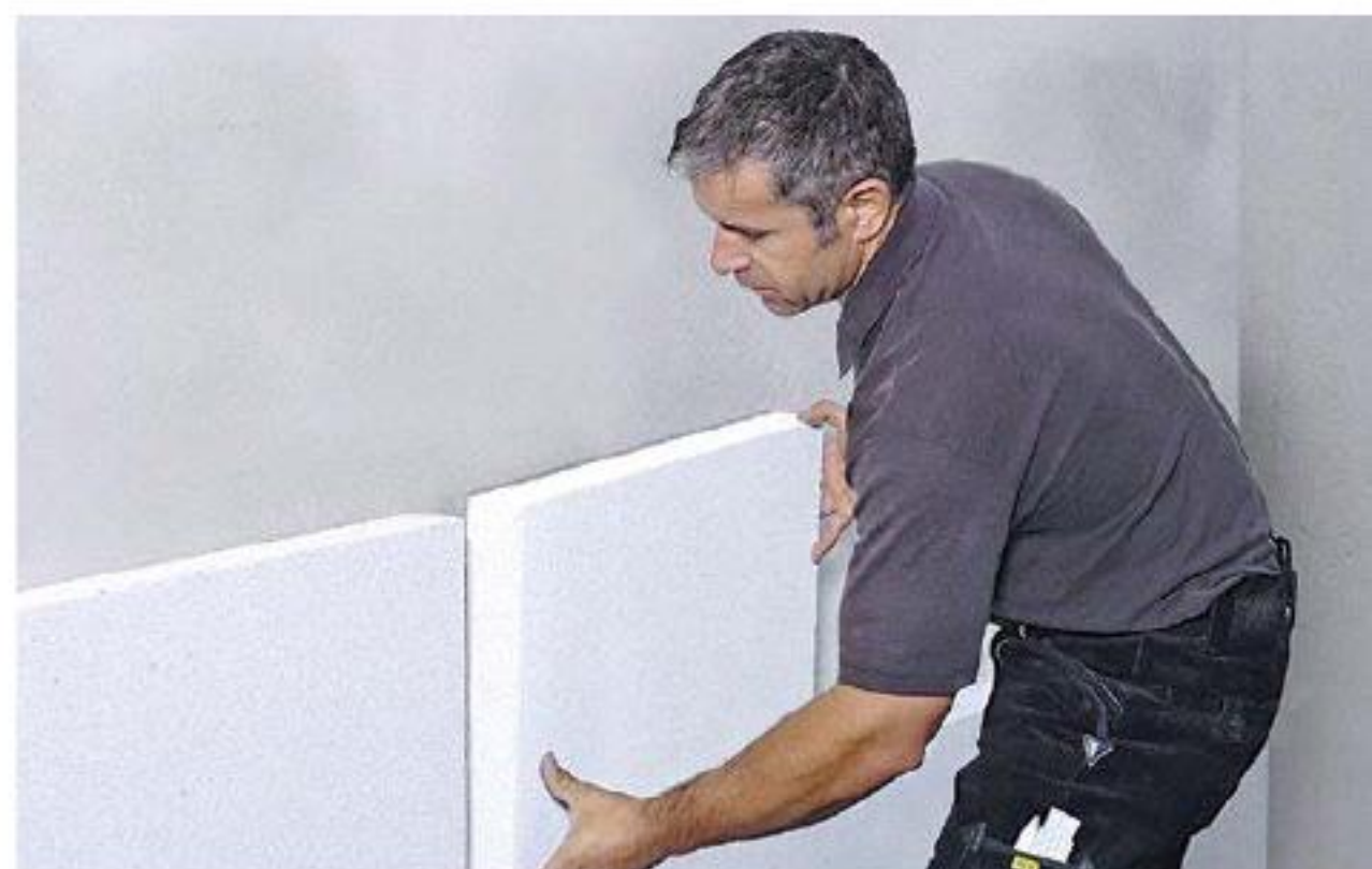
Gutes Diffusionsverhalten und Wärmespeichervermögen bietet die „Ytong Multipor“-Mineralewolleplatte. Hier in der Anwendung als Innendämmung. Xella
