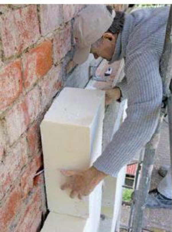
Polyurethanplatten für besonders guten Wärmeschutz. IVPU
