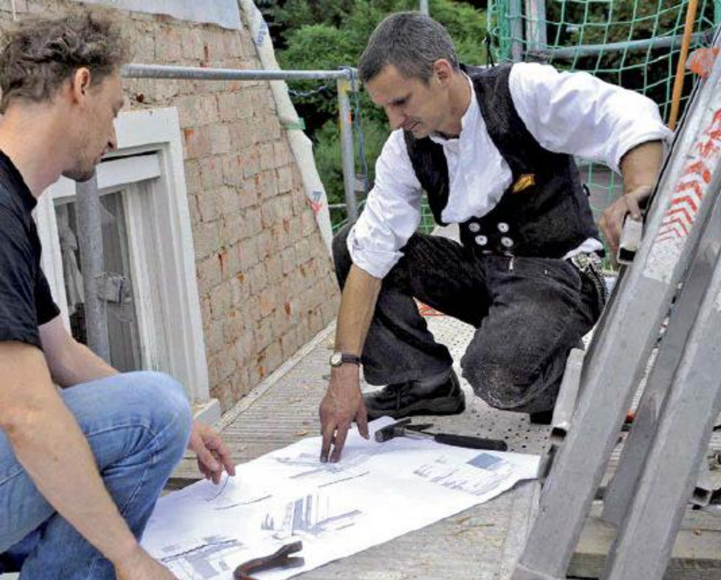
Sanieren ist Sache von Profis: Hier tauschen sich Architekt und der Dachhandwerker über das weitere Vorgehen aus. IVPU
