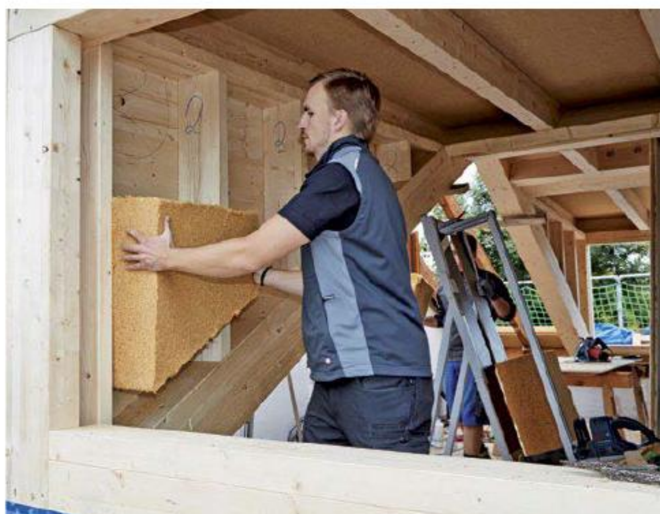
Beim Dachausbau werden oft Gauben eingesetzt. Sie sollten umfassend gedämmt werden, wie zum Beispiel hier mit Dämmstoffen aus nachwachsenden Holzfasern. Verband Holzfaser Dämmstoffe
