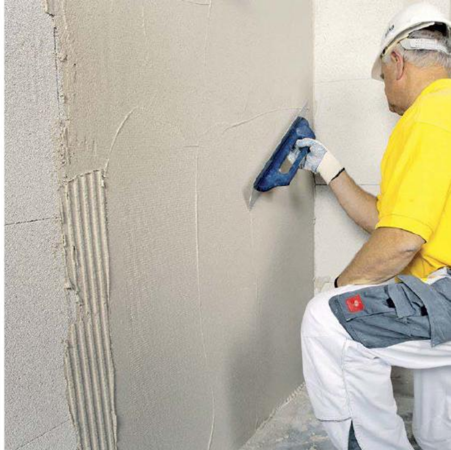
Wo eine Außendämmung entweder nicht möglich oder nicht gewünscht ist, lassen sich Wohnräume mit Multipor-Mineraldämmplatten auch von innen dämmen. Xella
