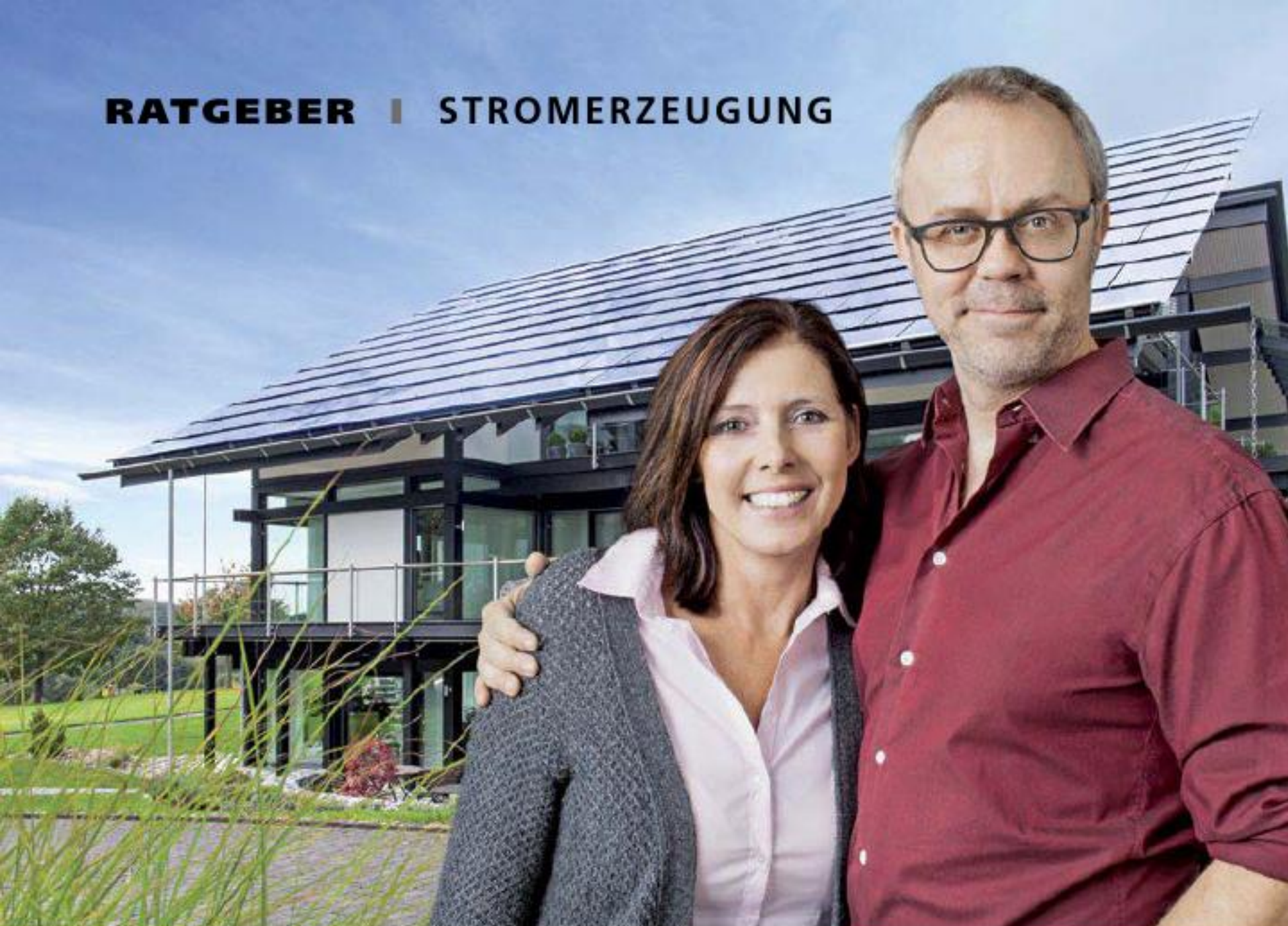
Dachkraftwerk: Die in den Photovoltaikmodulen integrierten Solarzellen erzeugen elektrische Energie aus der natürlichen Sonneneinstrahlung. Bosch Power Tec
