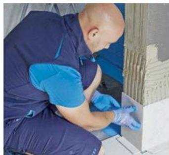
Der Fliesenkleber wird mit der Zahnpachtel aufgezogen und die Fliese anschließend ins Kleberbett gedrückt. Alternativ zu einem Fliesenprofil kann man als Abschluss die Fliese genau auf Gehrung schneiden. Auch das sieht schön aus.
