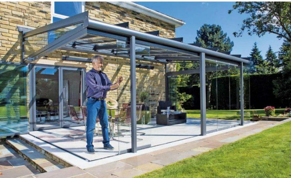
Keine Stolperfalle: Der Übergang von innen nach außen erfolgt über sehr flache Bodenschienen.
