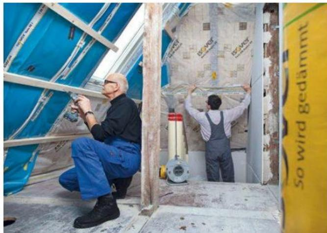
Die Dachdämmung ist eine sehr effiziente Methode, um Wärmeverluste zu verringern. Dabei kann von außen her oder vom Innenraum aus zwischen und unter den Sparren gedämmt werden. KfW-Bildarchiv
