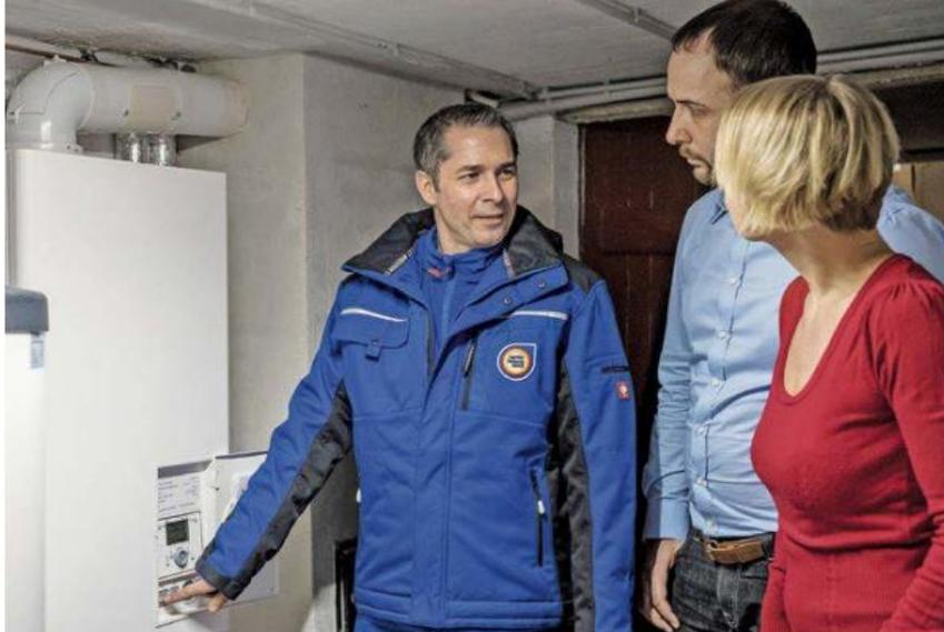
Der Fachhandwerker muss unbedingt die Heizkurve am Kesselregler einstellen, einen hydraulischen System-Abgleich durchführen und die Nutzer in die Bedienung einweisen. Intelligent Heizen
