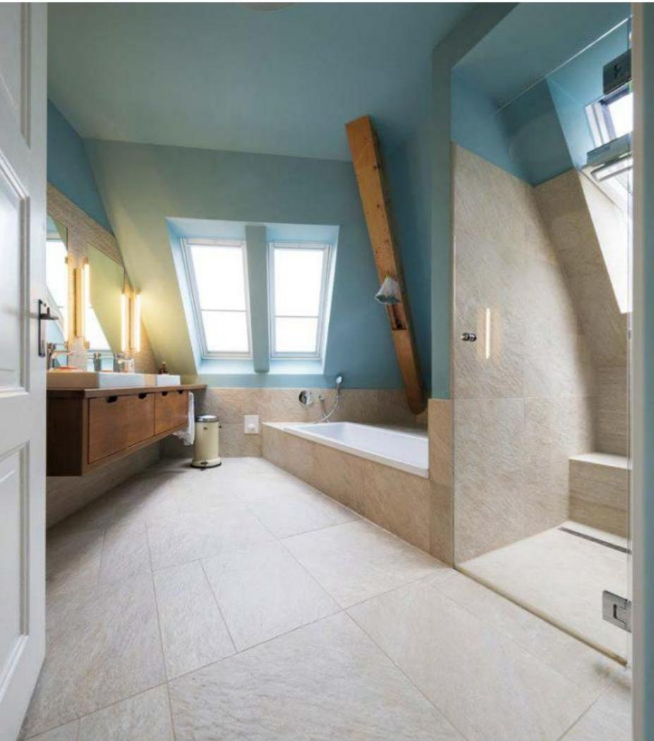
Links: Auch das Bad profitiert von den Dachflächenfenstern, die aus Denkmalschutzgründen an die Sparrenbreite angepasst wurden. In die Dachschräge ist eine bodentiefe Dusche mit Sitzbank und Ablagen integriert.
