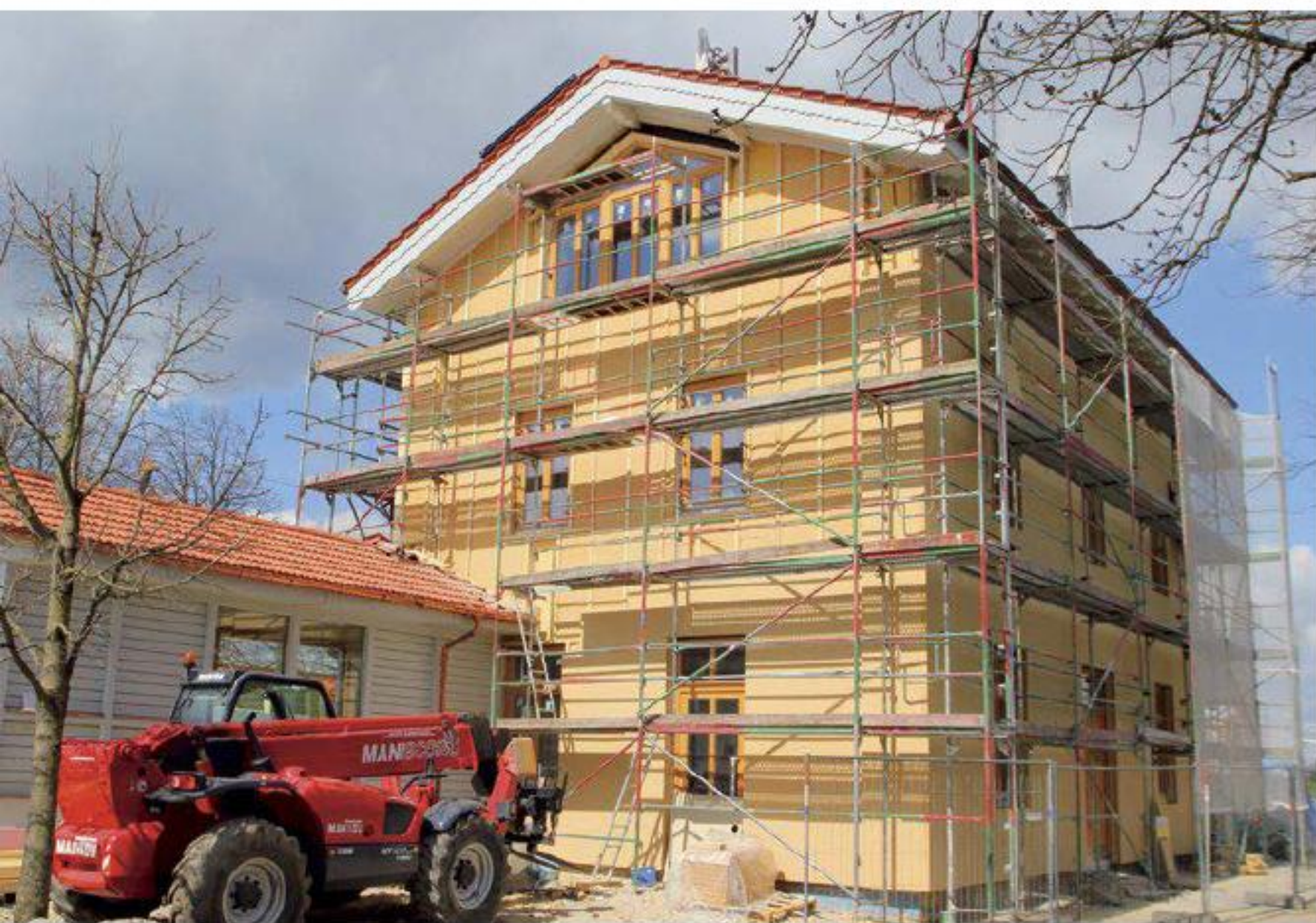
Unterkonstruktion, Gefachdämmung und Dämmplatten am Bahnhof Uffing bestehen aus Holz.
