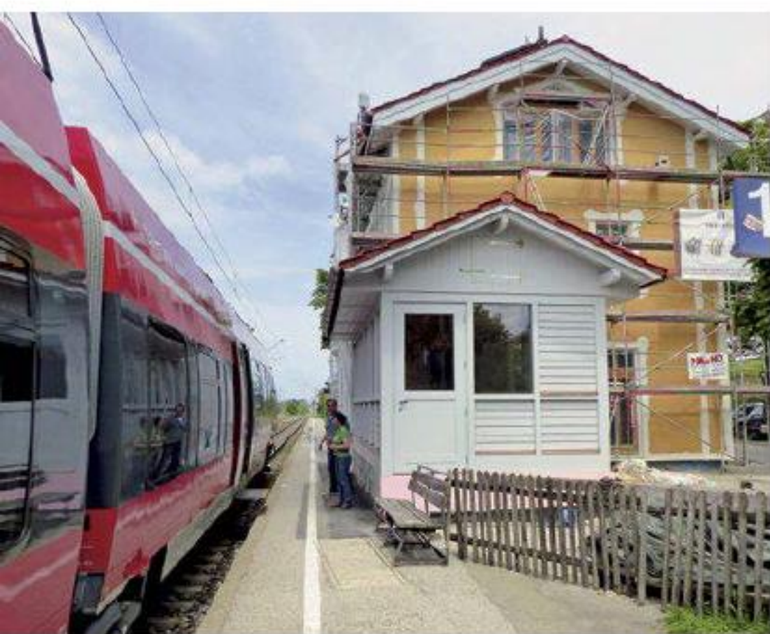
In Uffing am Staffelsee wurde das sanierungsbedürftige Bahnhofsgebäude mit einem Fassadendämmsystem energetisch und optisch auf Vordermann gebracht.
