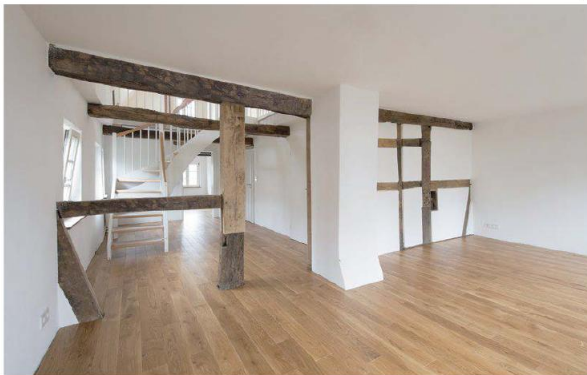
Gute Bausubstanz: Bei der Sanierung wurden Teile der historischen Holzbalkenkonstruktion erhalten – ein Beweis dafür, wie solide das Zimmererhandwerk schon vor langer Zeit gebaut hat.
