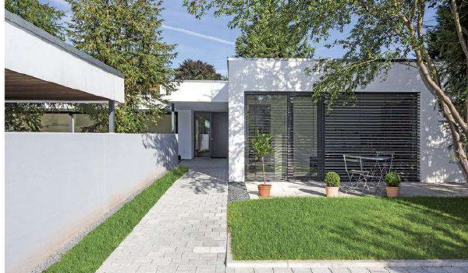
Das Arbeitszimmer – jetzt mit Terrasse – wurde im Zuge der Modernisierung um vier Meter in den Garten vorgeschoben.
