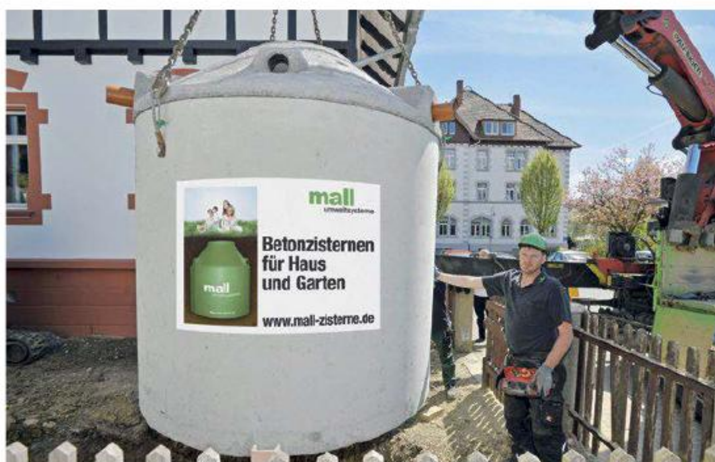
Die Zisterne wird direkt vom Lieferfahrzeug in die vorbereitete Baugrube versetzt. Anschließend kann das Aushubmaterial wieder zum Verfüllen verwendet werden. Mall
