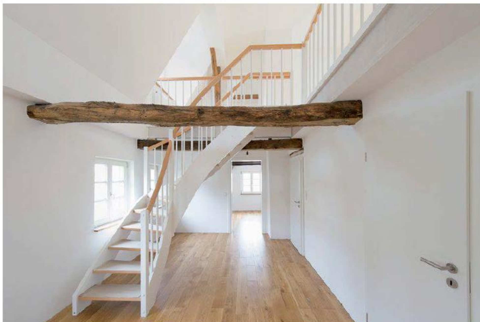
Das Fachwerkhaus erstrahlt auch innen in neuem Glanz. Da das Denkmalamt vorschrieb, die historische Fassade zu erhalten, entschieden sich die Bauherren für eine Innendämmung.
