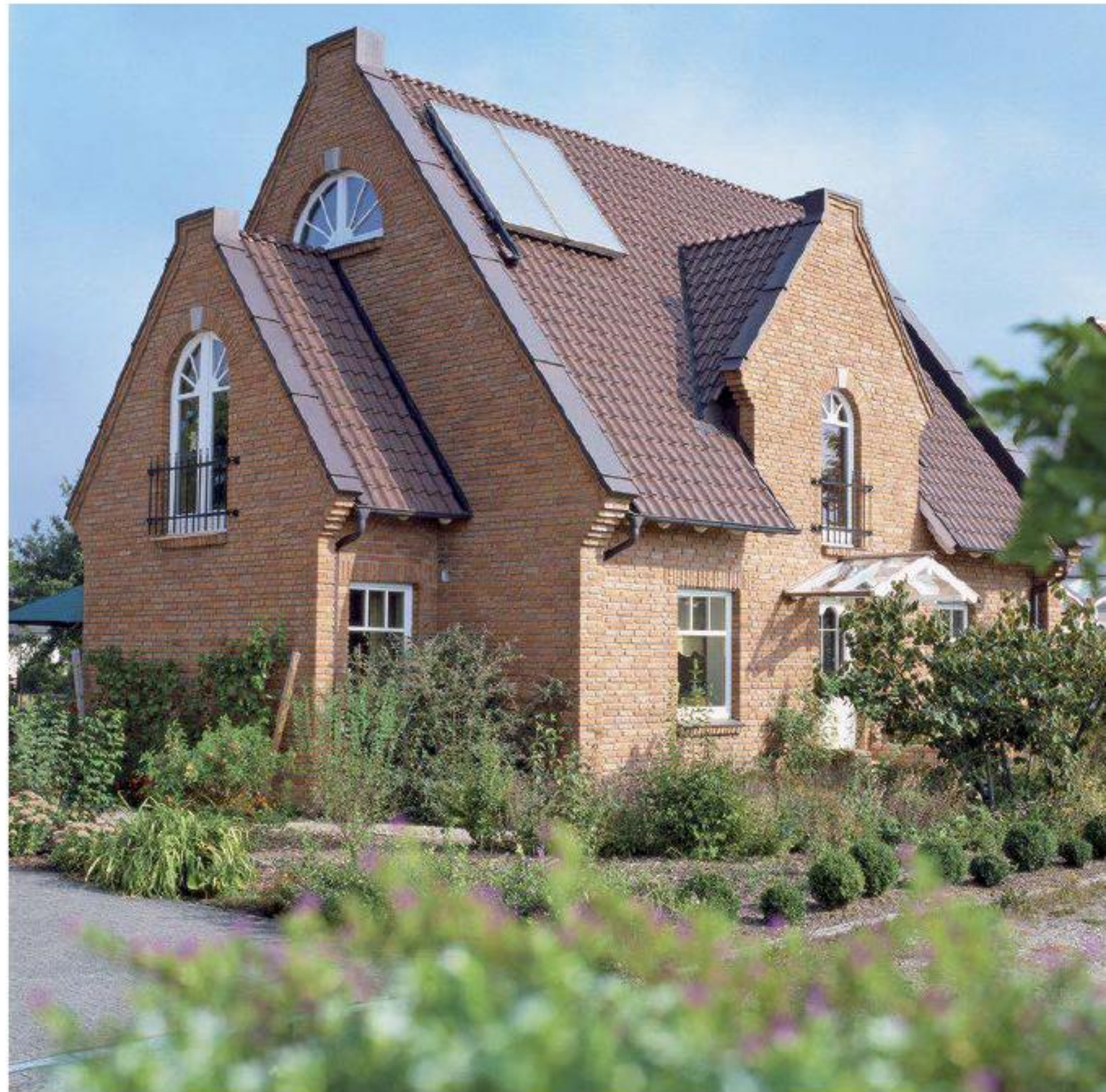
Die neue, von den Hausbesitzern als Herzensangelegenheit bezeichnete Fassade besteht durchweg aus alten, komplett recycelten Vormauerziegeln.
