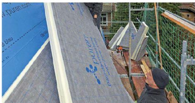
Auf der Luftdichtheitsebene verlegen die Handwerker die relativ leichten Dämmelemente, die einfach zugeschnitten werden können.
