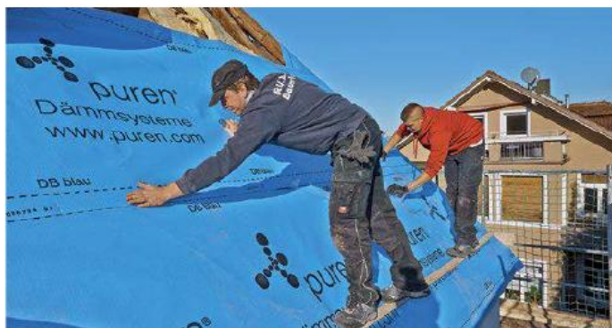
Auf den Sparren werden Folien verlegt, die die Luftdichtheitsebene darstellen. Sie werden an den Überlappungen miteinander verklebt.
