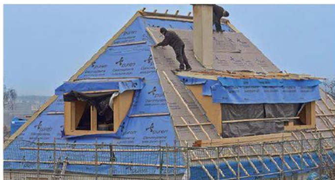
Zug um Zug wird das Dach gedämmt. Die Dämmelemente aus Polyurethan-Hartschaum hüllen den Dachstuhl ein.
