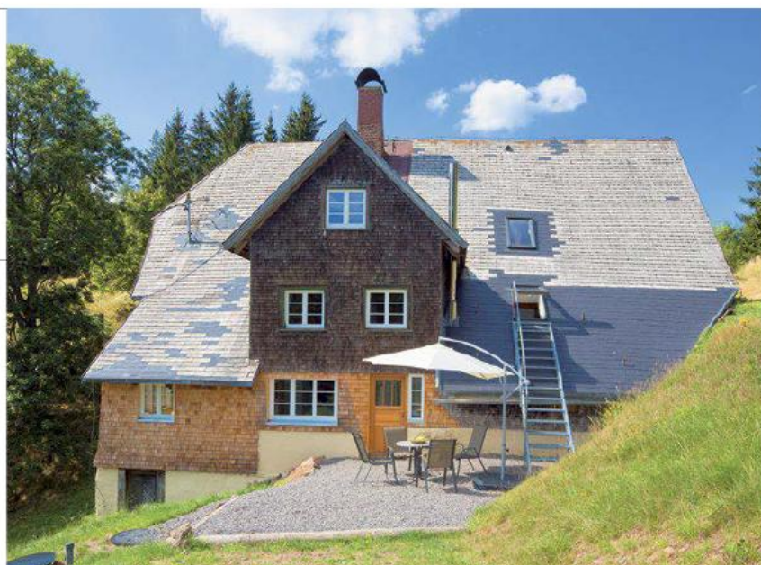
Neue Schwarzwälder Schindeln aus wasserresistenter Weißtanne an der Fassade unterstreichen den regional-typischen Charakter des ehemaligen Bauernhofes.
