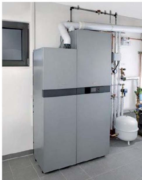
Brennstoffzellen-KWK-Systeme haben einen hohen elektrischen Wirkungsgrad. Derzeit gibt es nur wenig verfügbare Produkte, wie das „Vitocalor 300-P“ (750 Watt elektrisch) mit zwei integrierten Speichern. Viessmann
