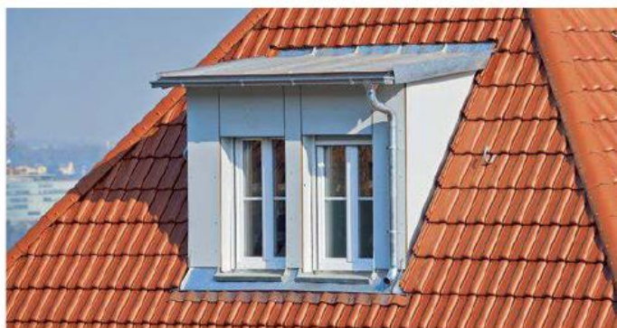
Blick auf die neue Dachfläche mit Gaube. Nach der Sanierung bietet das Dachgeschoss des Eigenheims einen hohen Wohnkomfort.
