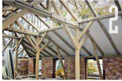
Imposante Struktur: Die Dämmplatten werden direkt auf dem Gebälk verlegt und bilden in den Zwischenräumen verputz-, streich- oder tapezierbare Raumflächen.
