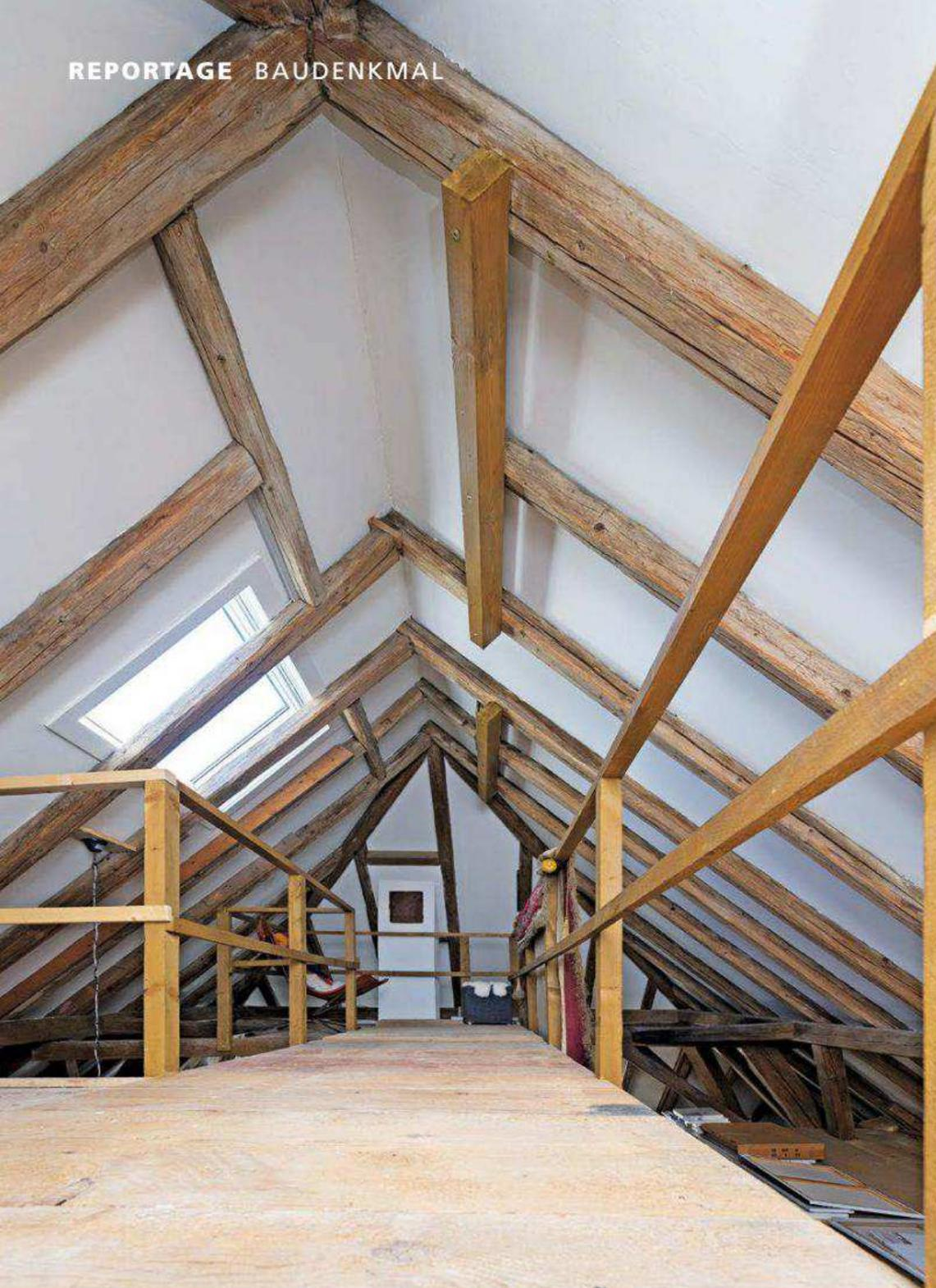
Nach Verhandlungen mit der Denkmalbehörde konnte Architekt Gindele die Dachbalken sichtbar lassen, nachdem zunächst eigentlich eine Zwischensparrendämmung vorgesehen war. Eine Besonderheit sind die PU-Aufsparrendämmelemente mit unterseitig aufkaschierten Silikatplatten, die sich streichen oder verputzen lassen.
