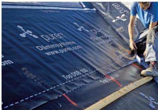
Bei dieser Dämm-Methode kann sich die neue Dämmung auf der vorhandenen Altdämmung aufbauen. Wichtige Zwischenlage dann: Vollflächig dicht verklebte Membran-Bahnen, die eine geschlossene Luftdichtungsebene bilden.
