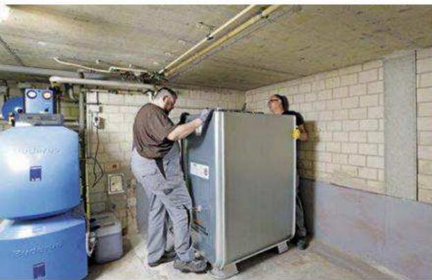
Die Doppelwandigkeit der Tanks erspart einem eine gemauerte Auffangwanne.
