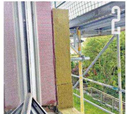
**Mit derer 18 cm dicken Außendämmung doppelten die Bauherren die Gebäudewand nahezu auf. Die Fenster beließ man jedoch an ihrer ursprünglichen Position.**
