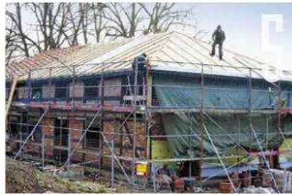
Das neue Dach bewahrt ehemalige Form und Neigung, ist bereits wasserdicht und wartet nur noch auf die neue Deckung, die die alten Faserzemenplatten ersetzt.
