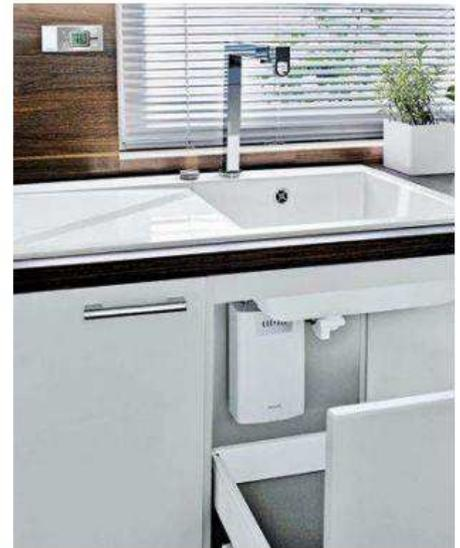
Bei Einzelzapfstellen, wie Ausguss- und Spülbecken, lassen sich Kleinspeicher mit Warmwasservorrat oder – wie hier – ein Kompakt-Durchlauferhitzer mit praktischer Fernbedienung einsetzen. Clage
