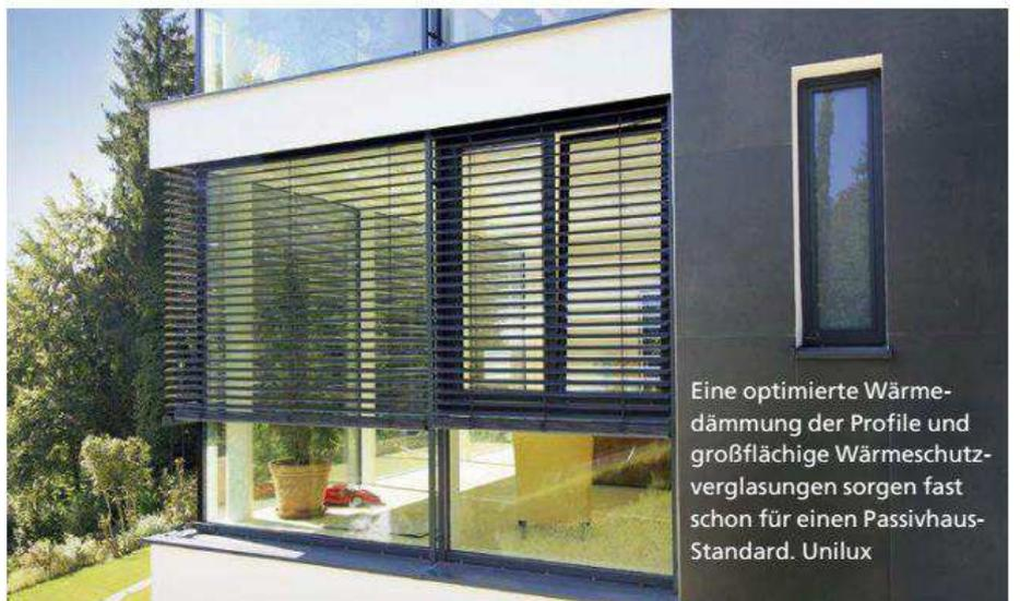
Eine optimierte Wärmedämmung der Profile und großflächige Wärmeschutzverglasungen sorgen fast schon für einen Passivhaus-Standard. Unilux
