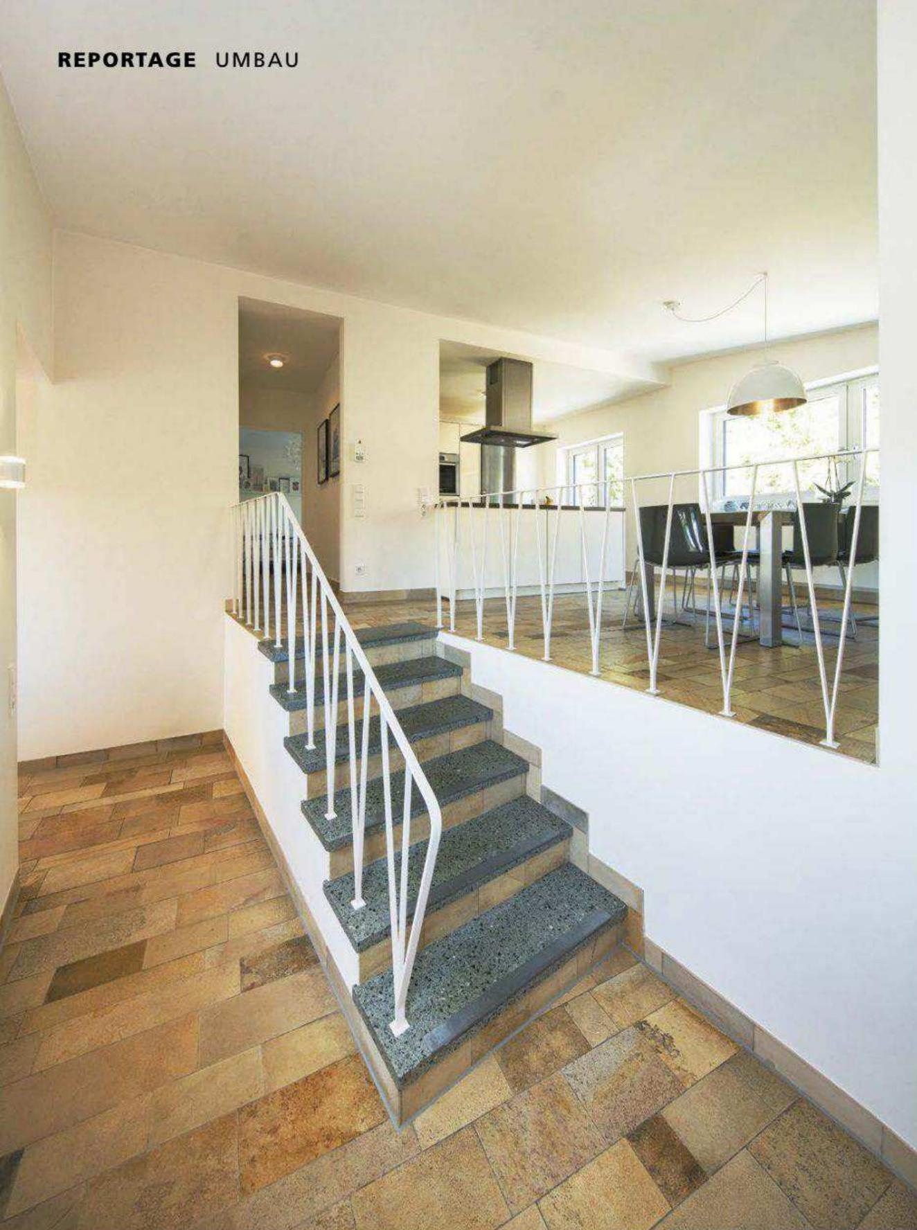
Die zuvor geschlossene Trennwand zwischen Küche und Esszimmer wurde entfernt und statisch durch einen stählernen Unterzug ersetzt. Die originalen Solnhofener Platten sind ebenso sorgfältig aufbereitet wie die Treppenstufen aus Betonwerkstein. Absolut erhaltenswert: die Geländer im bauzeittypischen Design. Der Durchgang führt in den Privatbereich.
