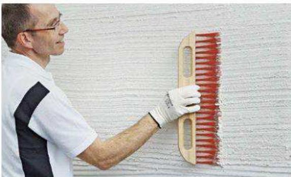
Individuelle Putzstruktur: Im noch feuchten Zustand wird die obere Putzlage mit einem breiten Besenwerkzeug horizontal freihand durchgezogen. Die Rillung lässt das handwerkliche Verfahren deutlich erleben.
