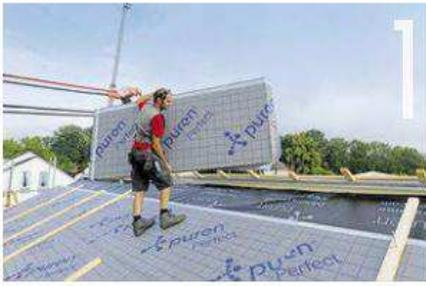
Die Dämmelemente aus Polyurethan sind als leichte Einmannplatten konzipiert und werden reihenweise von unten nach oben verlegt und per Stufenfalz dicht verbunden.
