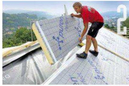
Entlang des Firsts werden die Dämmplatten gegebenenfalls maßgenau zurechtgesägt, längsseitig auf Gehrung geschnitten und dann sorgfältig eingepasst.
