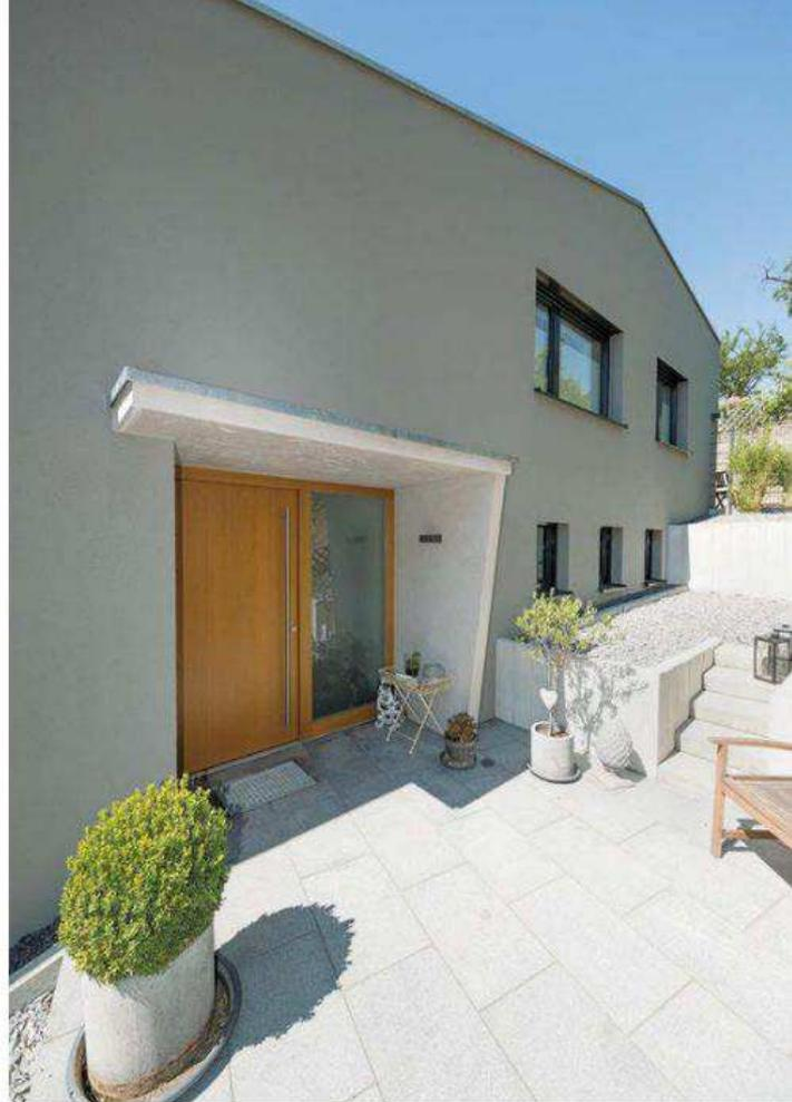
Das Sichtbeton-Vordach wurde saniert, dank thermischer Maßnahmen bildet es jetzt keine Wärmebrücke mehr.
