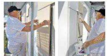
Elemente mit Fassadenkleber im Buttering-Floating-Verfahren auf das WDVS kleben. Die Fugenbreite sollte mindestens fünf und nicht mehr als 20 mm sein. Dann werden die Elemente mit Silikonharzfarbe gestrichen.
