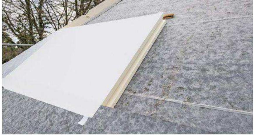
Auf den Sparren hat man leistungsstarke PU-Wärmedämmelemente verlegt, die der Industrieverband Polyurethan-Hartschaum zur Verfügung gestellt hatte.
