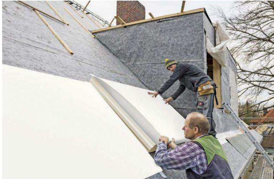
Die PU-Dämmelemente der Wärmeleitfähigkeitsstufe 023 sind 120 Millimeter stark. Aufkaschierte Unterdeckbahnen sorgen für ein regensicheres Dach in der Bauphase.
