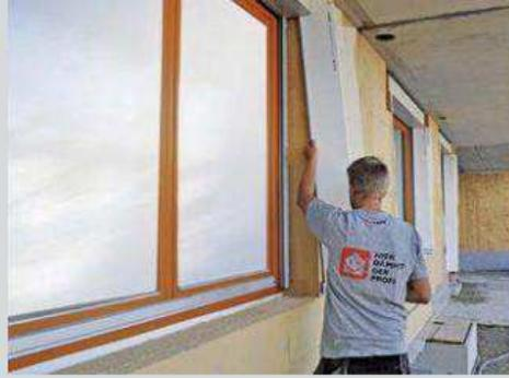
Die Holzfaser-Laibungsplatten werden mit Montagekleber in die Laibung gebracht und dort seitlich angedrückt. Die Gewebefahnen dienen dann dem rissicheren Einspachteln auf der Fassade.
