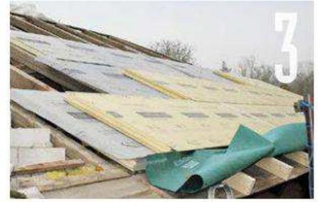
Die zweite Dämmplattenlage wird auf der ersten fugenversetzt verlegt. Die Nut- und Feder-Kantenausbildung sorgt dabei für eine wärmebrückenfreie Dämmhülle.
