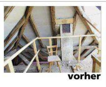
Mit einem bewehrten, betonierten Ringgurt, in dem die Sparren und Pfetten verankert wurden, hat man die Dachkonstruktion dauerhaft stabilisiert. Das Pfarrhaus erhielt anschließend eine wärmebrückenfreie Aufsparrendämmung aus PU-Hartschaumelementen von Linzmeier.
