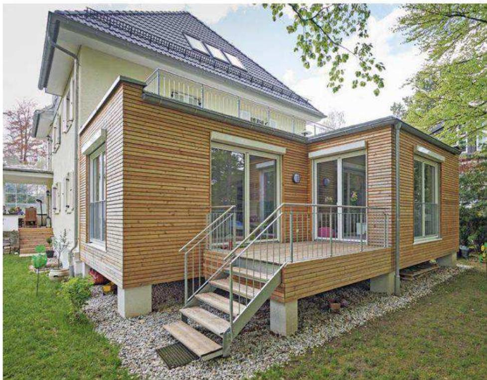
An der Seite der bestehenden Wohnimmobilie wurde ein neuer Anbau angedockt. Damit er mit dem Erdgeschoss auf einer Höhe ist, wurde das Gebäude auf Betonpfosten gestellt. Die Wände haben die Handwerker in Leichtbauweise erstellt und auf der Außenseite mit Holzelementen verkleidet.
