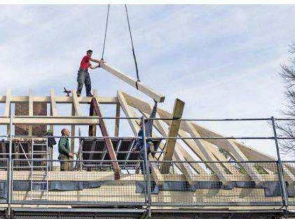
Der alte Dachstuhl wurde komplett abgetragen und durch neue Dachbalken ersetzt.
