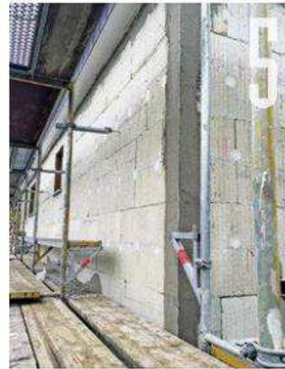
Vor dem vollflächigen Einbetten des Gewebes wird die Mineralwolle-Dämmhülle noch mechanisch an der Außenwand fixiert.
