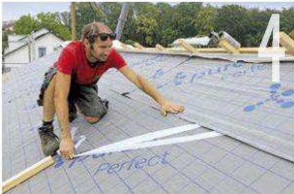
Auch die waagerechten Überlappungen bezüglich der einzelnen Dämmplattenreihen werden nach Abziehen der Schutzfolien auf diese Weise dicht verbunden.
