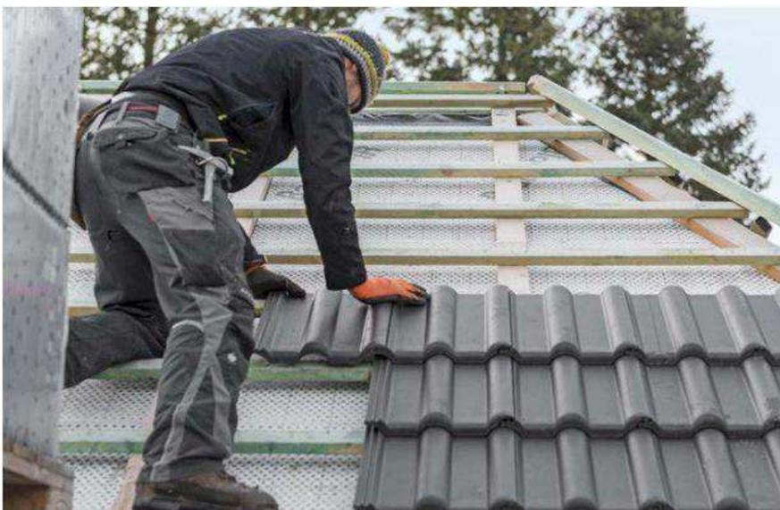
Ganz oben: Die zukunftsweisende „Protegon“-Oberfläche der Dachsteine von Braas zeichnet sich durch eine glattere Oberfläche und optimierte Schnittkante aus.
