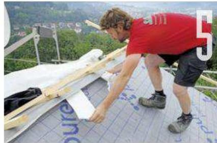
Einfaches Verkleben für den Profi auch am First. Die Verklebung am Dachknick ist übrigens äußerst robust und haltbar. Die aufkaschierte Unterdeckbahn soll auch ...
