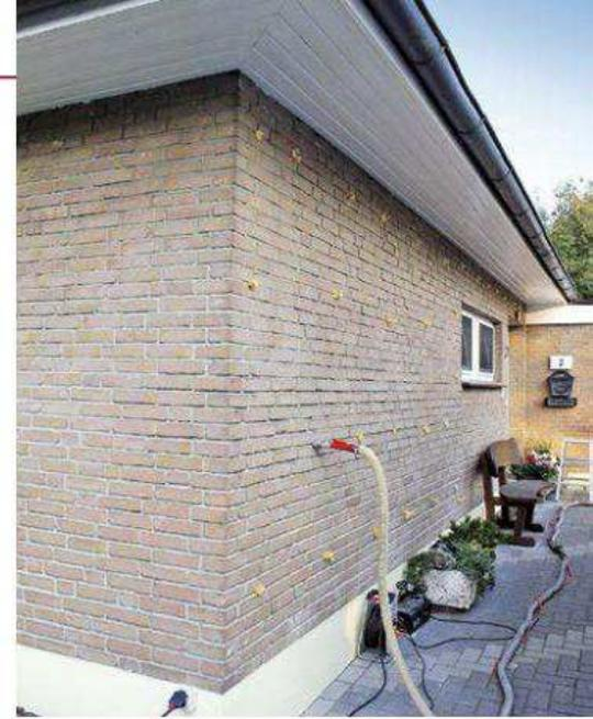
Ursa bietet die Einblasdämmung in zwei Varianten an. Pure Floc kommt in Holzgefach-Konstruktionen, bei obersten Geschossdecken sowie in zweischaligen Dächern zum Einsatz. Pure Floc KD hingegen ist das Produkt für die Dämmung des zweischaligen Mauerwerks.
