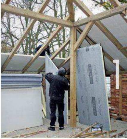
Auch wenn Balken z. T. erneuert wurden, sichtbar sollte alles bleiben. Die erste Lage bilden Dämmelemente mit Sichtunterseite und oberseitiger Luftdichtungsfolie.
