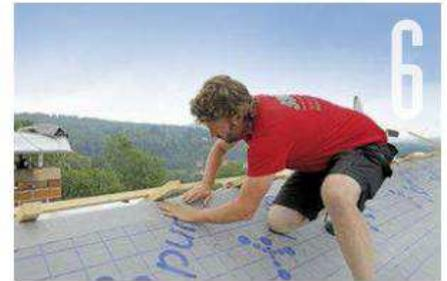
... hier nahtlos eine Dichtebene bilden. Der First wird mit einem 300 Millimeter breiten Firstband zusätzlich gesichert, dann kann die Lattung angebracht werden.
