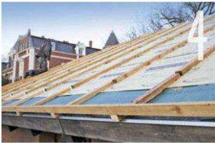
Mit einem Nageldichtband gesichert, bildete diese zweite Dämmlage nach Montage der Lattung eine winddichte, naht- und perforationsgesicherte Unterdeckung.
