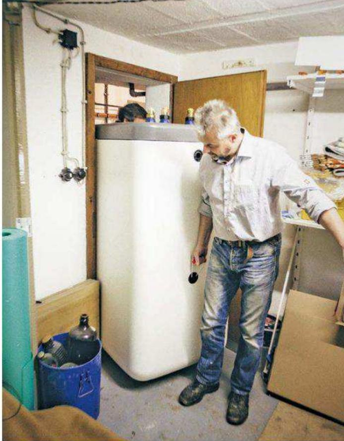
Der leicht zu transportierende Hochleistung-Wärmespeicher findet direkt neben der „HPU hybrid“ im Keller Platz.
