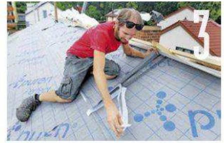
Die Oberseite fungiert als Unterdeckung. Die senkrechten Überlappungen dieser Unterdeckbahn werden aktiviert und hochfest „Kleber-auf-Kleber“ verklebt.
