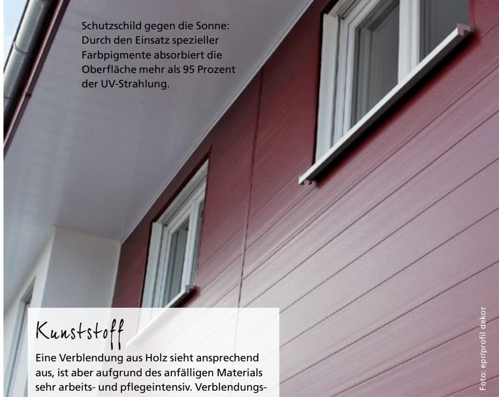
Schutzschild gegen die Sonne: Durch den Einsatz spezieller Farbpigmente absorbiert die Oberfläche mehr als 95 Prozent der UV-Strahlung.
