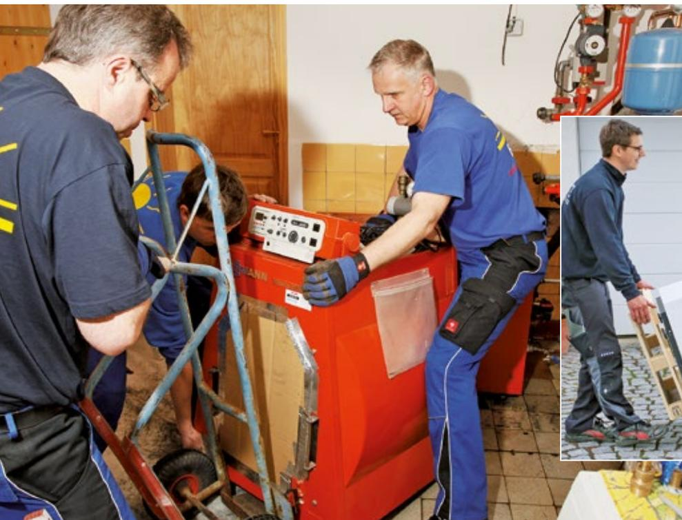
Hier wird der Heizkessel-Oldtimer durch ein neues, energiesparenderes, umweltschonenderes und kompakteres Gas-Brennwertgerät ersetzt.
