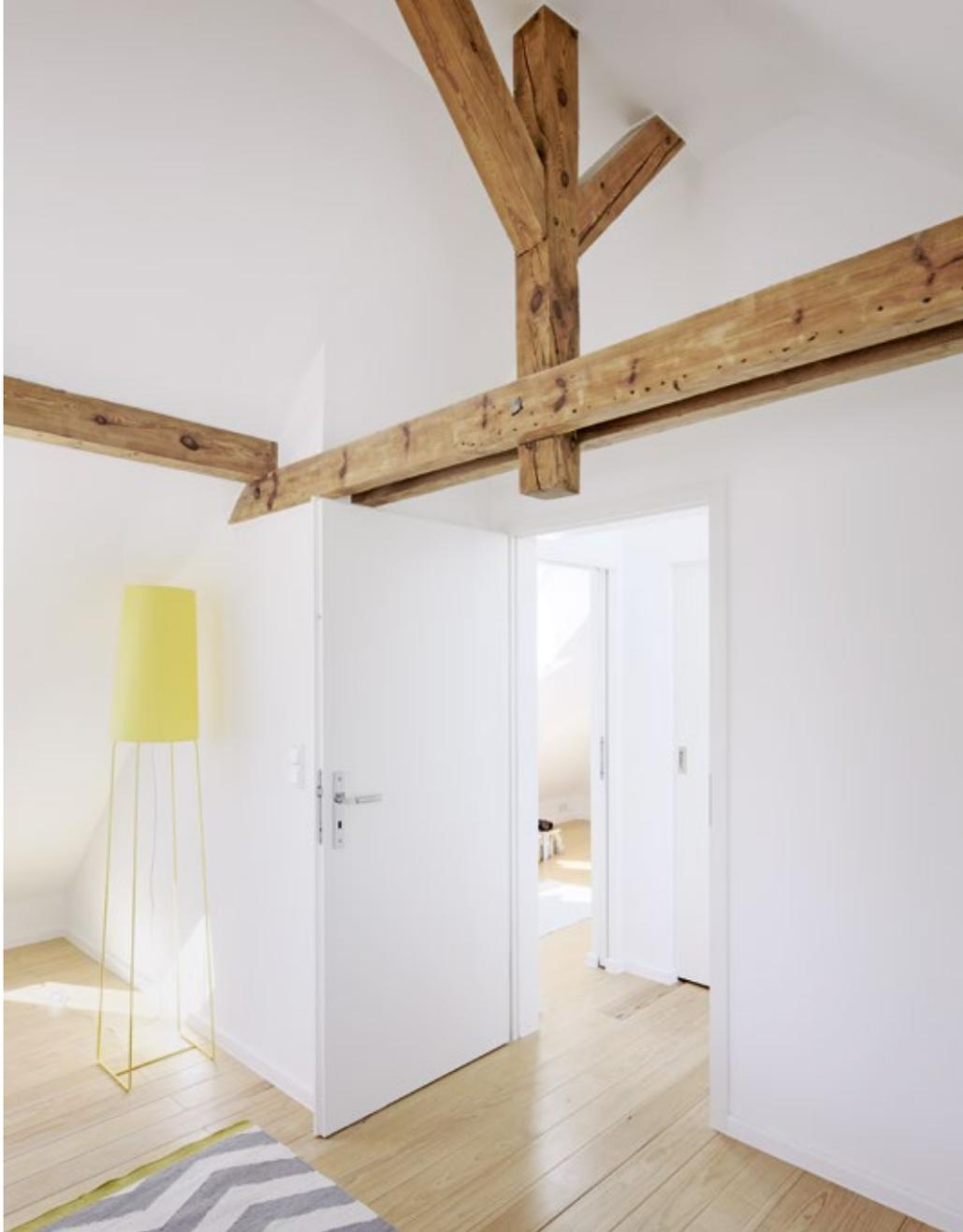
Ein Teil der originalen Dachbalken blieb sichtbar, wurde gebürstet und geölt. Aus Schallschutzgründen erhielt das Elternschlafzimmer eine normale Tür, während sich Multifunktionsraum (links hinten) und Bad platzsparend mit Schiebetüren verschließen lassen.
