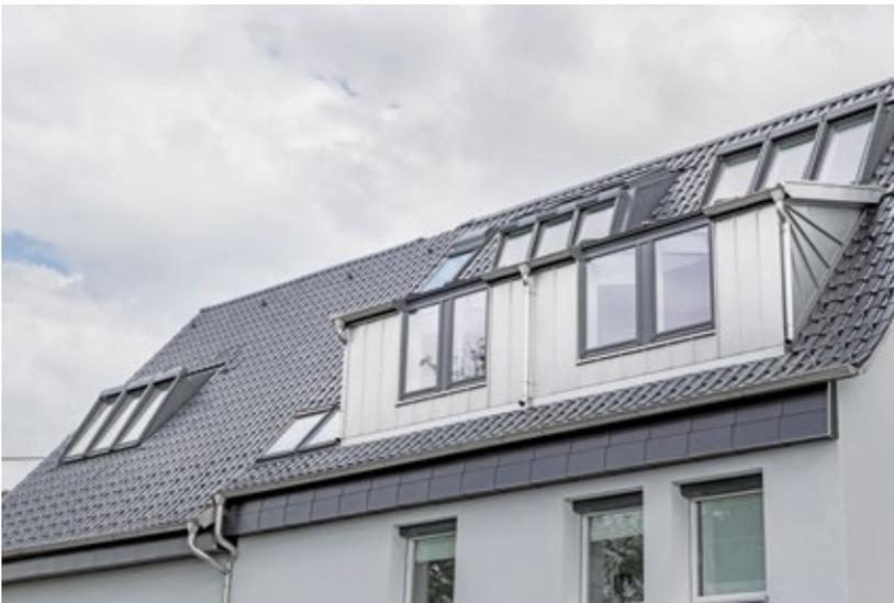
Nach dem Umbau ermöglichen zahlreiche Velux-Fenster ein tageslichtdurchflutetes Dachgeschoss mit gesundem Raumklima. Bei der Lichtlösung „Panorama“ (Mitte) sowie den zwei Dreier-Kombinationen sorgen Aufkeilrahmen, die die Dachfenster steiler im Dach ausrichten, für zusätzliche Wohnfläche mit voller Stehhöhe.
