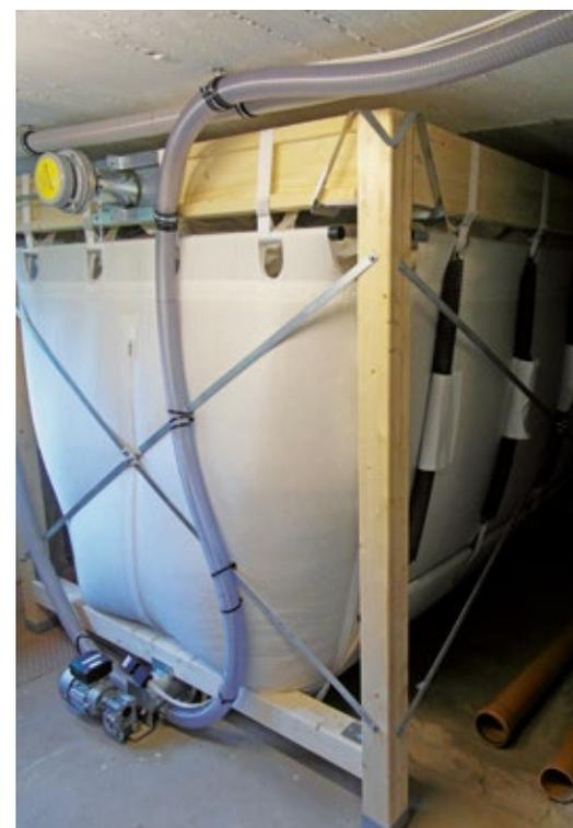
Die Holzpellets lagern in einem Gewebesilo trocken und sauber und gelangen über ein Ansaugsystem automatisiert zum Pelletkessel.
