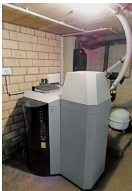
Der Heizkessel „Pelletti Touch“ deckt mit einem Wirkungsgrad von 94 Prozent nahezu den gesamten Wärmebedarf des Hauses ab.
