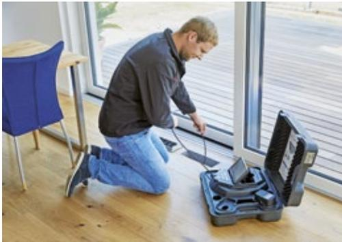
Per Videoinspektion kann der Fachmann prüfen, ob das Luftleitungssystem eventuell verschmutzt ist, und ob es gereinigt werden muss. [www.zehnder-systems.de](http://www.zehnder-systems.de)
