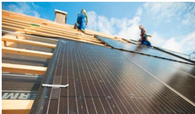
Vor allem in Verbindung mit einer Dachsanierung bietet sich ein Photovoltaik-Indachsystem als optisch attraktivere Alternative zur Aufdachmontage an. Im Bereich der Module entfallen hierbei die Dachsteine. Solarwatt
