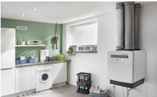
Von einer zentralen KWL-Anlage sind nur das Lüftungsgerät im Technikraum und die Luftauslässe in den Wohnräumen zu sehen – elementarer Bestandteil ist aber auch das Rohrsystem, auf das besonderer Wert gelegt werden sollte.
