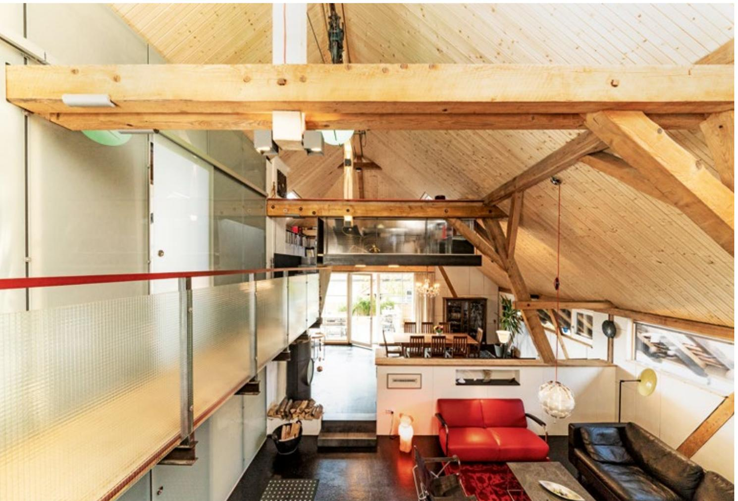
Das mit Holzweichfaserplatten gedämmte Dach wurde innen recht kostengünstig mit Nut- und Federbrettern verkleidet. Eine örtliche Schreinerei versah diese auf Wunsch der Architekten mit schmalen Schnitten, um in der Fläche eine spezielle Struktur zu erzielen.
