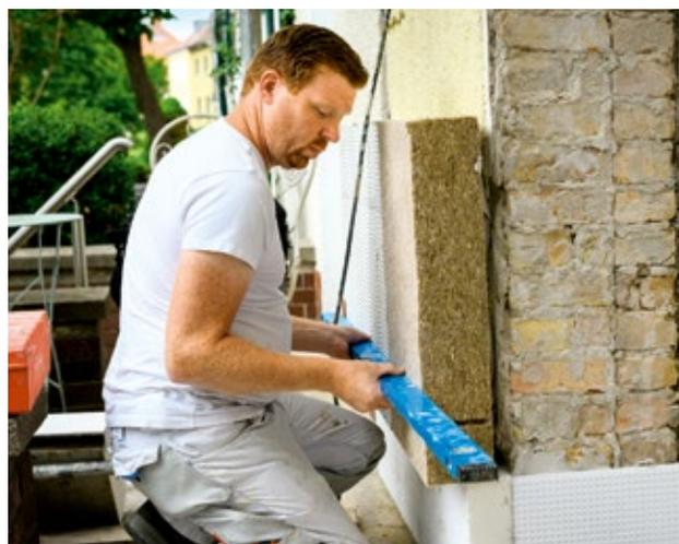
Nachhaltig und dauerhaft Energie sparen: Ein Handwerker montiert eine Hanf-Dämmplatte an die Hausfassade. [www.co2online.de/PhilDera](http://www.co2online.de/PhilDera)
