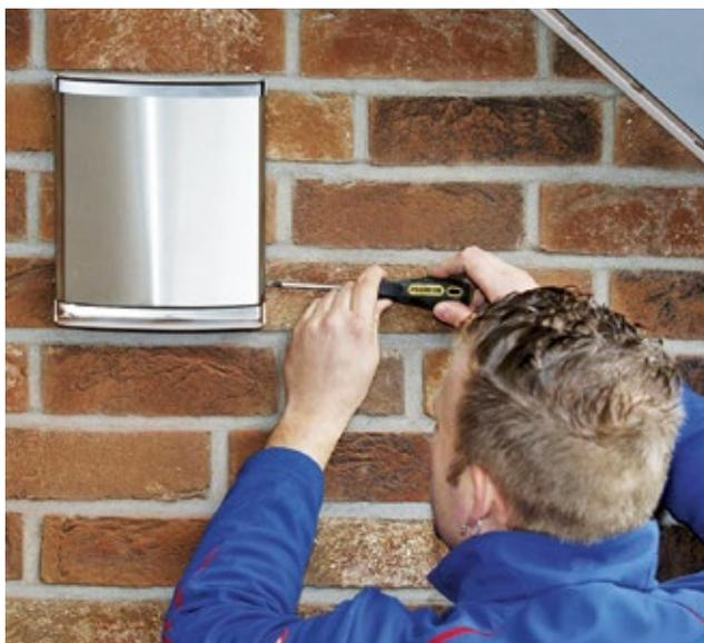
Für den nachträglichen Einbau eines dezentralen Lüftungsgerätes sind Kernlochbohrung und Stromanschluss erforderlich. Die gesamte Technik bleibt in der Wand verborgen. Außen ist eine Design-Außenwandhaube aus Edelstahl zu sehen.
