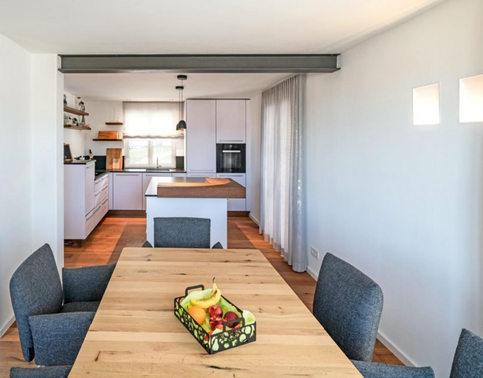
Blick in Richtung Küche. Der Stahlträger ersetzt eine abgebrochene Zwischenwand, rechts hinter dem Vorhang befindet sich der neu geschaffene Zugang zu Carport und Terrassendeck.
