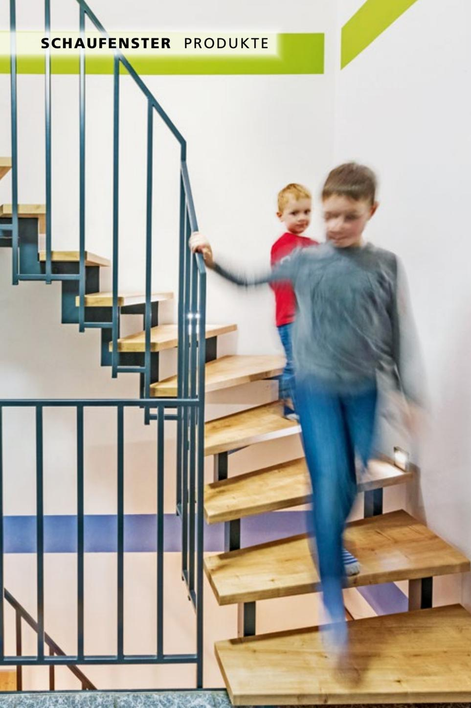
Zweiholm-, Harfen- und Metallwagentreppen verfügen über eine Stahlkonstruktion. Deshalb lassen sich die Stufen ruck, zuck austauschen.
