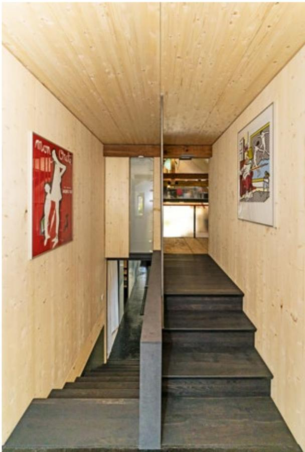
Links: Massive Holz-Dreischichtplatten bilden Wände und Decke des Treppenhauses. Die aus Eiche gefertigte Treppe wurde mit Essiglösung und Stahlwolle behandelt, Oxidieren ergab den dunklen Farbton.
