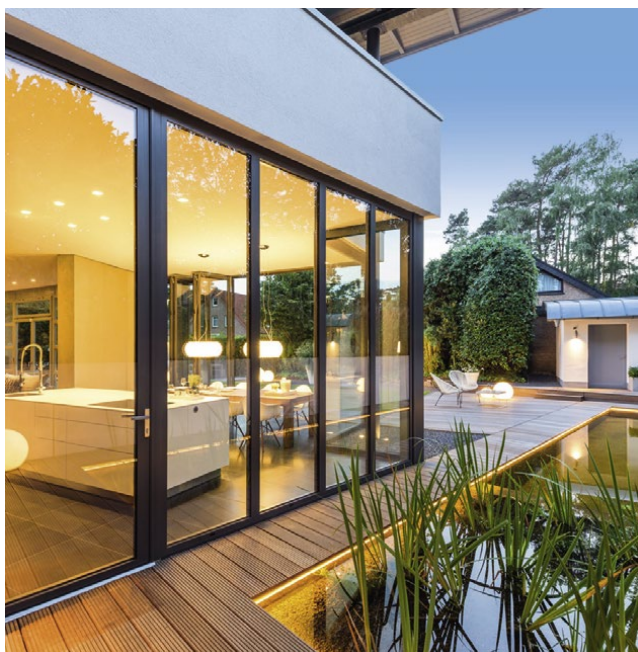
Die seitlichen Glaselemente sind fest – bis auf eine Tür zum Holzsteg, der um den Teich herumführt.
