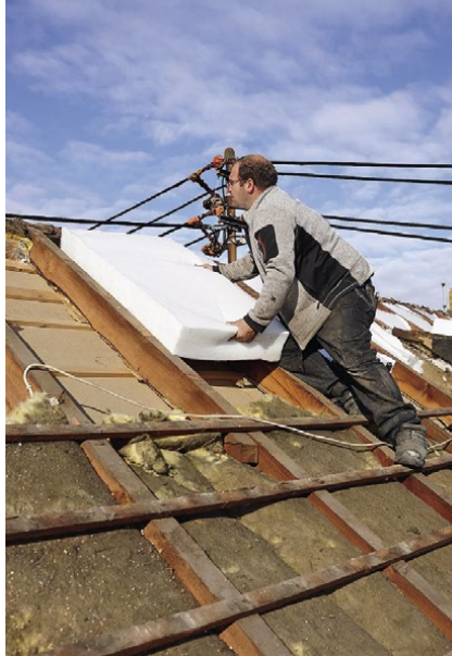
Je nach Zustand der alten vorhandenen Dämmung wird sie ergänzt oder gleich komplett ausgetauscht. Bauder
