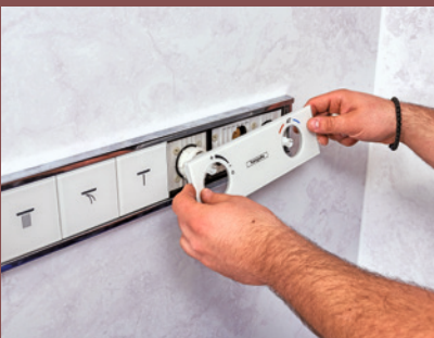
45 Wassermengenregler und Thermostat verstecken sich hinter einer gemeinsamen Glasabdeckung.
