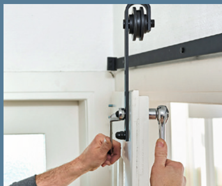
15 Spannender Moment – Befestigung der Rollenhalter. Sie laufen auf der Schiene und tragen später die Tür. Diese steht senkrecht auf dem Boden, unterlegt für 10 mm Bodenabstand.
