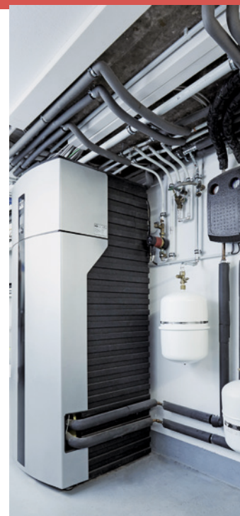
Eine Wärmepumpe WKF compact mit integriertem Speicher und 12 kW Leistung bildet den Mittelpunkt der Anlage.
