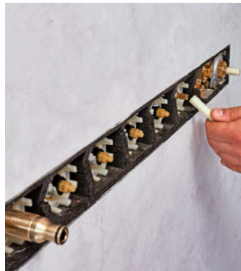
35 Mit gleicher Länge (gegebenenfalls entsprechend kürzen) werden die Kunststoffstifte für die 2 Drehregler montiert.
