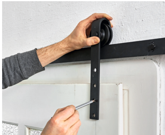
15 Spannender Moment – Befestigung der Rollenhalter. Sie laufen auf der Schiene und tragen später die Tür. Diese steht senkrecht auf dem Boden, unterlegt für 10 mm Bodenabstand.
