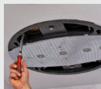
Nun wird der Einbaukörper mit Düsenblende über die 4 Gewindestangen, die in der OSB-Platte sitzen, fixiert.
