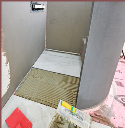
22 Da das Duschbodenelement bereits mit einem Gefälle nach hinten versehen ist, muss beim Verkleben darauf keine Rücksicht mehr genommen werden.
