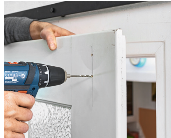
16 Die Bohrlöcher sind mittig am Rahmen markiert, Dann wird mit geringem Durchmesser ganz durchs Holz gebohrt, als Punktmarkierung für die Tür-Rückseite.
