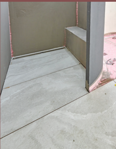
24 Eben und versatzfrei läuft nun der Fliesenboden vom Raum in die Dusche, bis ganz hinter die Rinne.
