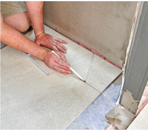
18 Da ja der Raumboden nahtlos und versatzfrei in die Dusche weiterlaufen sollte, wurde hier nun die erste Fliese der Rundung gemäß angezeichnet.
