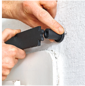
10 Die dritte Wandhalterung sitzt genau an diesem Punkt und bildet damit eine schienenverbindende Wandfixierung.
