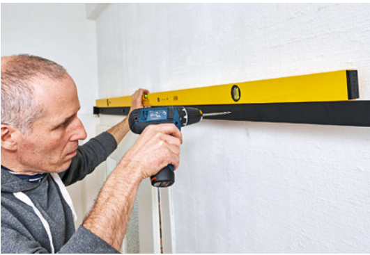
13 Im Weiteren geht es darum, die Verlängerungsschiene in horizontaler Linie festzuschrauben. Mit einer langen Wasserwaage tut man sich leichter beim Markieren der Bohrpunkte.
