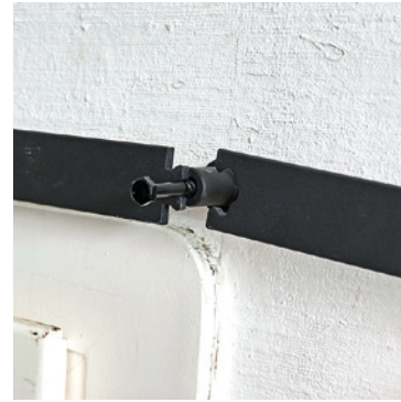
11 Die beiden Schienenenden verhaken sich quasi an dieser Befestigungsstelle, wo dann ...
