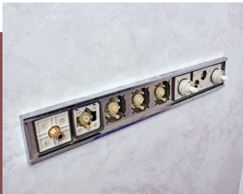
41 Noch einmal im Überblick: Jede der sieben Armaturenstellen hat ihr besonderes Bauteil bekommen. All das verschwindet dann hinter Abdeckungen bzw. Tasten.
