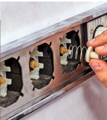
40 Für die drei mittleren Kopfbrause-Taster werden jetzt die Federeinsätze eingebracht.
