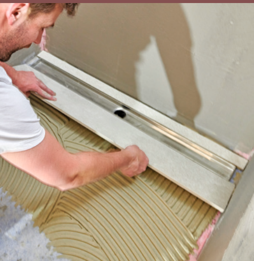
21 Erst als auch die letzte Fliese vor der Rinne gemessen und entsprechend schmal geschnitten war, wurden die Duschbodenfliesen verklebt.
