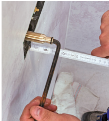
34 Mit 34 bis 36 mm Überstand bis zur Wand wird das Anschlussstück für die Handbrausehalterung eingedreht.
