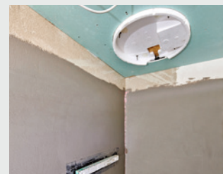
Sie dient auch als Ausschnittschablone und bleibt solange oben, bis die Gipskartondecke verlegt und fertig verputzt ist.
