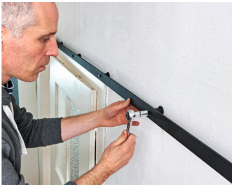
14 Hier war wieder Mauerwerk als Untergrund, was Dübel erforderte. Dann wurden noch einmal zwei Wandhalter verschraubt.
