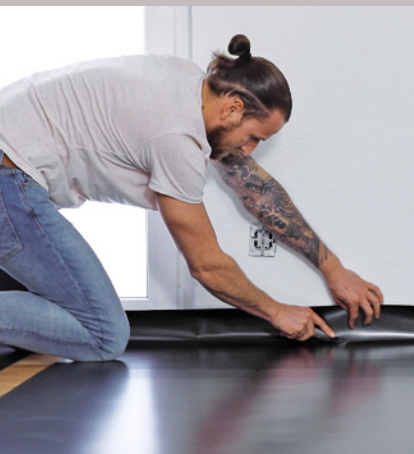
10 Hier sieht man, dass die Bahnen mit etwa 5 cm Abstand nebeneinander zum Liegen kommen und auch an der Wand abgeschnitten werden können.
