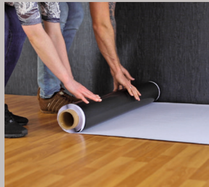
7 ... auf dem bestehenden Untergrund direkt ausgerollt. Dabei ist zu beachten, dass die Bahnen nicht überlappend verlegt werden!
