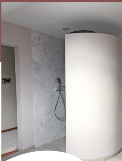
27 Die Dusche ist fertig und außen schon mal mit einer ersten Putzschicht versehen, links endet die innere Wandbekleidung ihrer Funktion gemäß noch deutlich vor der Badtür.
