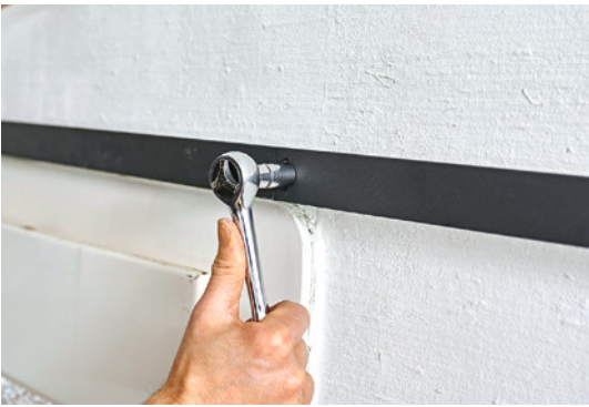
12 ... wiederum mit einer schwarzen Schraube Schienen wie Wandhalterung festgesetzt werden. Die Verbindung ist kaum mehr als solche erkennbar.
