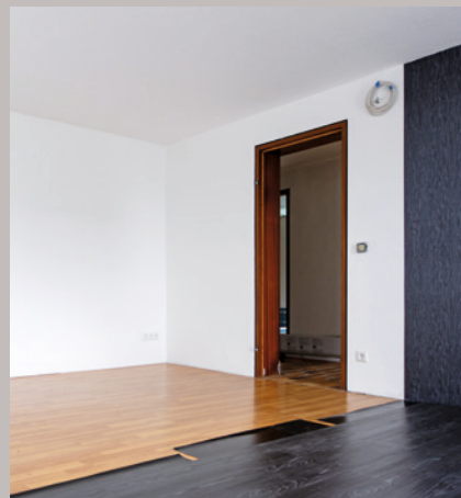
11 Vorab einmal ein erster Zwischeneindruck: Der neue Vinylboden liegt schon hälftig auf den Magnetmatten-Bahnen und baut dabei nur mit drei Millimeter auf. Ideal also fürs Renovieren.
