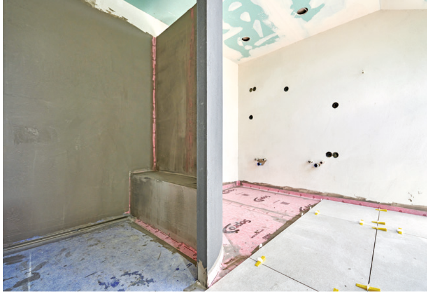
17 Inzwischen wurden auch die rohen Wände in der Dusche und im Raum verputzt. In der Dusche sieht man auch, wie abgedichtet wurde. Auf dem alten Fliesenboden außerhalb wurde eine Entkopplungsmatte verlegt, darauf dann neu großformatig verflies.
