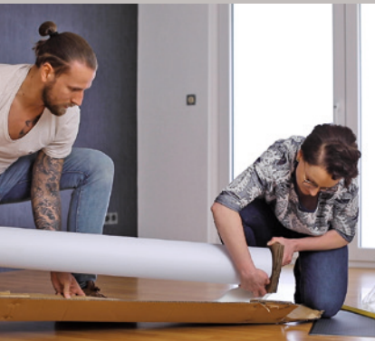
6 Die Magnetmatte wird auf Rollen geliefert. Je nach Raumgröße benötigt man mehrere. Sie wird dann auf ...
