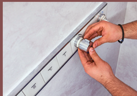
46 Die Drehknöpfe dafür werden jeweils nur aufgeklickt, beim Thermostatkopf wählt man noch die richtige Wunschtemperatur-Stellung aus.
