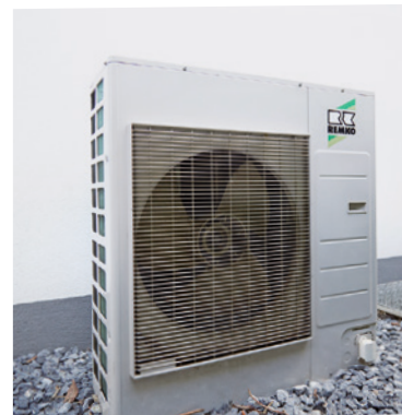
Das Außenmodul des Splitgerätes wurde neben dem Haus platziert. Die Luft strömt seitlich in das Außenmodul und gibt ihre Energie ab. www.remko.de
