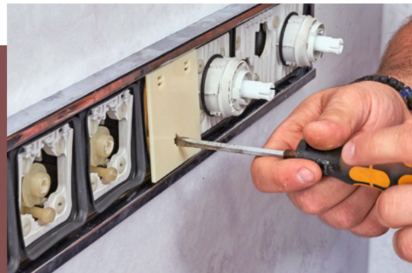
42 Alle weißen Halterahmen sitzen nun fest. Die Bedientasten für die drei Kopfbrause-Stellen werden mit einer Schablone eingestellt. Diese wird aufgeklickt und unten kantenbündig herausgedreht.
