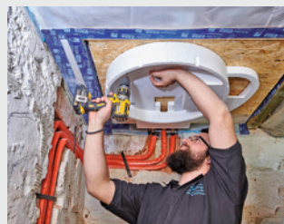
Entsprechend der Wunschposition in der Dusche wählt man die Stelle. Die Styroporverpackung ist zugleich Bohrschablone.
