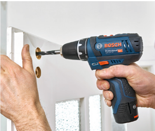
18 Erst jetzt bohrt man waagrecht für die nachfolgenden Gewindeschrauben ganz durchs Holz – und zwar mit entsprechend größerem Durchmesser, den die Schrauben vorgeben.
