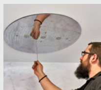
Mit unscheinbaren Schrauben werden diese schließlich fixiert. Die Deckeneinbaubrause ist nun nutzbar.
