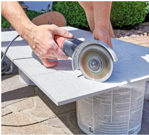
19 Mit einem Trennschleifer und einer Diamantscheibe konnte die geschwungene Kontur exakt hergestellt werden. Diese erste Feinsteinzeugfliese liegt dann ...
