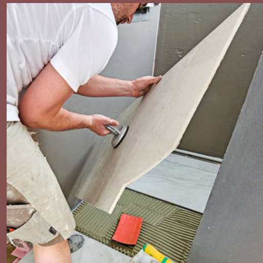
23 Für die letzte zugeschnittene Fliese war es hilfreich, einen Saugheber einzusetzen, um das Großformat von außen her genau zu positionieren.
