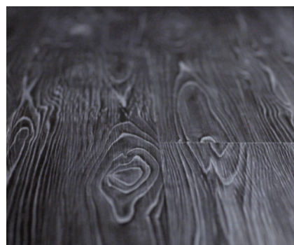
14 Die Dekorfolie ist sehr authentisch und die Oberflächenstruktur ist auch haptisch erlebbar. Die Elementstöße sind kaum wahrnehmbar.
