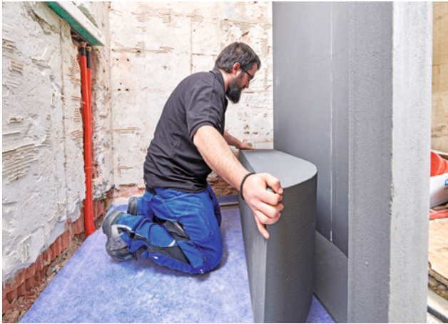
16 Individuell angefertigt wurde auch die Sitzbank. Sie besteht ebenfalls aus Hartschaum und ist ebenso beschichtet für die weitere Verarbeitung (Fliesen oder wie hier Platten). Sie wird mit Kleber eingebaut.
