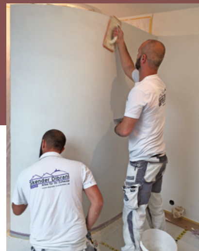
28 Finish für die Duschabtrennung: Mit einem feinen Endputz wurde der Bogen eben abgefilzt und sorgt mit dem Weiß für helle Raumverhältnisse.
