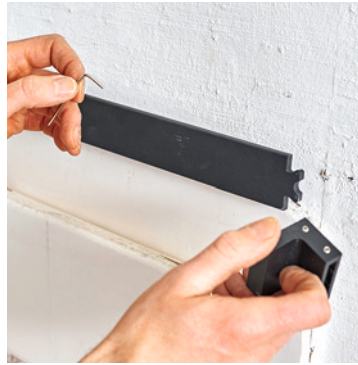
9 Nun zieht man den rechten Stopper heraus, da die zweite Schiene hier am Ende der ersten Schiene andocken muss.
