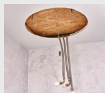
Zur Montage der Brause werden die Schablone entfernt und hinten die drei Wasser-schläuche angeschlossen.
