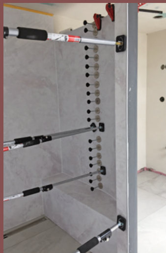
25 Danach wurden die Wandplatten verklebt und mit Spannvorrichtungen bis zum Austrocknen festgehalten.
