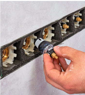
33 Die Einsätze schraubt man dann auf die Messinggewinde der Unterputzeinheit auf.
