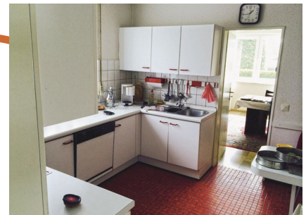
Nicht tragende Zwischenwände wurden entfernt und machen durch den offenen Grundriss das Erdgeschoss offener, großzügiger und transparenter als das kleinteilige Raumprogramm aus den 70er-Jahren.
