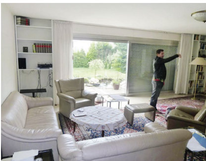
Die alten Fenster wurden durch moderne, leicht bedienbare Schiebelemente mit Wärmedämmverglasung ersetzt. In Trockenbauweise erstellte Regale bieten sich als raumhohes Bücherregal an.
