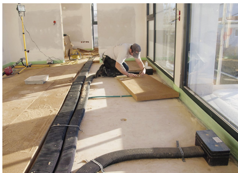
Im Neubau bietet sich eine Verlegung der Luftkanäle in der Estrichdämmung an. Zu sehen sind später nur die Lüftungsgitter im Bodenbelag. VFW
