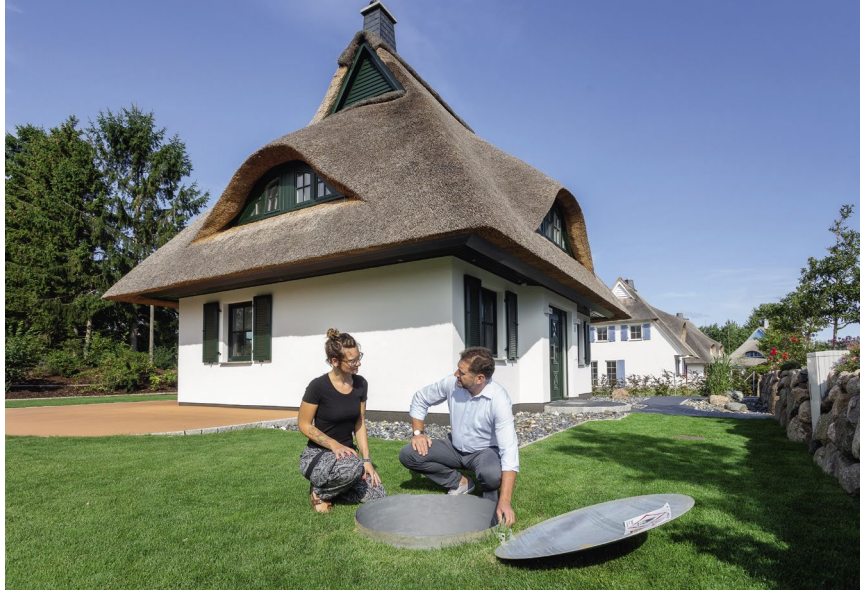
Stefan Rasenberger, Progas-Verkaufsleiter, überprüft die einwandfreie Funktion des erdgedeckten Flüssiggasbehälters.
