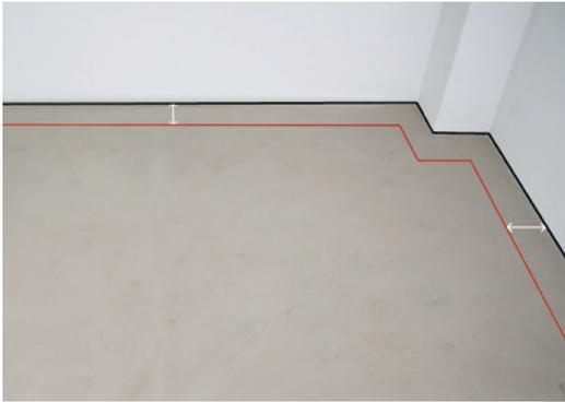
**1** Bei einer Gestaltung mit Fries wird entlang der Wände eine Linie angezeichnet, die je nach Wunsch einen gewissen Abstand (Plankenbreite zugrundelegen!) zur Wand hat.
