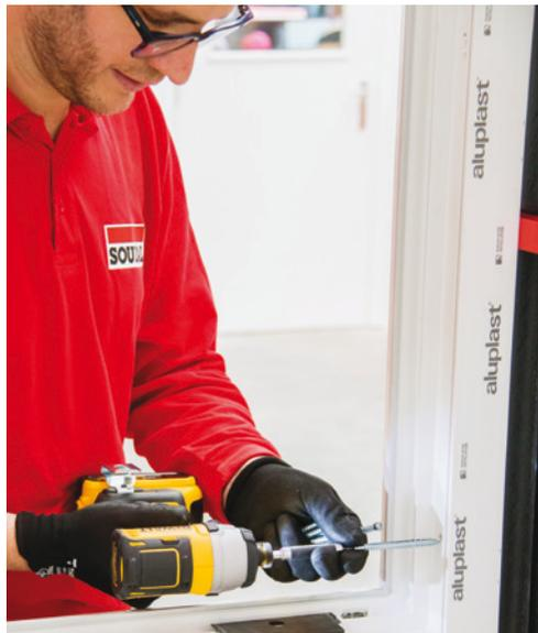
**16** An den seitlichen Bohrungen steckt man nun Schrauben ein und verschraubt so den Fensterrahmen im schwarzen Vorwandrahmen. Das gibt genügend Halt.
