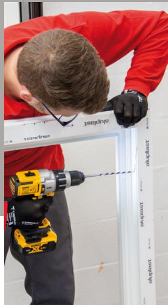
**14** Erst wird noch der Fensterrahmen vorbereitet. Je nach Größe werden entsprechend viele Bohrungen erstellt.
