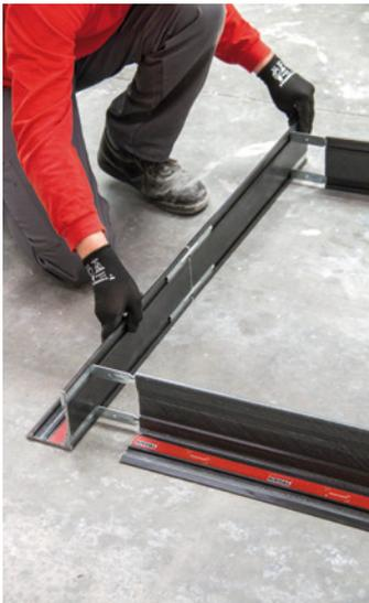
**5** ... bis sie außen kantenbündig abschließen. Dann kann auch schon der Rahmen zusammengebaut werden. Die Metallverbinder sitzen stramm.
