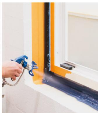
**19** Innen wird die Flüssigmembran verarbeitet. Hier setzt der Profi gern die Druckluft-Spritzmethode ein.
