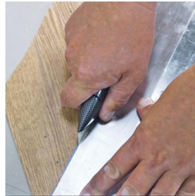
**18** ... schneidet man an einem langen Lineal direkt auf der Markierungslinie die Überstände ab.
