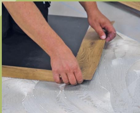
**6** Es folgt das erste Vinylelement an der anderen Quadratseite. Es läuft über die Quadratspitze weiter und endet vorne bündig mit dem liegenden Stab.
