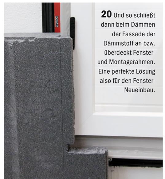
**20** Und so schließt dann beim Dämmen der Fassade der Dämmstoff an bzw. überdeckt Fenster- und Montagegerahmen. Eine perfekte Lösung also für den Fenster-Neueinbau.
