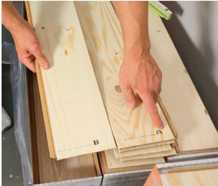
**1** Vor der Verlegung den Unterboden gut absaugen. Dann die Dielen auspacken. In jedem Paket gibt es A- und B-Dielen in gleicher Menge.
