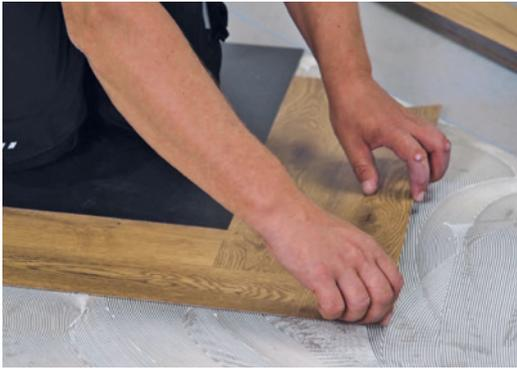
**8** Hier sieht man gut, dass die maßgenau gefertigten Planken immer eine versatzfreie Außenlinie bilden und sich alles immer im vorgegebenen Kleberbereich abspielt.
