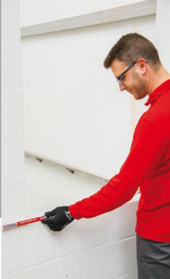
**1** Den Montagevorgang zeigen wir hier einmal an einem modellhaften Fensterausschnitt. Zunächst werden die lichten Maße (H x B) ermittelt.
