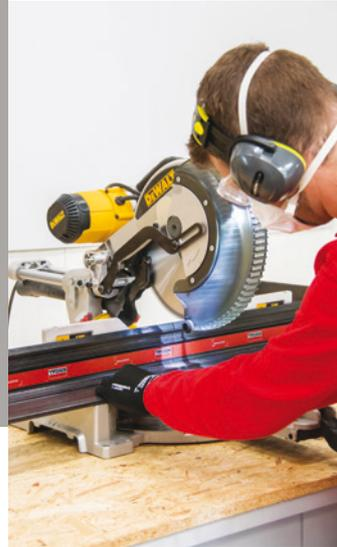
**2** Dann schneidet beziehungsweise sägt der Monteur die leichten glasfaserverstärkten Kunststoff-Profile gemäß der Öffnungsmaße zu.
