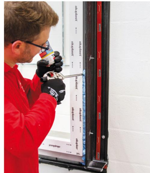
**17** Nach Entfernen der Federclipse wird das Fenster abgedichtet. Die umlaufende Fuge wird lückenlos mit dem Spezialschaum ausgefüllt.
