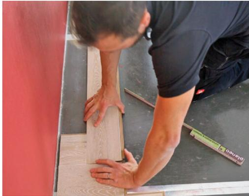
**10** Am anderen Ende sind die A-Stäbe entsprechend zu kürzen. Nun folgt der erste volle B-Stab, der um 90 Grad verdreht in zweiter Reihe an den A-Stab geklickt wird.
