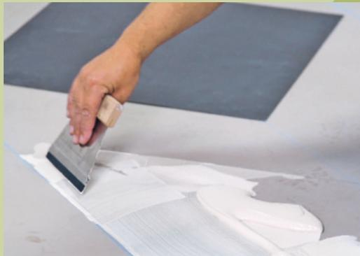
**4** ... die Markierungslinie nicht überzieht. Denn zunächst wird nur innerhalb der Fläche verlegt. Das Hilfsquadrat dient nur der winkelgerechten Ausrichtung der Planken.
