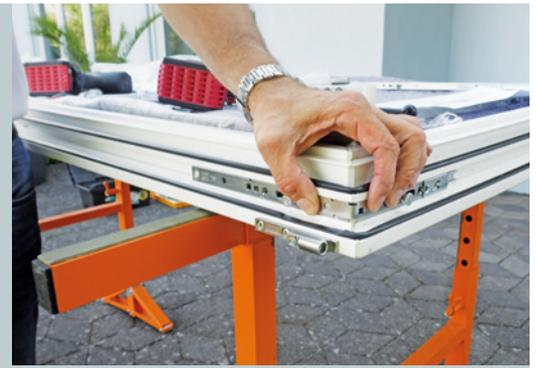
**2** Im nächsten Schritt werden die neuen Eckmullenkungen am Flügel verschraubt. Hier im Bild eines der neuen Bauteile, das nun auf der Bandseite montiert wird.
