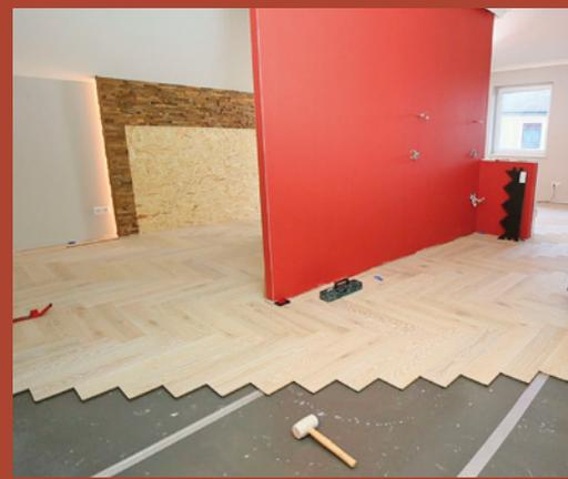
**15** Selbst eine halboffene Raumtrennwand lässt sich mit diesem System einbinden. Damit die Dielen dann wieder exakt zusammentreffen, ist es ganz wichtig, dass alle Stabstöße absolut dicht ausgeführt sind. Gegebenenfalls mit einer Schlaghilfe die Stöße etwas zusammentreiben.
