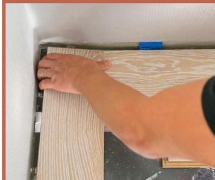
**6** Die erste B-Diele wird wandseitig so abgesägt, dass die Feder wegfällt. Dann klickt man sie an der ersten A-Diele kopfseitig ein.
