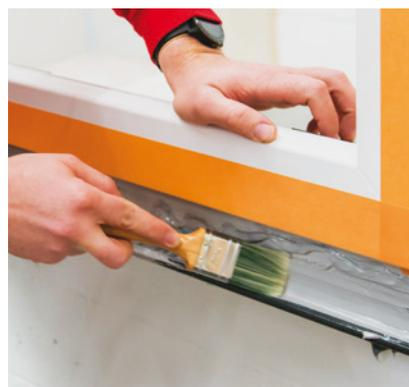
**18** Zur Fensterfugenabdichtung kommt außen noch eine Dichtpaste zum Einsatz, die satt per Pinsel aufgetragen wird.
