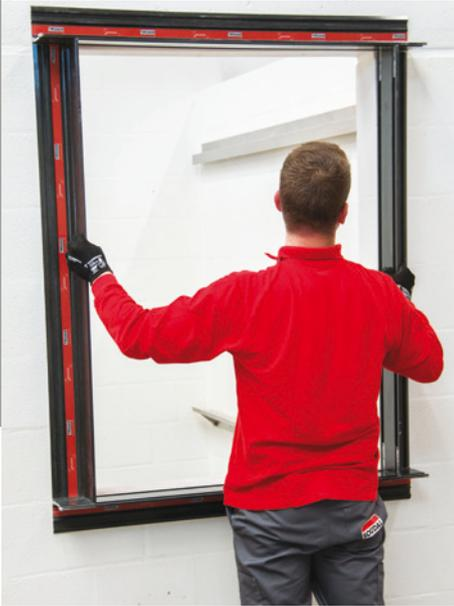
**9** Der Vorwandrahmen wird an der Fassadenöffnung positioniert, fest angedrückt und evtl. leicht angeklopft. Der Kleber hält ihn schon sicher fest.
