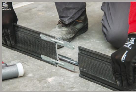
**3** Kurze Profilstücke oder Zuschnittreste können mit Längsverbindern verbunden werden. So lässt sich der Verschnitt minimieren.
