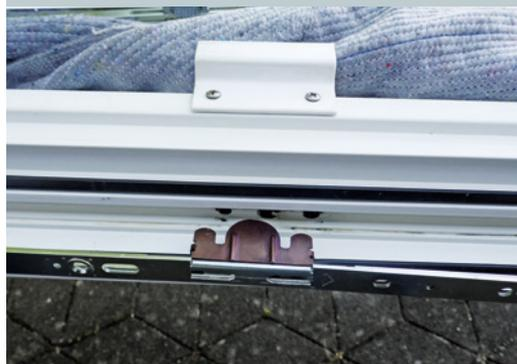
**5** ... inklusive Anbohrschutz. Dieser verhindert, dass ein Täter über ein gebohrtes Loch den Vierkantstift des Griffs drehen und das Fenster von außen öffnen kann.
