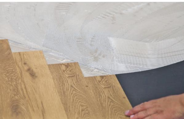
**13** Hierbei nicht einfach an den kurzen Enden der bereits liegenden Planken neu anlegen, sondern das Hilfsquadrat mit seinen langen Seiten als Winkelschablone verwenden.
