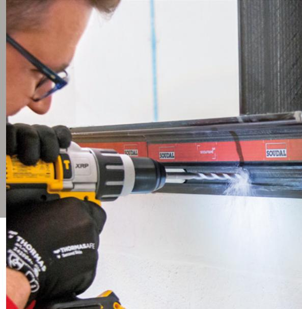
**11** Dann erfolgt eine zusätzliche mechanische Befestigung. Um die erforderlichen Rahmendübel einstecken zu können, werden Löcher durch die Profilschenkel gebohrt,
