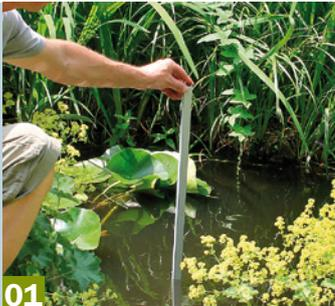
**01** Zuerst wird an der Stelle im Teich, wo später der Aussichtsturm stehen soll, die Wassertiefe mit Hilfe eines Profils ermittelt.
