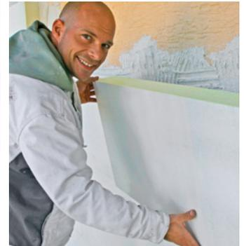
Wenn für eine Fassadenrenovierung ein Gerüst aufgestellt werden muss, dann lohnt es sich, neben der ästhetischen Aufwertung des Hauses auch gleich die energetischen Optimierungen einzuplanen. Wärmedämmverbundsysteme aus Polyurethan-Hartschaum sind hoch leistungsfähig bei schlankem Dämmbau. Fotos: [www.puren.com](http://www.puren.com)
