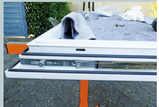
**6** Anschließend wird zunächst die Schere eingebaut. Sie ermöglicht das Kippen und Drehöffnen des Flügels. Es folgt der Einbau der restlichen Sicherheitsbauteile.
