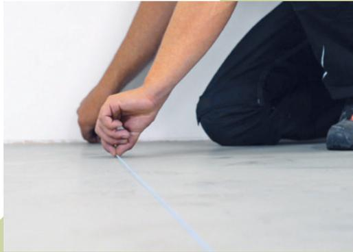
**2** Die Raummitte zuerst genau ermitteln und dann über die gesamte Bodenlänge mit Hilfe einer Schlagschnur die Mittelachse als Farblinie markieren.
