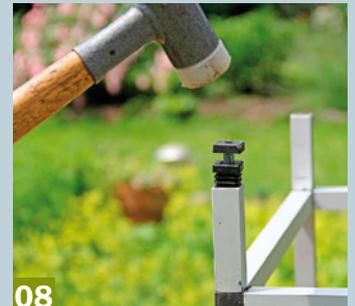
**08** Die Fußenden der Tragekonstruktion werden mit Gewindestopfen bestückt. Dank der Stellschrauben kann später feinjustiert werden.
