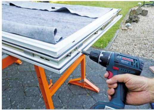
**1** Zur Montage der Sicherheitsbeschläge wird der Fensterflügel ausgebaut. Mit einem Akkuschauber lassen sich die vorhandenen Beschlagteile bequem entfernen.
