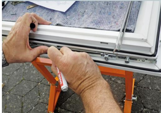
**3** Nun werden das Getriebe und die Scherenlager an den Flügel angelegt, damit ihre für den jeweiligen Flügel optimale Länge angezeichnet werden kann.
