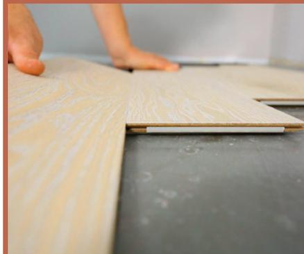
**4** Der Zusammenschluss muss absolut dicht sein, sonst potenziert sich der Abstand auf der Fläche und kann zu Unstimmigkeiten führen.
