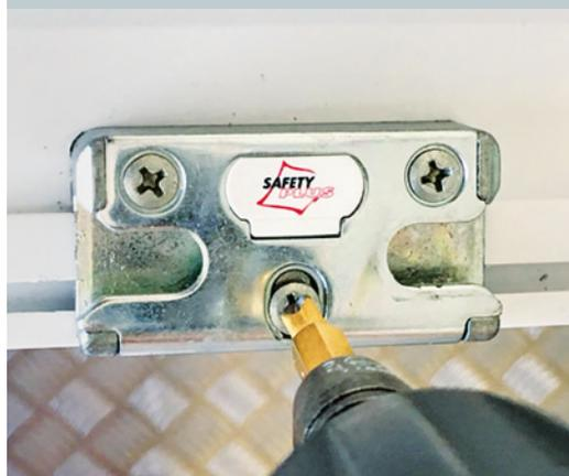
**7** Mit einer Schablone werden nun die Positionen der Sicherheitspilzbolzen am Flügel auf den Rahmen übertragen. An den markierten Stellen werden abschließend die Sicherheitsschließteile auf den Rahmen montiert.
