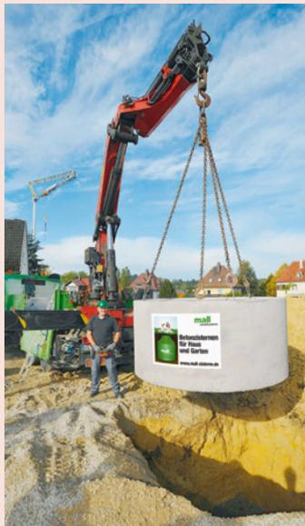
Nutzung von Regenwasser bietet Mall mit dem Garten-Paket Fontana Komplettlösungen für den Garten, die in der Version Fontana S aus einer Betonzisterne mit Gartenfilter, einer Tauchmotorpumpe, einer Entnahmestelle, Anschlussset und der Lieferung mit Versetzen in die Baugrube bestehen. In der komfortableren Ausführung Fontana L ist darüber hinaus eine Gartensäule aus Edelstahl für die Entnahme des Regenwassers enthalten.
