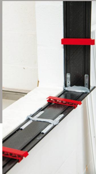
**13** Nun die Federclipline positionieren. Sie bieten nachher ausreichend Halt für die endgültige Fenstermontage.
