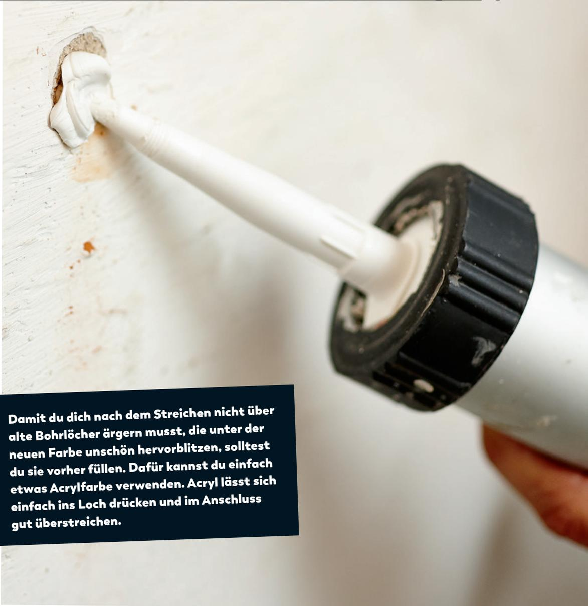
Damit du dich nach dem Streichen nicht über alte Bohrlöcher ärgern musst, die unter der neuen Farbe unschön hervorblitzen, solltest du sie vorher füllen. Dafür kannst du einfach etwas Acrylfarbe verwenden. Acryl lässt sich einfach ins Loch drücken und im Anschluss gut überstreichen.
