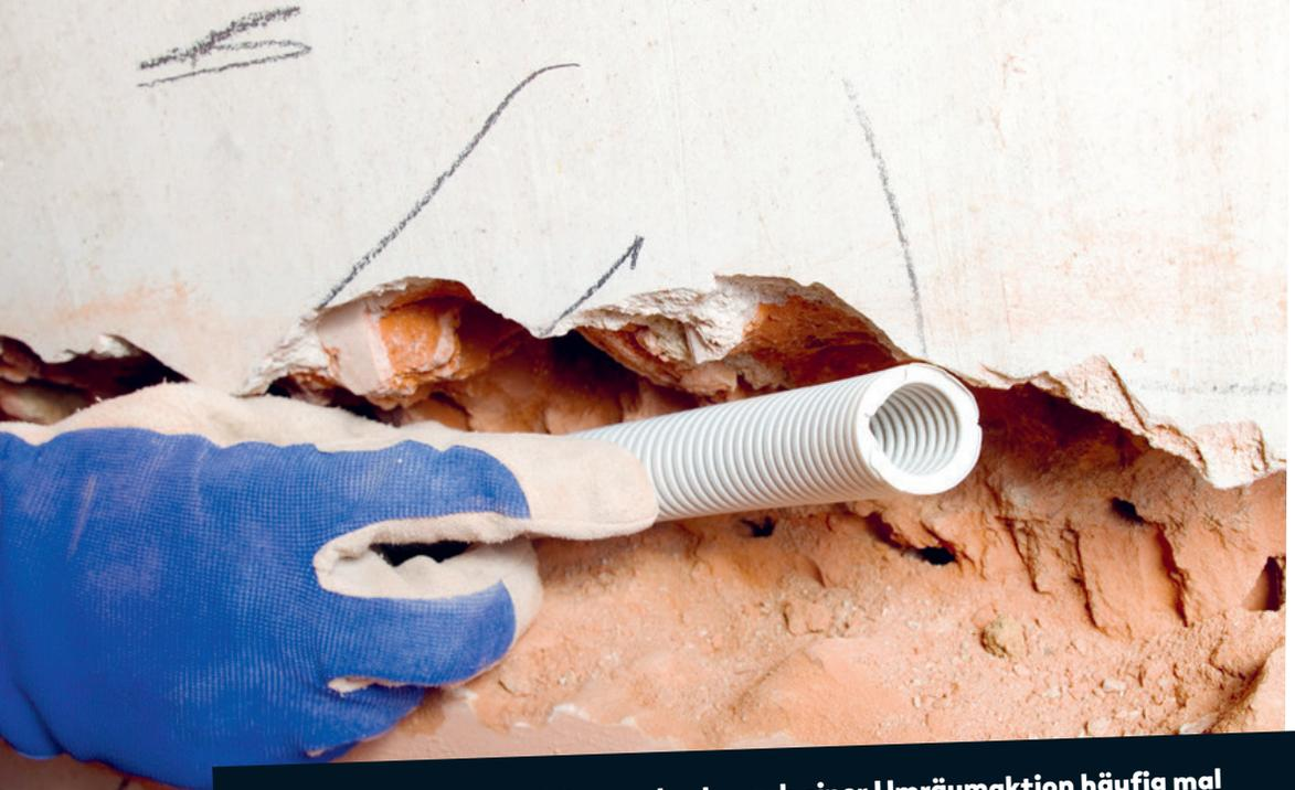
**Fernseher, Telefon und Co. wechseln nach einer Umräumaktion häufig mal den Platz - und wie ärgerlich ist es dann, wenn an der neuen Stelle keine Steckdose ist und das Kabel durch den halben Raum verlegt werden muss. Plane deswegen bei Neuinstallationen immer Leerrohre ein. In ihnen können Kabel versteckt verlegt werden, ohne dass man viel Aufwand betreiben muss. Um das Kabel später unkompliziert durch das Rohr zu bekommen, solltest du zudem einen Zugdraht mit einlegen.**
