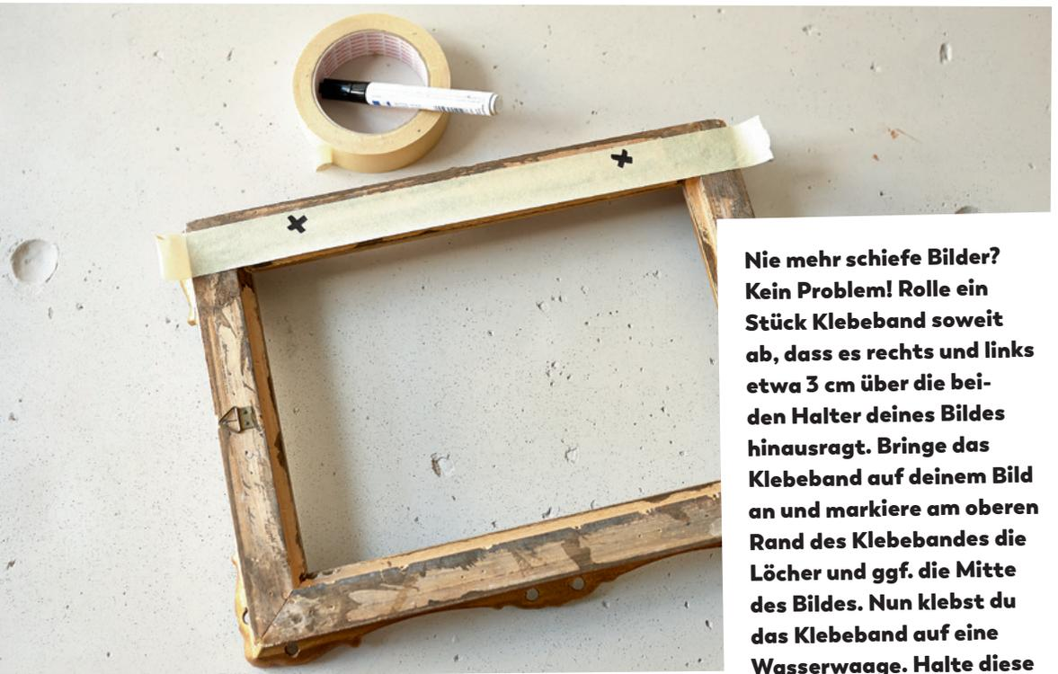
**Nie mehr schiefe Bilder? Kein Problem! Rolle ein Stück Klebeband soweit ab, dass es rechts und links etwa 3 cm über die beiden Halter deines Bildes hinausragt. Bringe das Klebeband auf deinem Bild an und markiere am oberen Rand des Klebebandes die Löcher und ggf. die Mitte des Bildes. Nun klebst du das Klebeband auf eine Wasserwaage. Halte diese an die Wand und richte sie aus. Über den Markierungen auf deinem Klebeband kannst du nun die Löcher setzen.**
