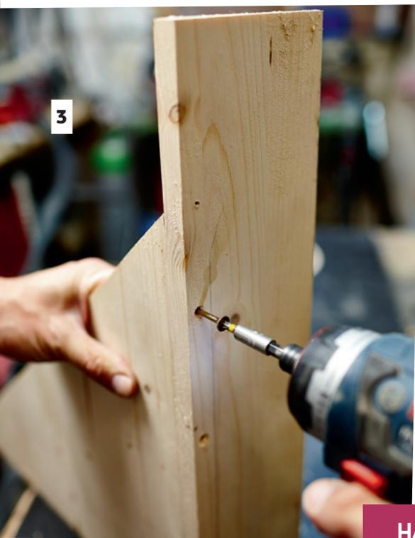
**3** Jetzt kannst du das Werkstück mit Leim versehen und mit dem anderen Werkstück zusammenschrauben. Passt perfekt!
