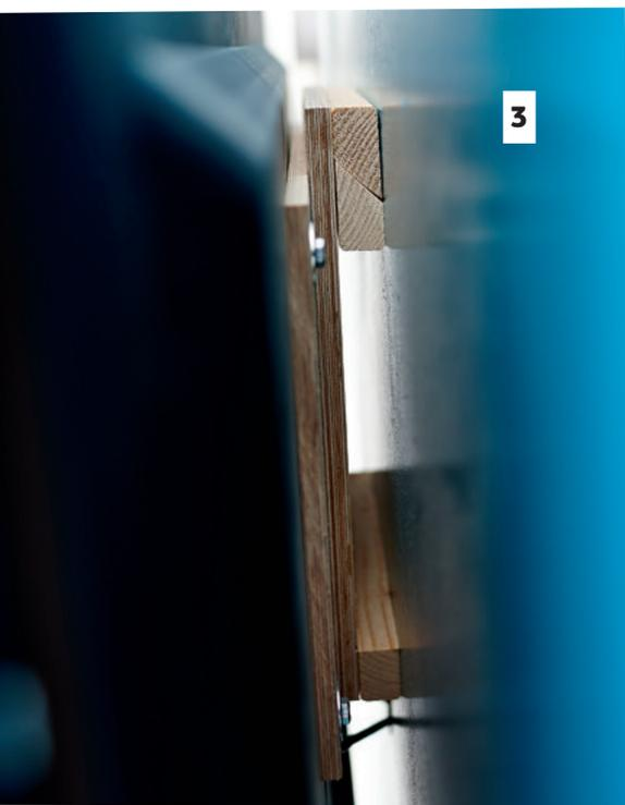
**3** Die andere Leiste wird mit dem entsprechenden Gegenstand verbunden. Wie, das hängt vom Gewicht des Gegenstandes ab. An leichtere Sachen kannst du die Leiste einfach mit Heißkleber anbringen. Schwerere Gegenstände, wie z. B. einen Fernseher, solltest du vorher auf eine Platte schrauben, an die du dann die Leiste montierst.
