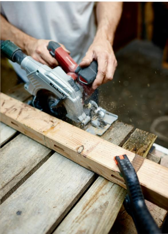
**Kreissäge:** Schneller geht es mit der Kreissäge. Säge an einer Leiste die Bretter längs zum Trägerbalken ab. Achte darauf, nicht in die Nägel zu sägen! Diese Methode geht zwar schneller, aber die Bretter sind dafür deutlich kürzer.
