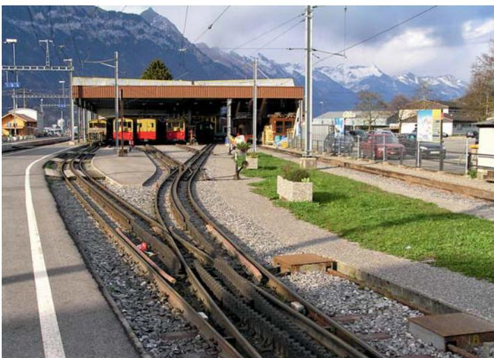
Ein Blick auf die 800-Millimeter-Anlagen des Vorbilds: Fünf Gleise führen in die moderne Fahrzeughalle der Schynige-Platte-Bahn.
