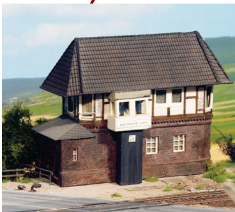
■ Stellwerk Bad Driburg Ost (Do): Die Königlich Preußische Eisenbahngesellschaft errichtete 1911 das mechanische Stellwerk Do. Sein Untergeschoss besteht aus Ziegelstein und das Obergeschoss aus Fachwerk. Weichen und Signale wurden per Drahtseilzug gestellt, die Schranken per Hand gekurbelt. Bis 2008 war Do in Betrieb, heute ist es der Vereinssitz der Bad Driburger Eisenbahnfreunde.
