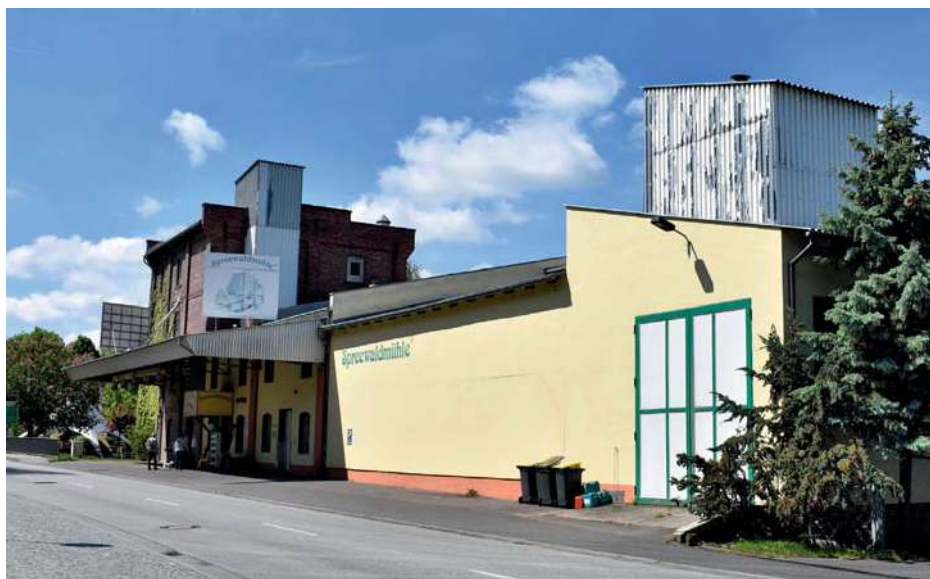
In Burg im Spreewald fand sich die Inspirationsquelle. Die „Spreewaldmühle“ kann auf eine über 700-jährige Geschichte zurückblicken und steht (wieder) voll in Betrieb.
