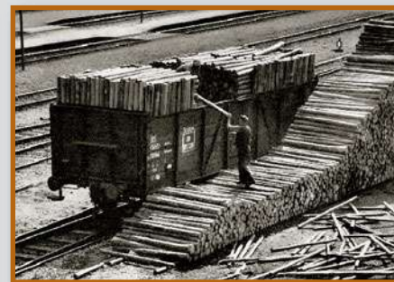
Noch bis weit in die Epoche III hinein verlud man Grubenholz für Zechen mit der Hand, denn so konnte man in offenen Güterwagen die Ladung vorschriftsgemäß verstauen. Foto: Archiv der Eisenbahnstiftung
