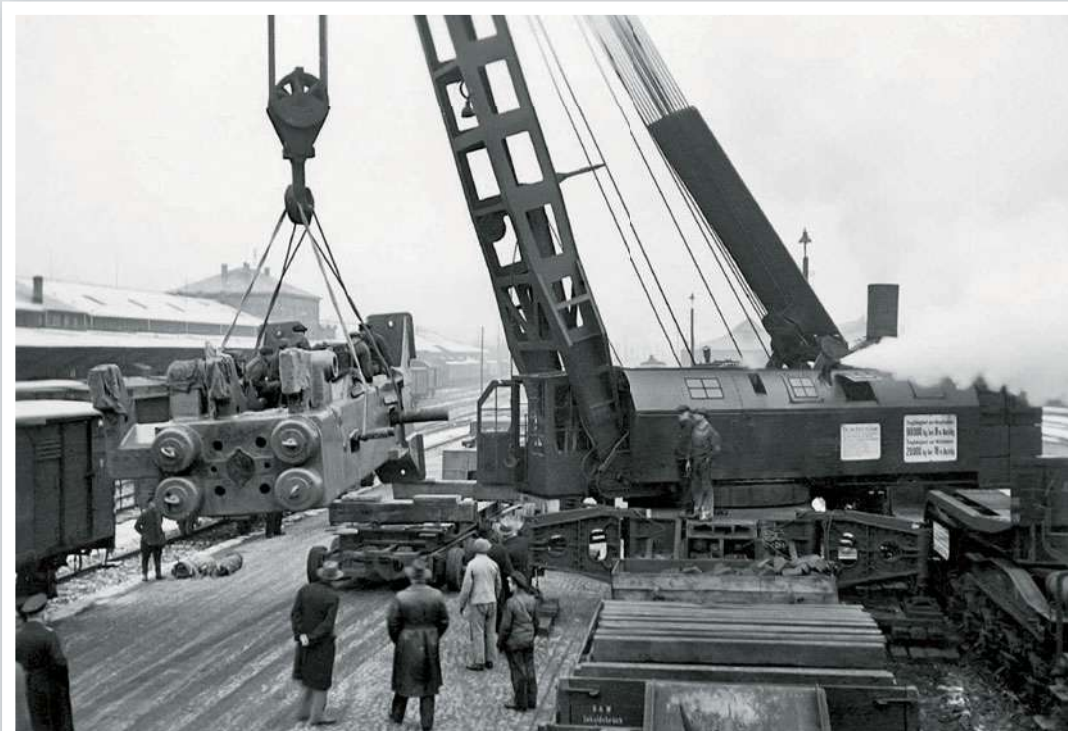
Manchmal ging es selbst an der Ladestraße spektakulär zu, wenn besonders schwere und sperrige Güter von der Bahn auf die Straße verladen wurden. Der damals kräftigste Kran der Bahn, ein 90-t-Dampfkran, wurde für diesen Einsatz extra herbeigeschafft. Foto: Archiv der Eisenbahnstiftung
