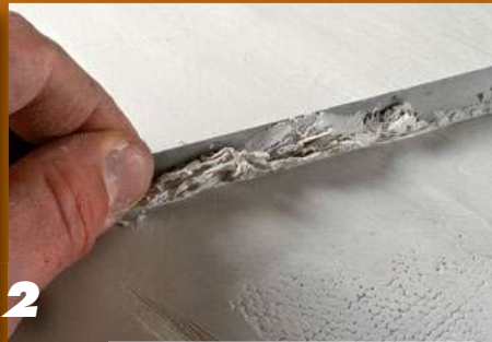
2 Den zur Verfüllung der dicken Teile aufgetragenen Gips schabt man an den Spörle-Gipsplattenkanten glatt.
