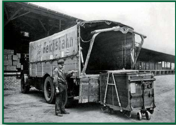
Bahneigene Entwicklungen wie fahrbare Boxen sollten bei der Reichsbahn die Zulieferung zum Kunden vereinfachen. Sie waren die Vorläufer der Haus-zu-Haus-Behälter und späteren Container. Foto: RVM, Archiv der Eisenbahnstiftung
