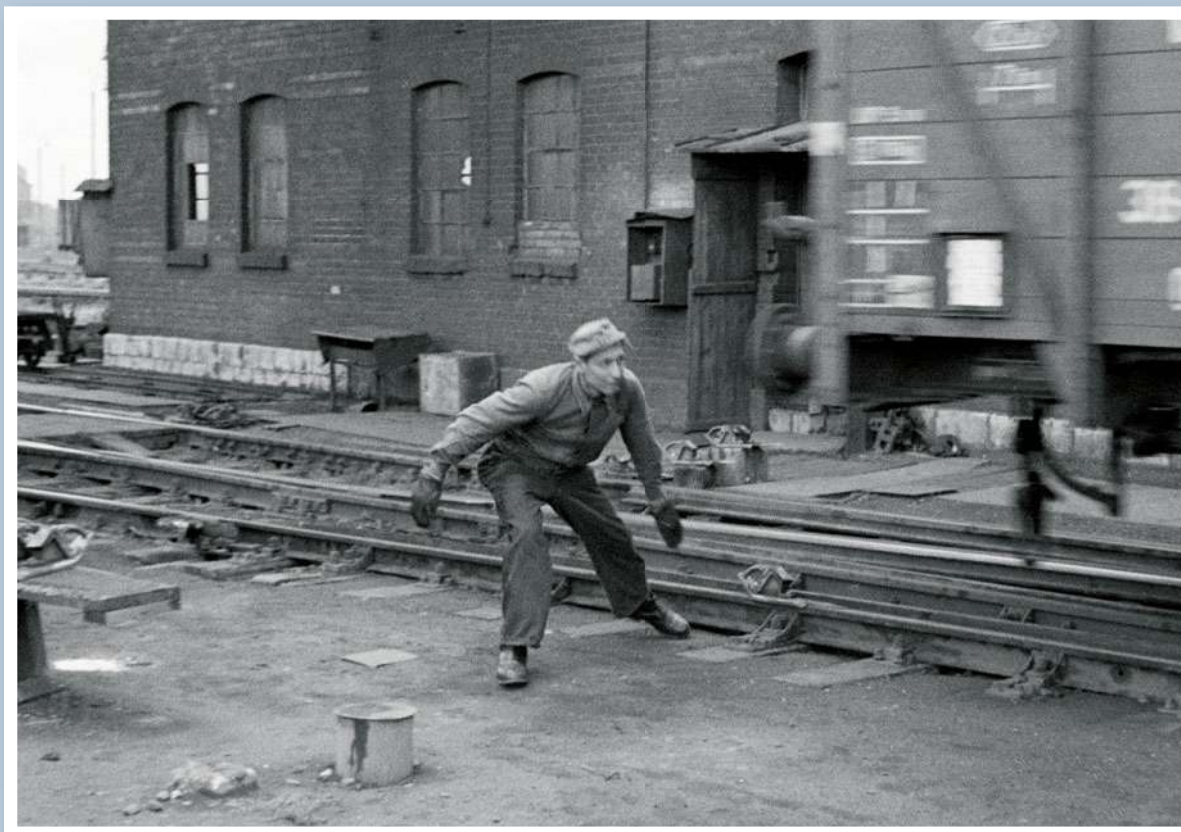
Die Arbeit eines Hemmschuhlegers verlangt Aufmerksamkeit und Schnelligkeit, um den Hemmschuh richtig zu platzieren und einen Unfall zu vermeiden. Foto: RBD Erfurt, Sammlung Leikra
