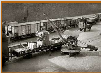
Ein mobiler Drehkran erweiterte den Aktionsradius, denn der Güterwagen musste nicht nur an der Laderampe stehen. Allerdings waren diese Kräne in den Epochen I und II die Ausnahme. Foto: Archiv der Eisenbahnstiftung
