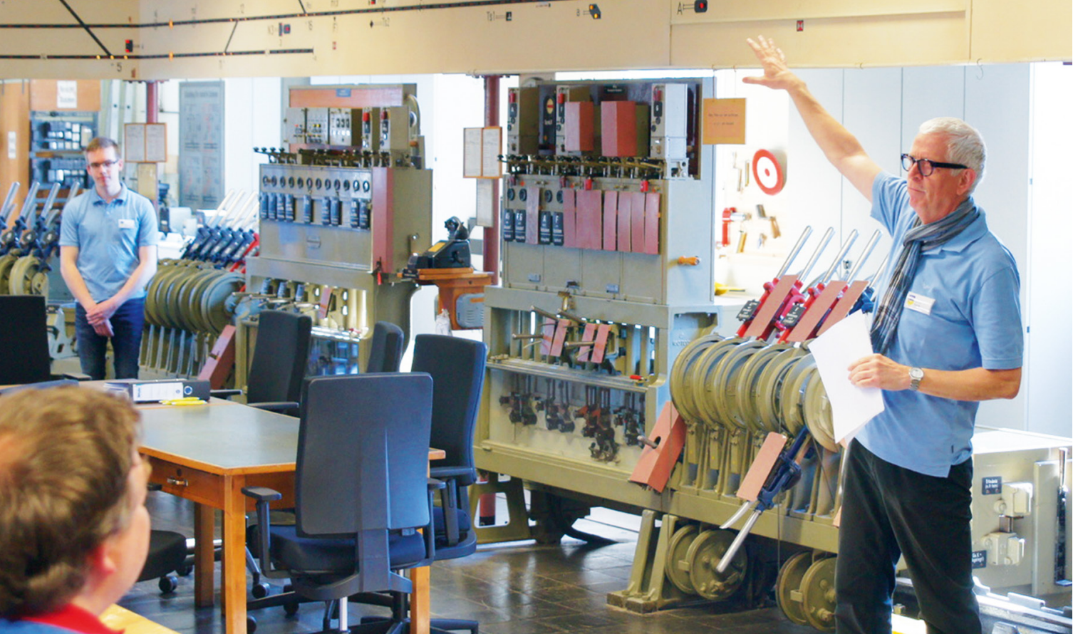
Foto: Lehrstellwerk Kornwestheim
