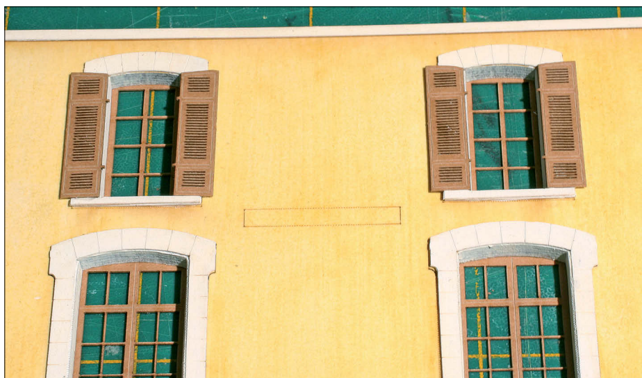
11-Pose des volets à l'étage, ici en position ouverte...
