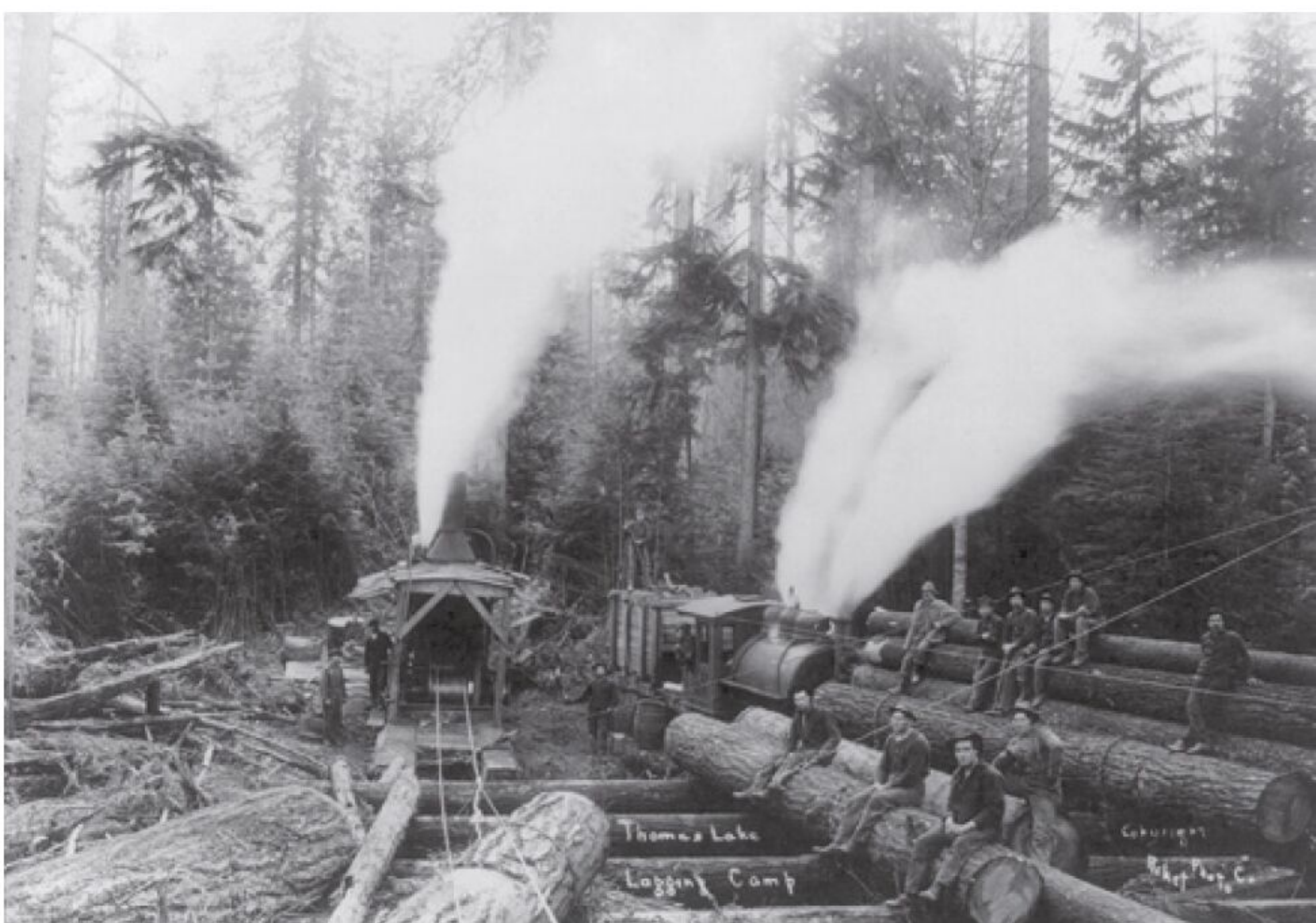
Met een stoomlier worden boomstammen naar het verzamelpunt gesleept en op de trein geladen.
