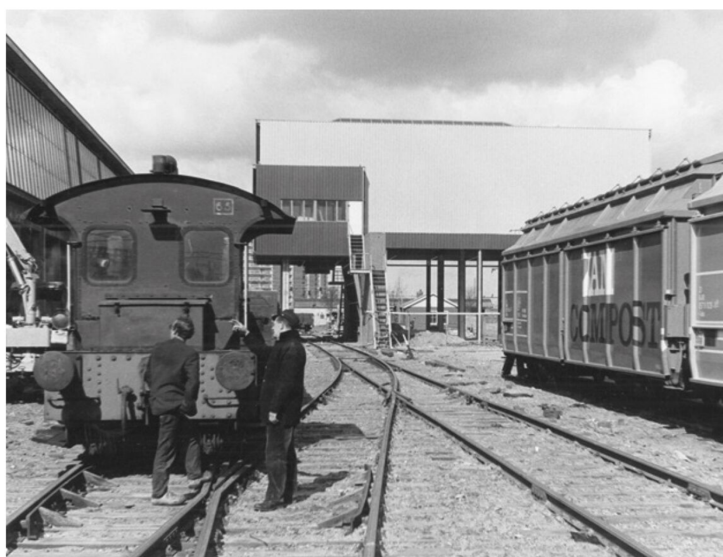
Het overlaadstation van Schiedam werd ten noorden van het NS-station gebouwd. Op deze foto is duidelijk te zien dat het gebouw uit een stalen constructie bestaat. De groene Sik en de oude VAM-wagens plaatsen deze foto rond 1970.
