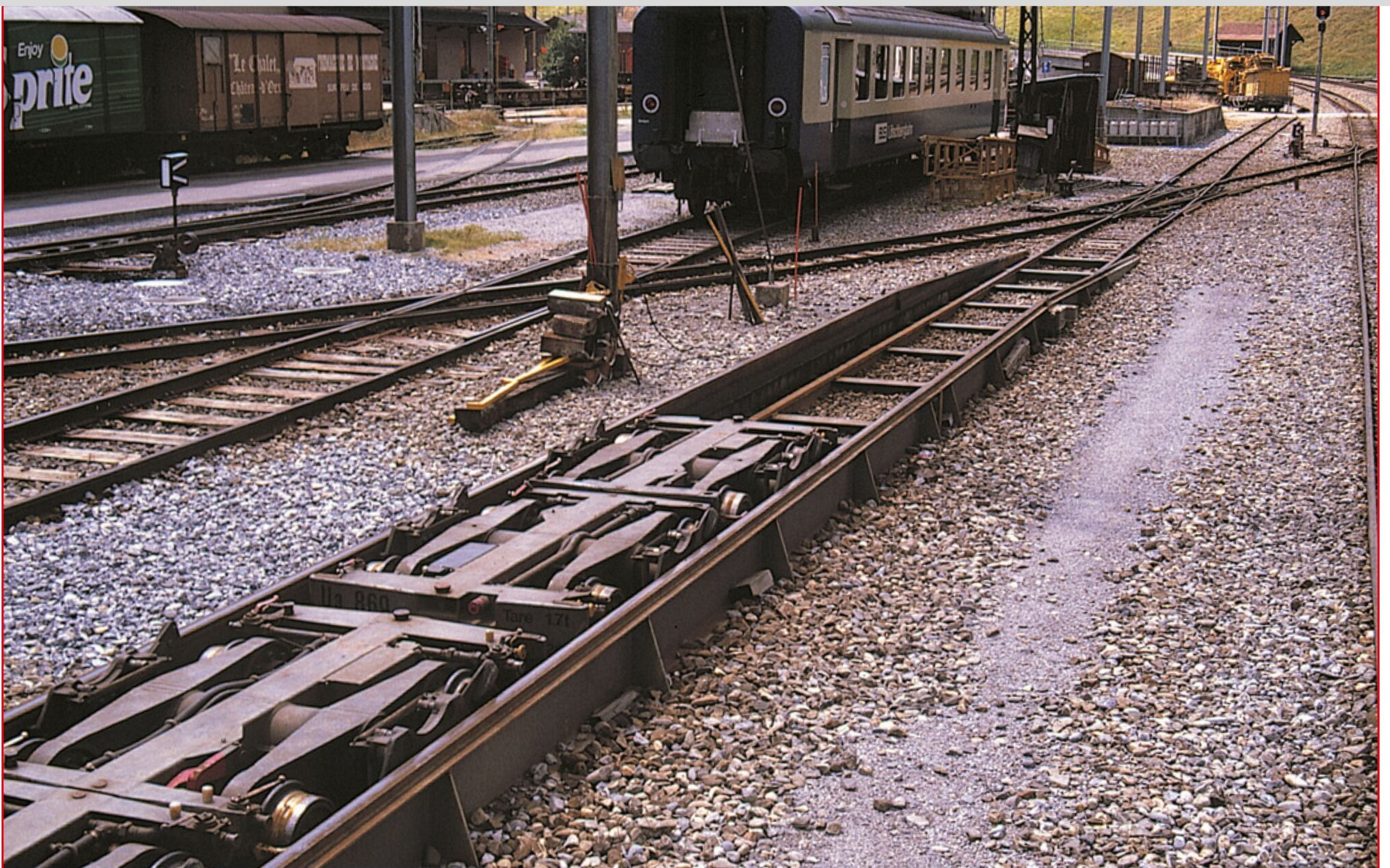
Direct voor het rolbokspoor een Engels wissel. Het normaalspoor links van de BLS wordt door het smalspoor van de MOB gekruist. Zweisimmen, juni 2000.
