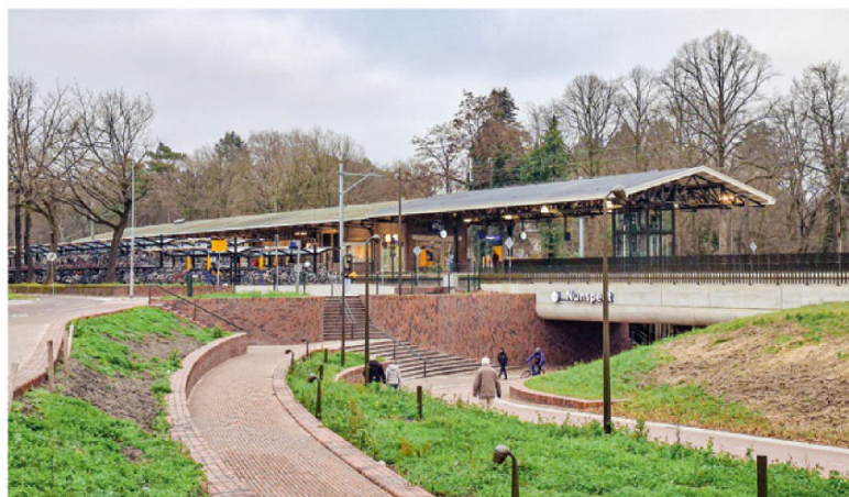
De onderdoorgang voor fietsers/voetgangers en de gerestaureerde perronkap, westelijk hiervan ligt de autotunnel. Nunspeet, 23 december 2025. (foto Harold van der Meer)
