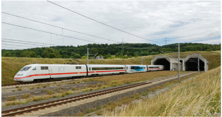
Testtreinstel ICE-S verlaat op 28 juni de Finnetunnel op de HSL Erfurt - Leipzig/Halle. (foto Frank Barteld, Deutsche Bahn AG)
