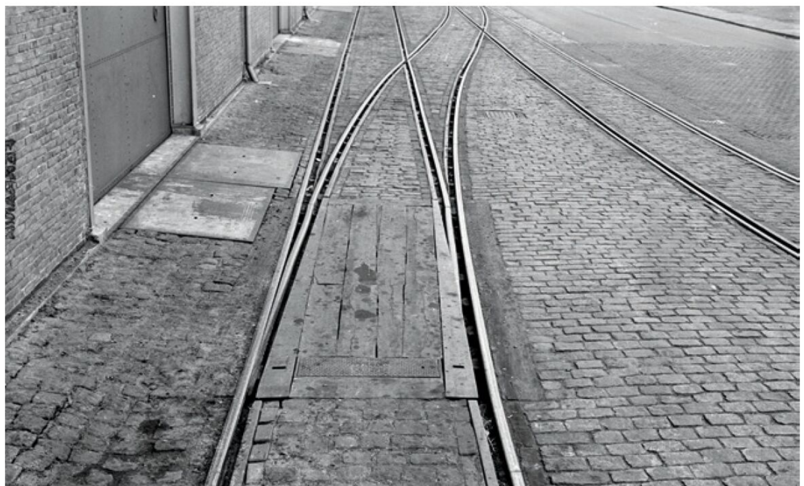
Wissel in straatspoor in de Rietlanden in Amsterdam, 17 februari 1954. (foto NS, W.P.F.M. Schaik, collectie Het Utrechts Archief)
