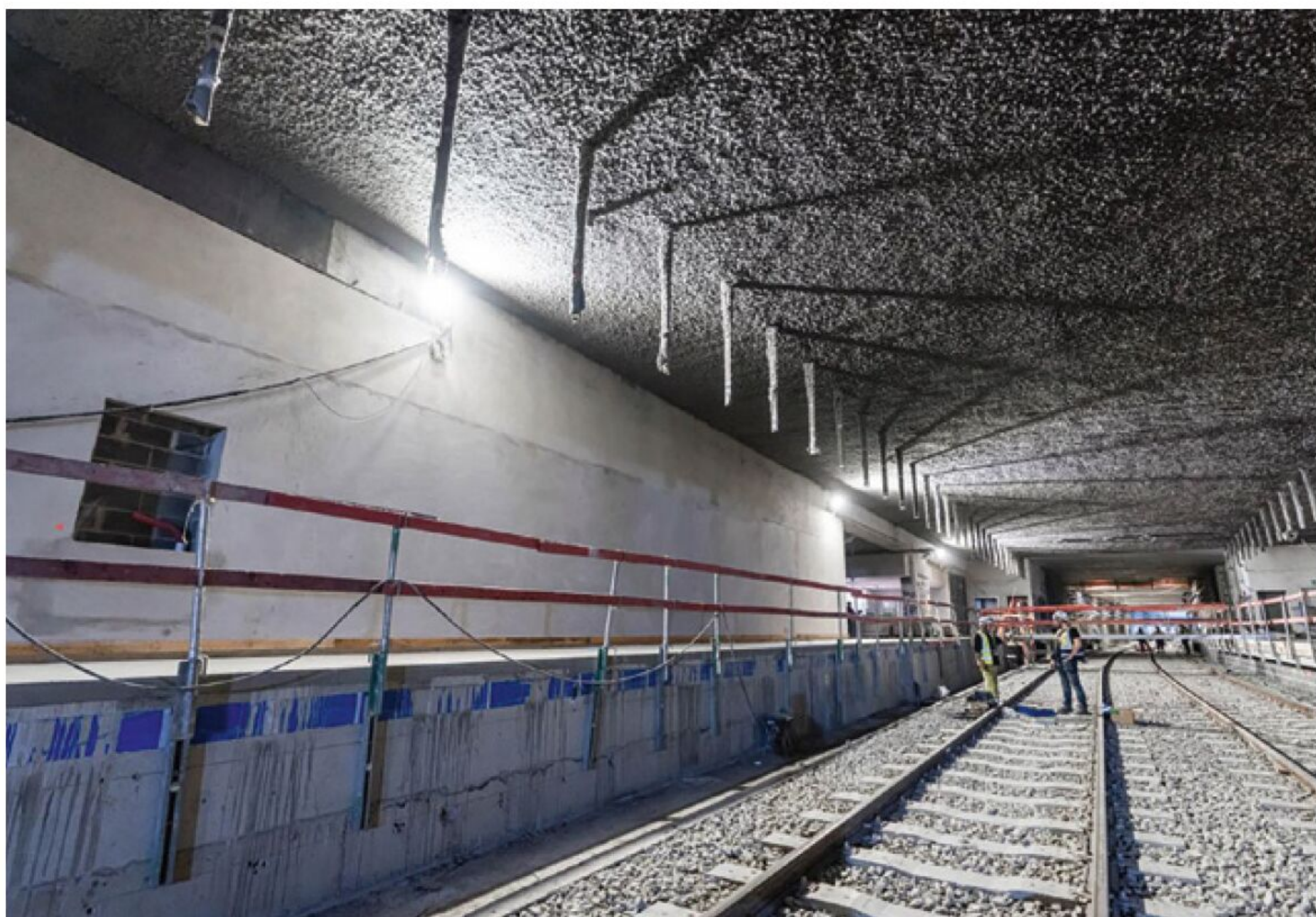
Werkzaamheden aan het perron van de eindhalte van Metro 3, station Albert op niveau -2. (foto MIVB)
