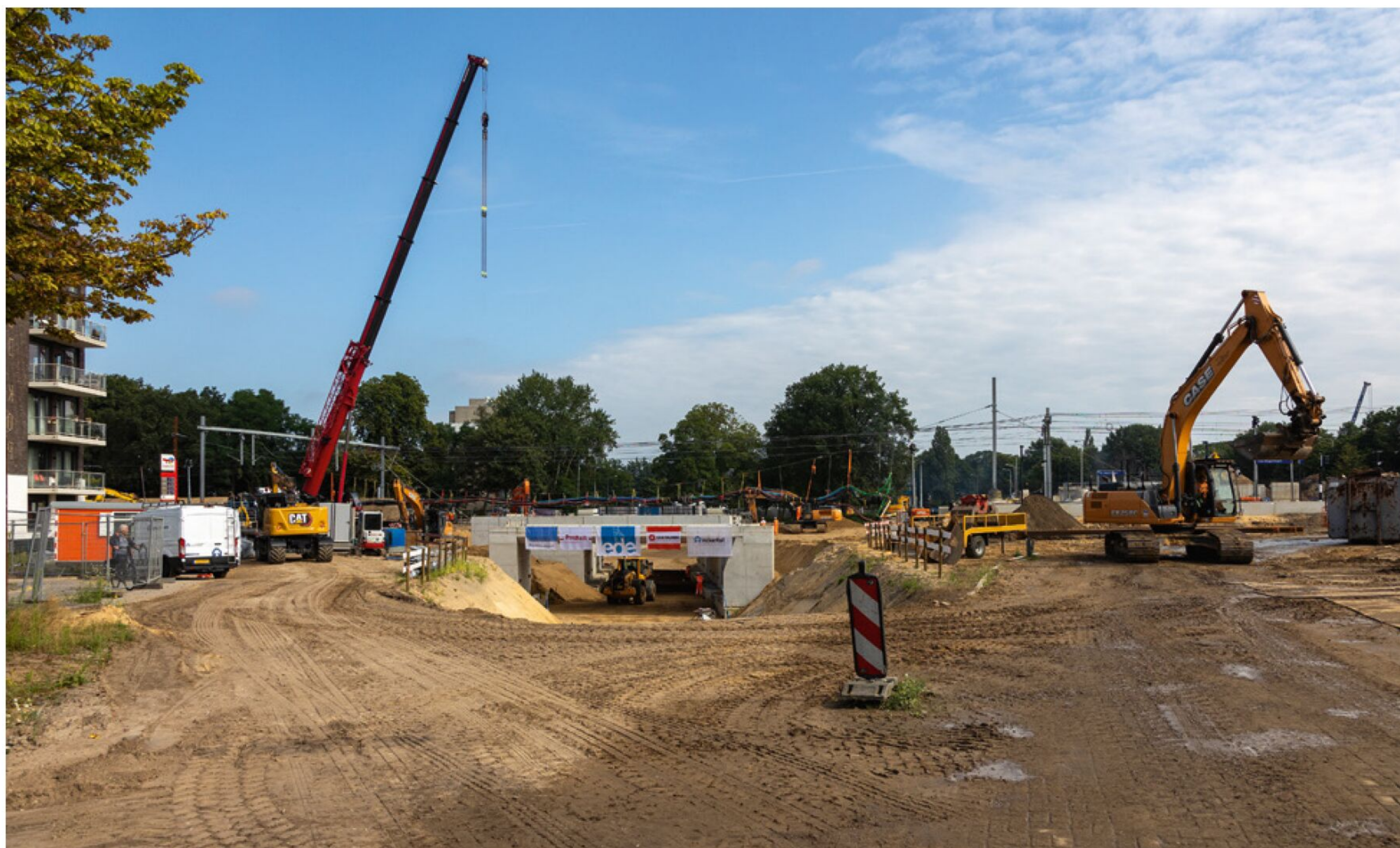
De nieuwe fiets- en voetgangerstunnel is ingeschoven en zal Ede noord en zuid straks met elkaar verbinden, 5 augustus. (foto Harold van der Meer)
