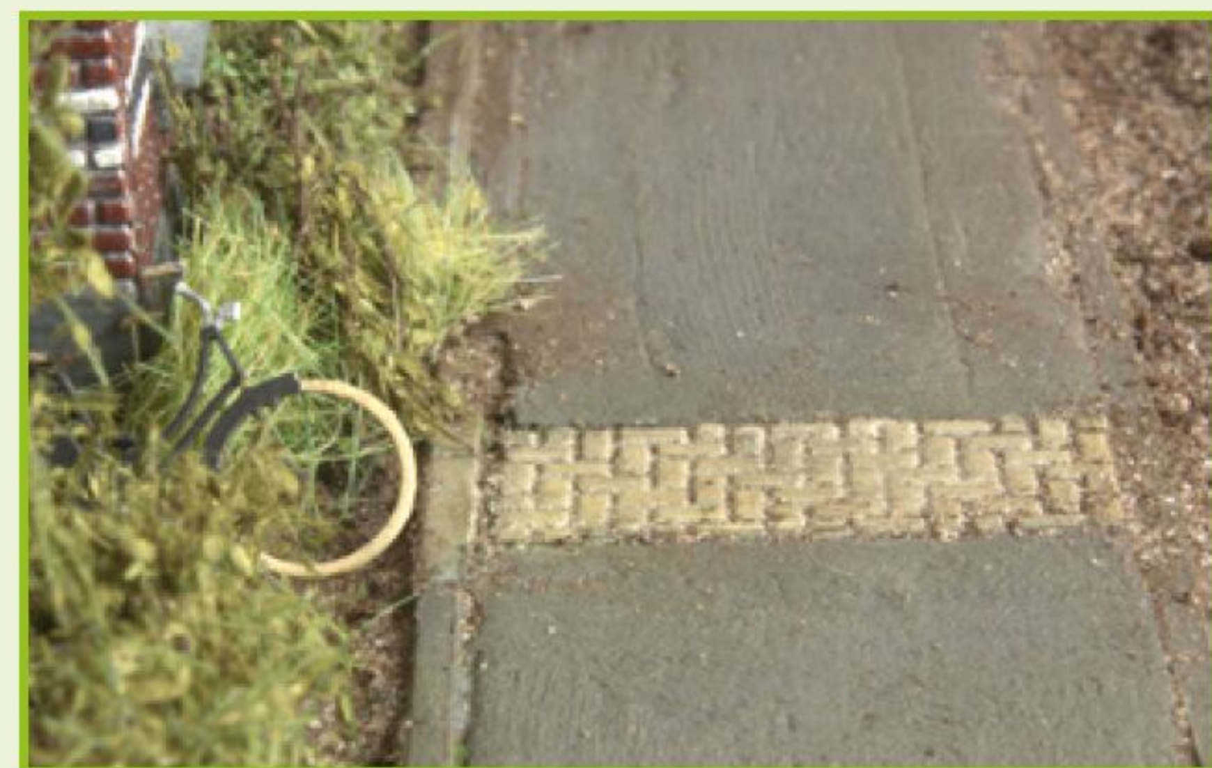
Een reparatie door middel van klinkers.
