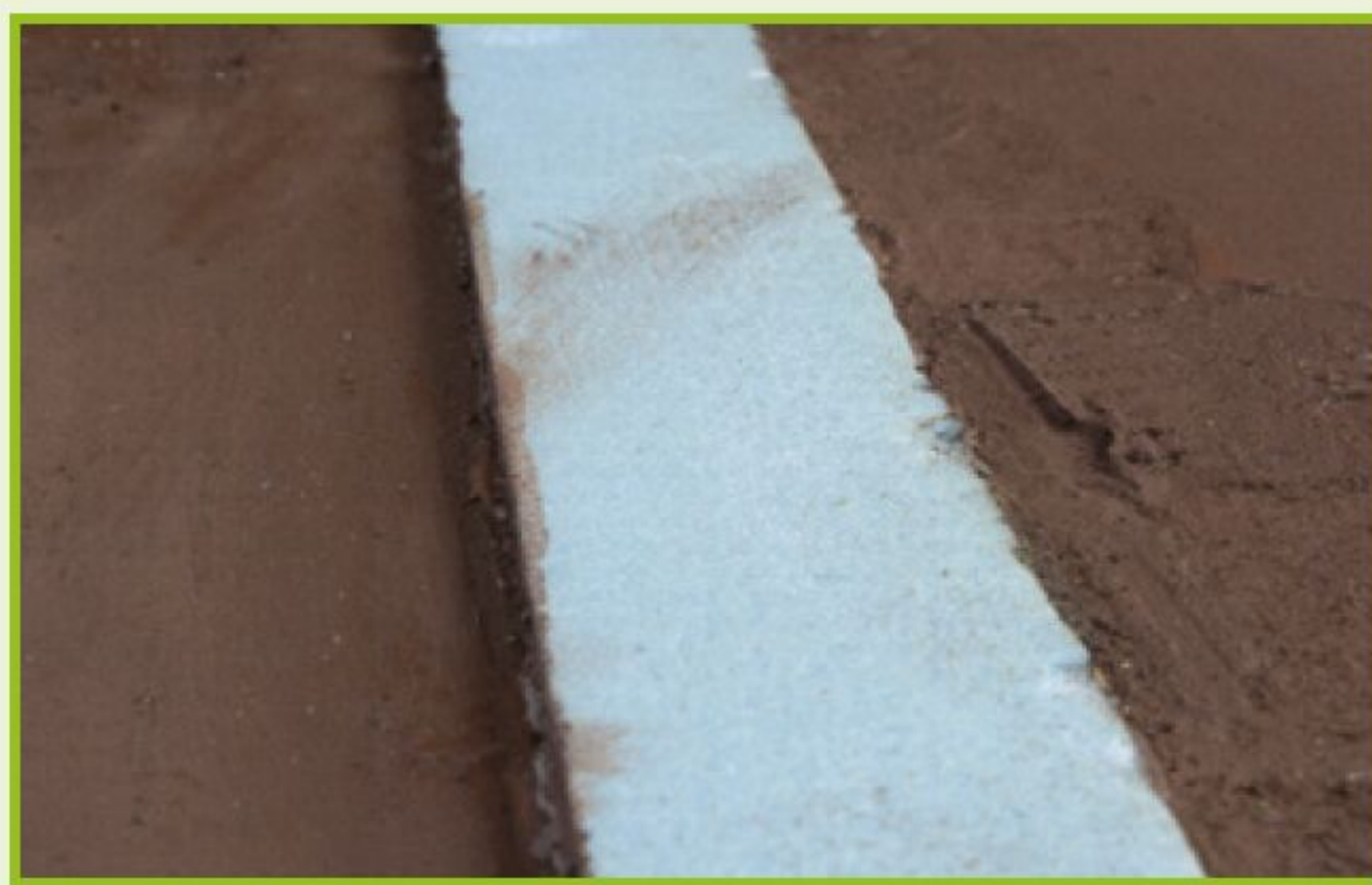
De basis van een oude asfaltweg.
