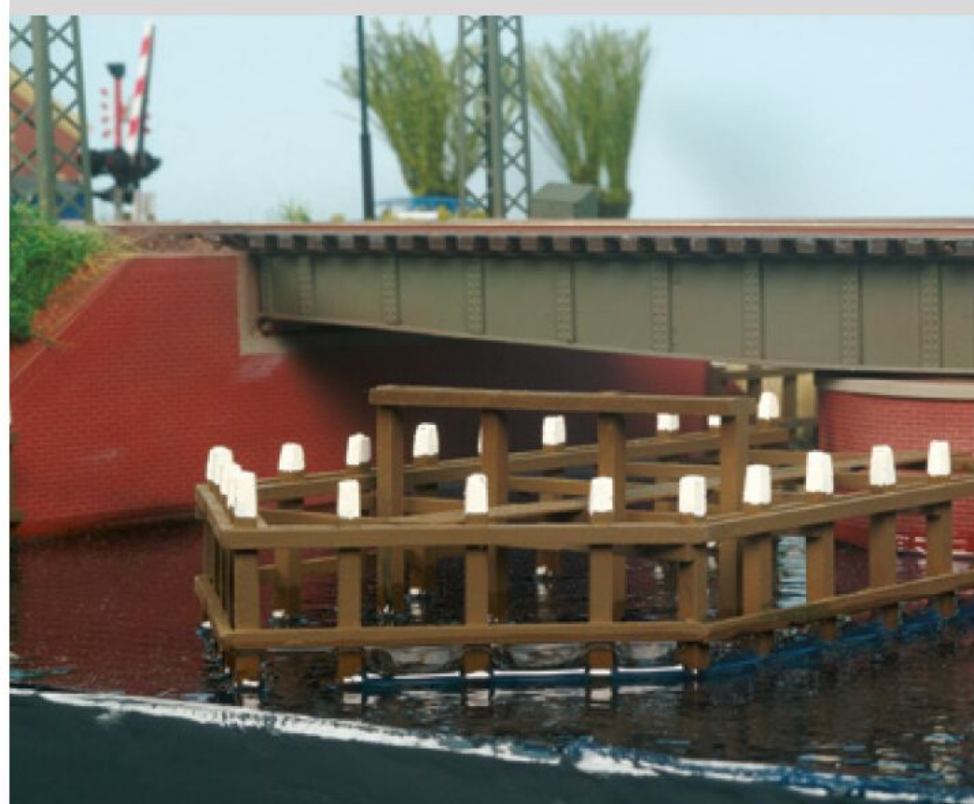
Het remmingwerk is vrij uitgebreid om ook bij een geopende brug de klap te kunnen opvangen.
