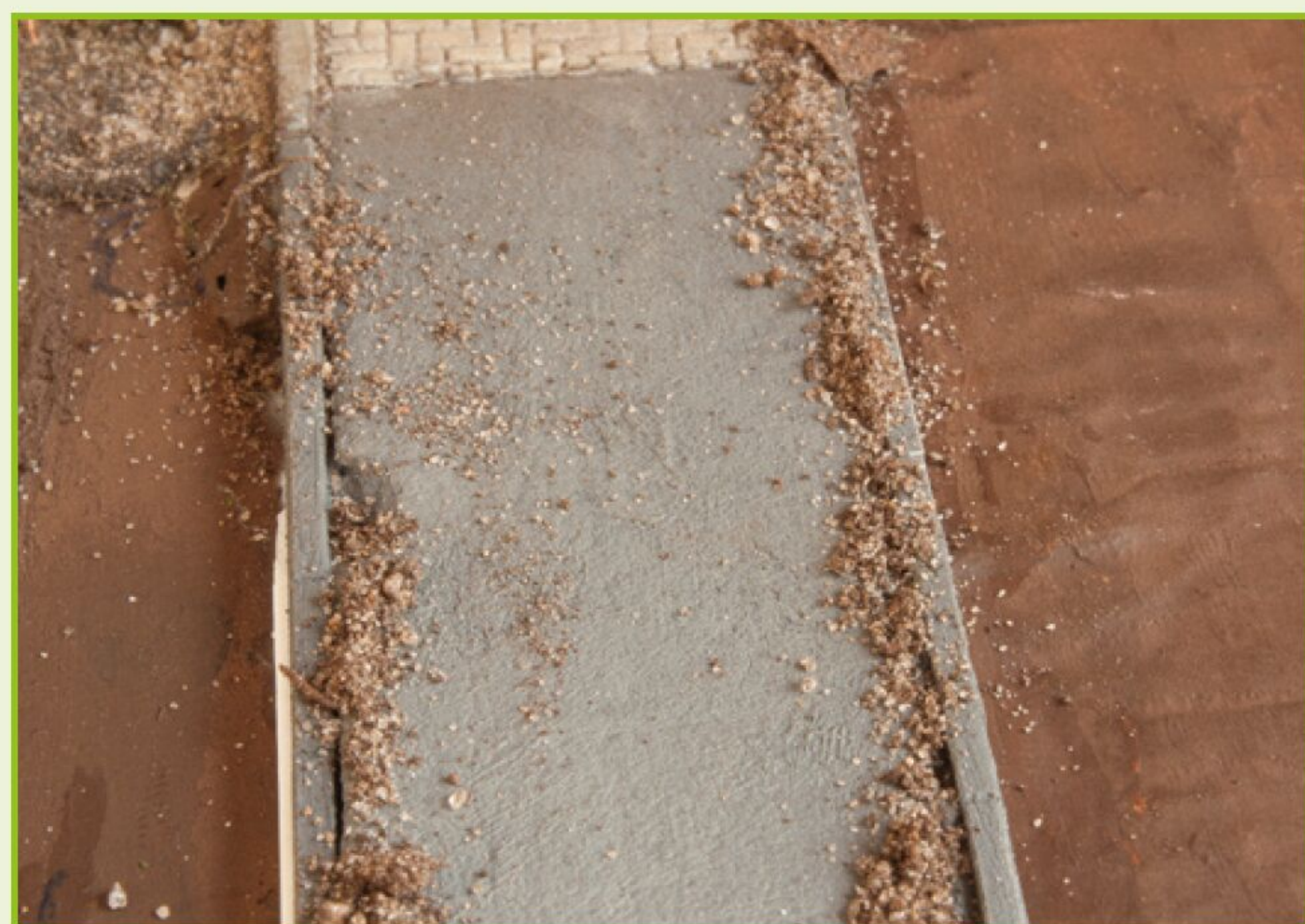
Het aanbrengen van het zand aan de zijdes van de weg.
