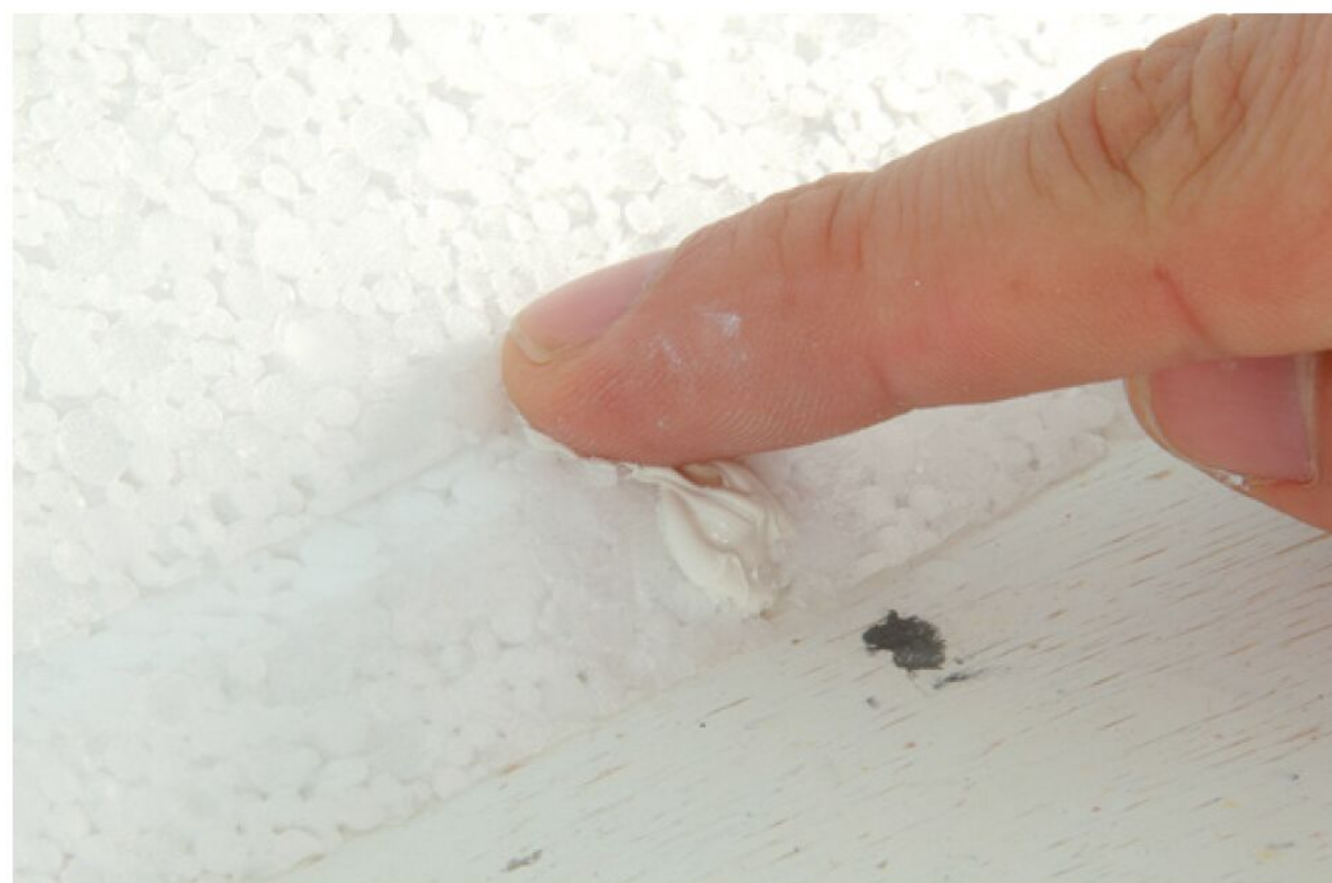
Gaten en kieren worden opgevuld met Poly-Max.
