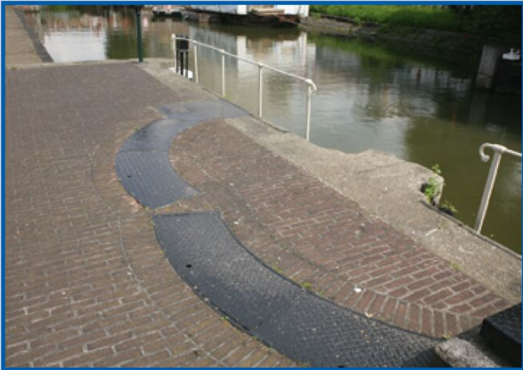
Deze sluis heeft een elektrische bediening gekregen.
