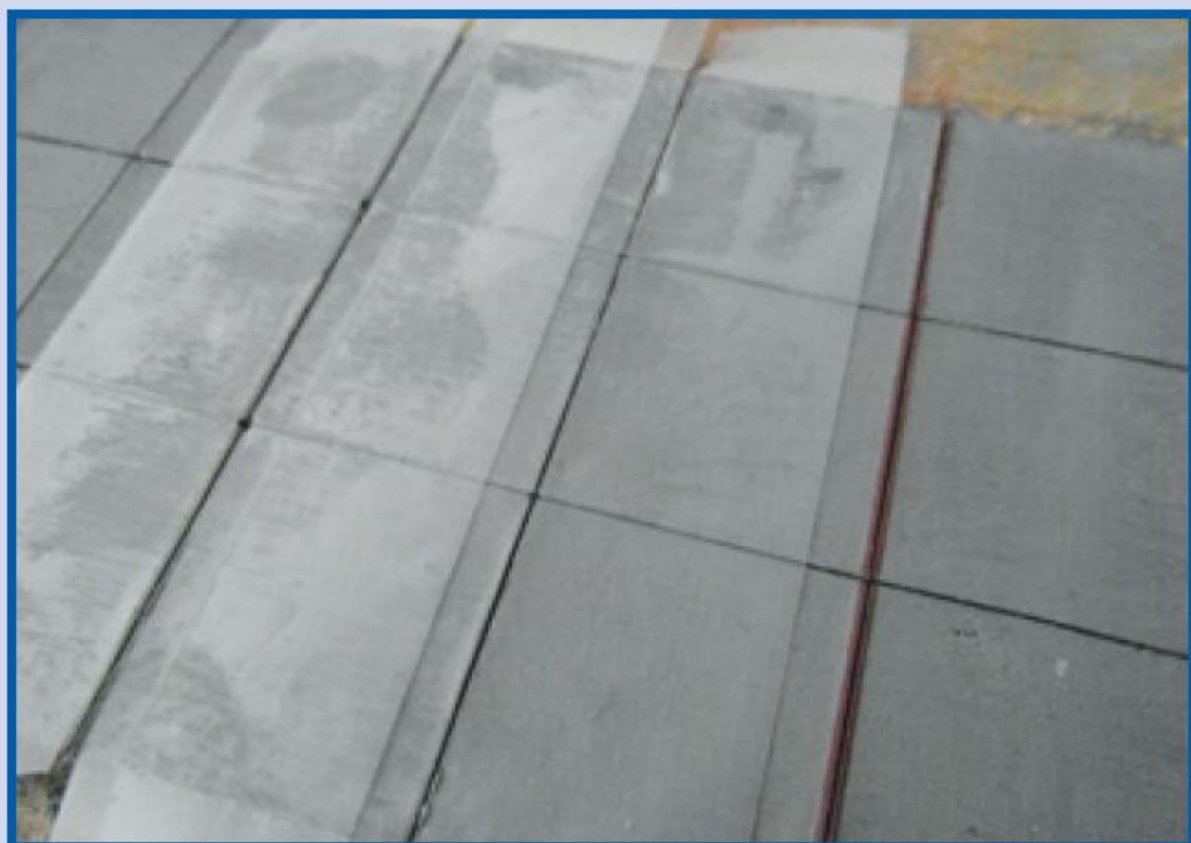
Als alle lijnen zijn getrokken kunnen de stelconplaten worden geschilderd. Na verwijderen van de tape blijft een strakke 'metalen' rand over.
