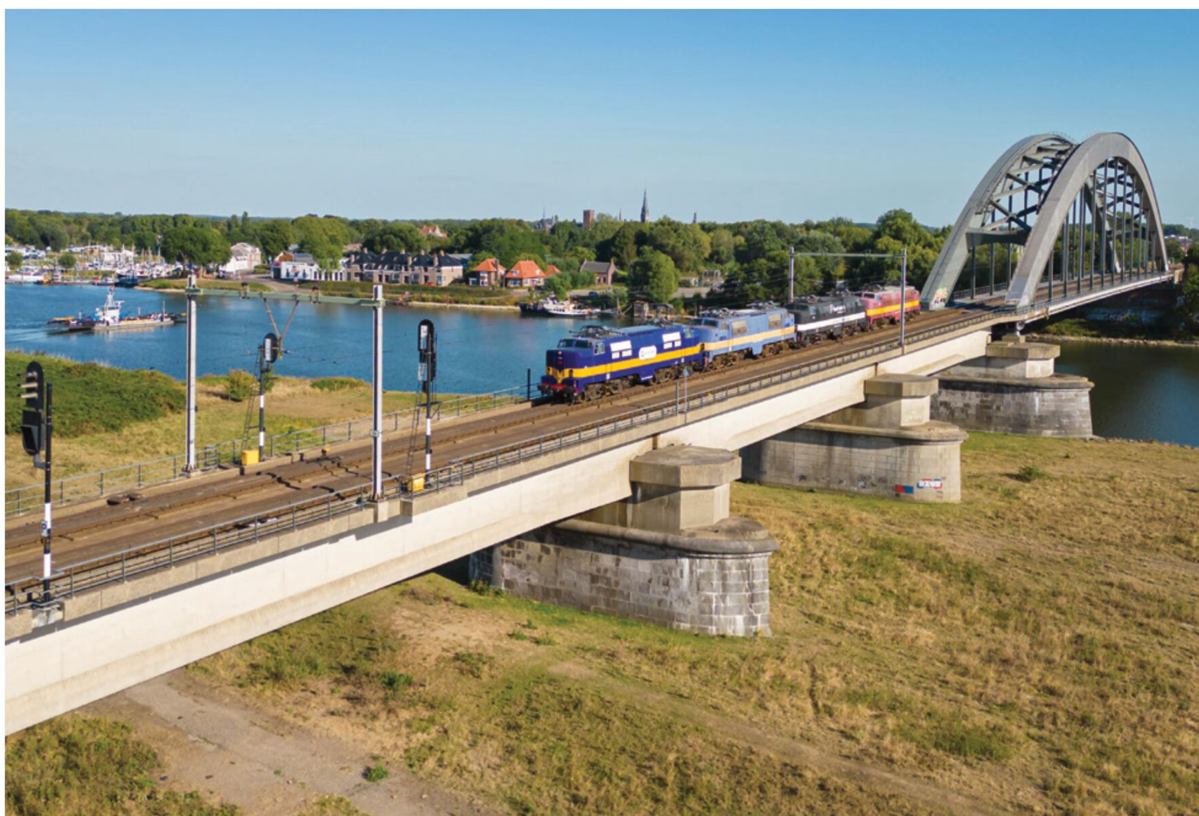
De bonte verzameling 1200'en op de Kuilenburgse spoorbrug uit 1983 over de Lek bij Culemborg op 1 september. (foto Harold van der Meer)
