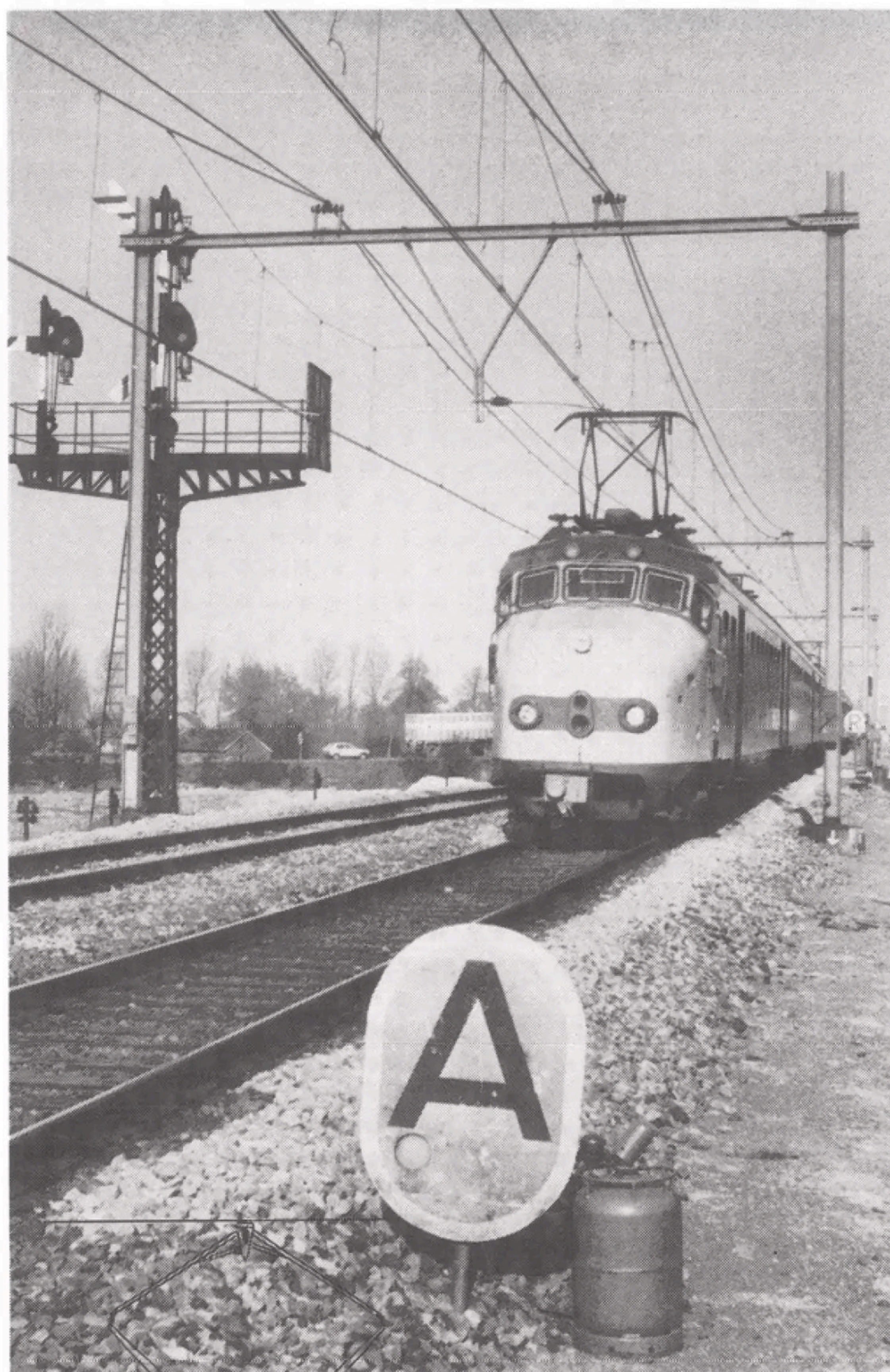
El-4 718, links rijdend in verband met de aanleg van dubbelspoor op het traject Oss-Wijchen. Het A-bord geeft de aanvang aan van een tijdelijk langzaam te berijden baangedeelte, het fraaie vakwerkbordessein is inmiddels verdwenen. Ravenstein, 20 maart 1981. (foto CvG)
