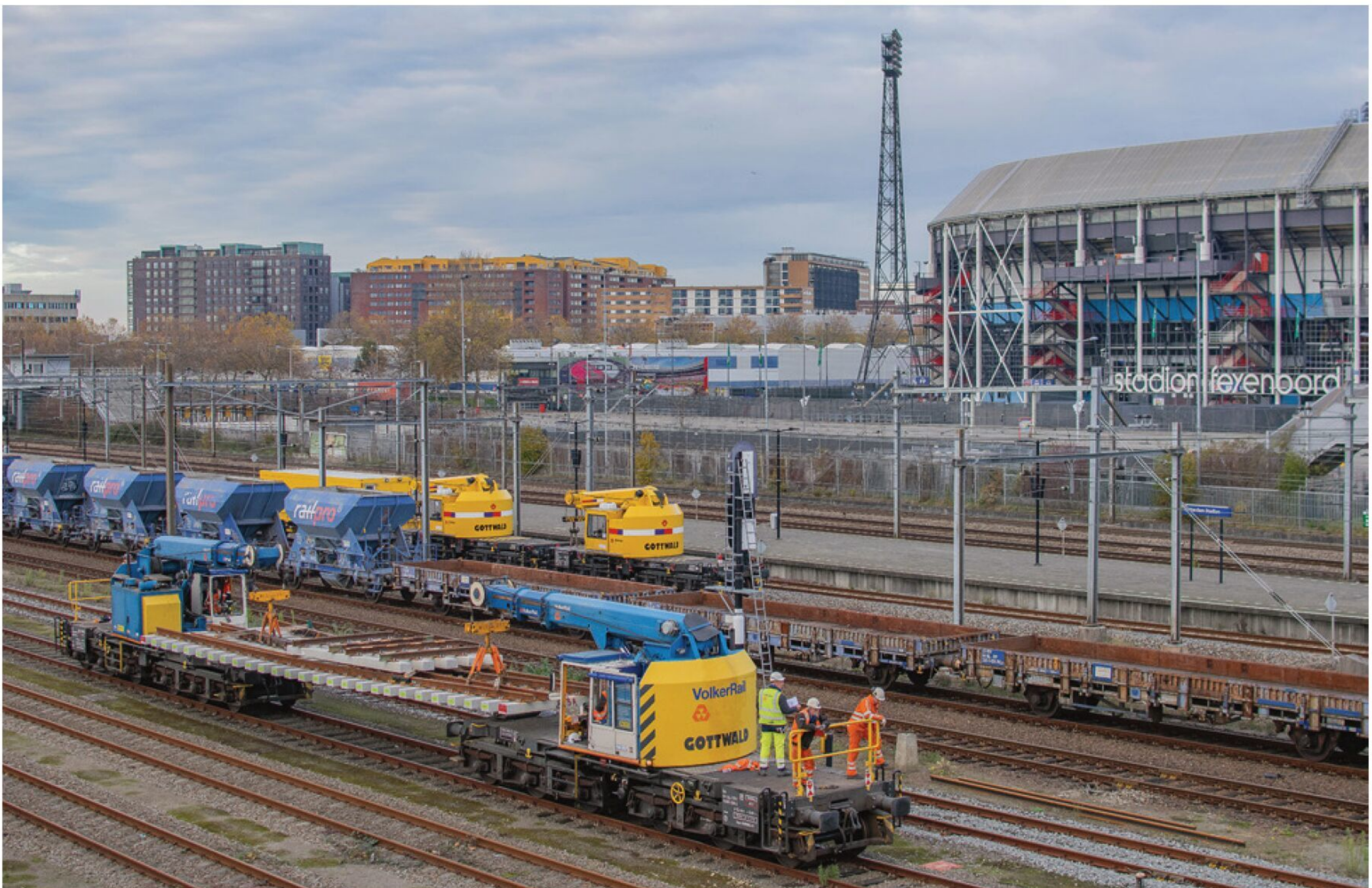
De Gottwald-kranen van VolkerRail zijn met een afgebouwd wissel bij Rotterdam Stadion onderweg, 9 november 2020. (foto Sander Broerse)
