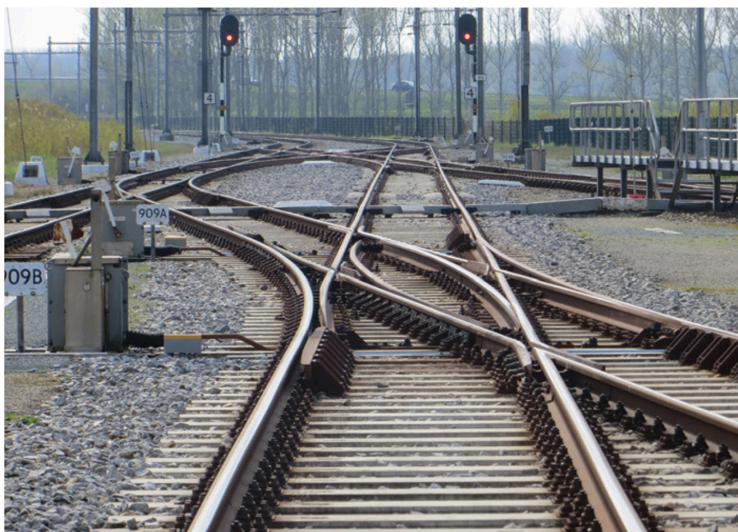
Emplacement Lelystad, gebouwd met spoorstaven UIC54 / 54E1, 2016. (foto Ton Oosterom)
