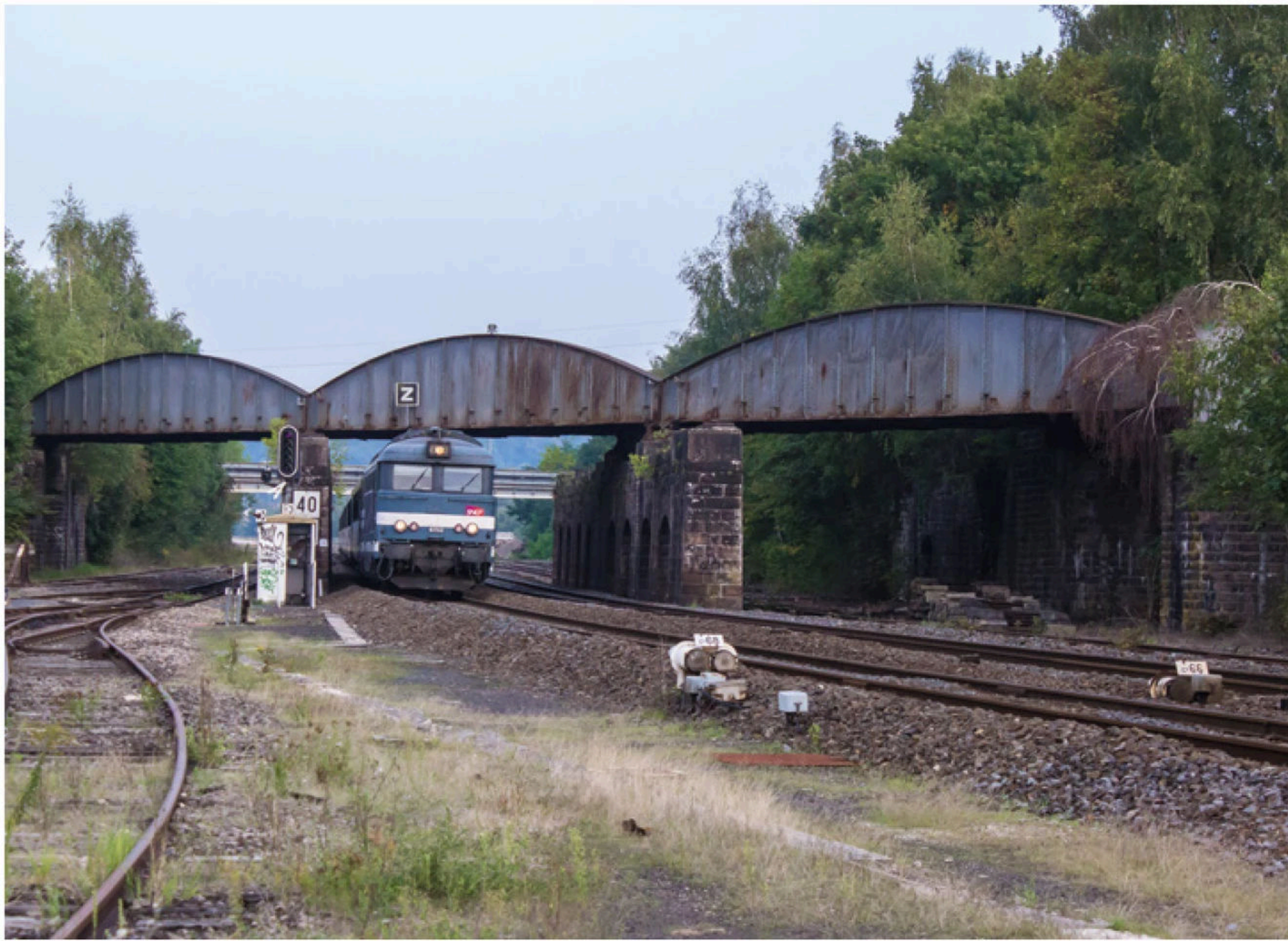
KRÜGER: stalen boogbrug.
