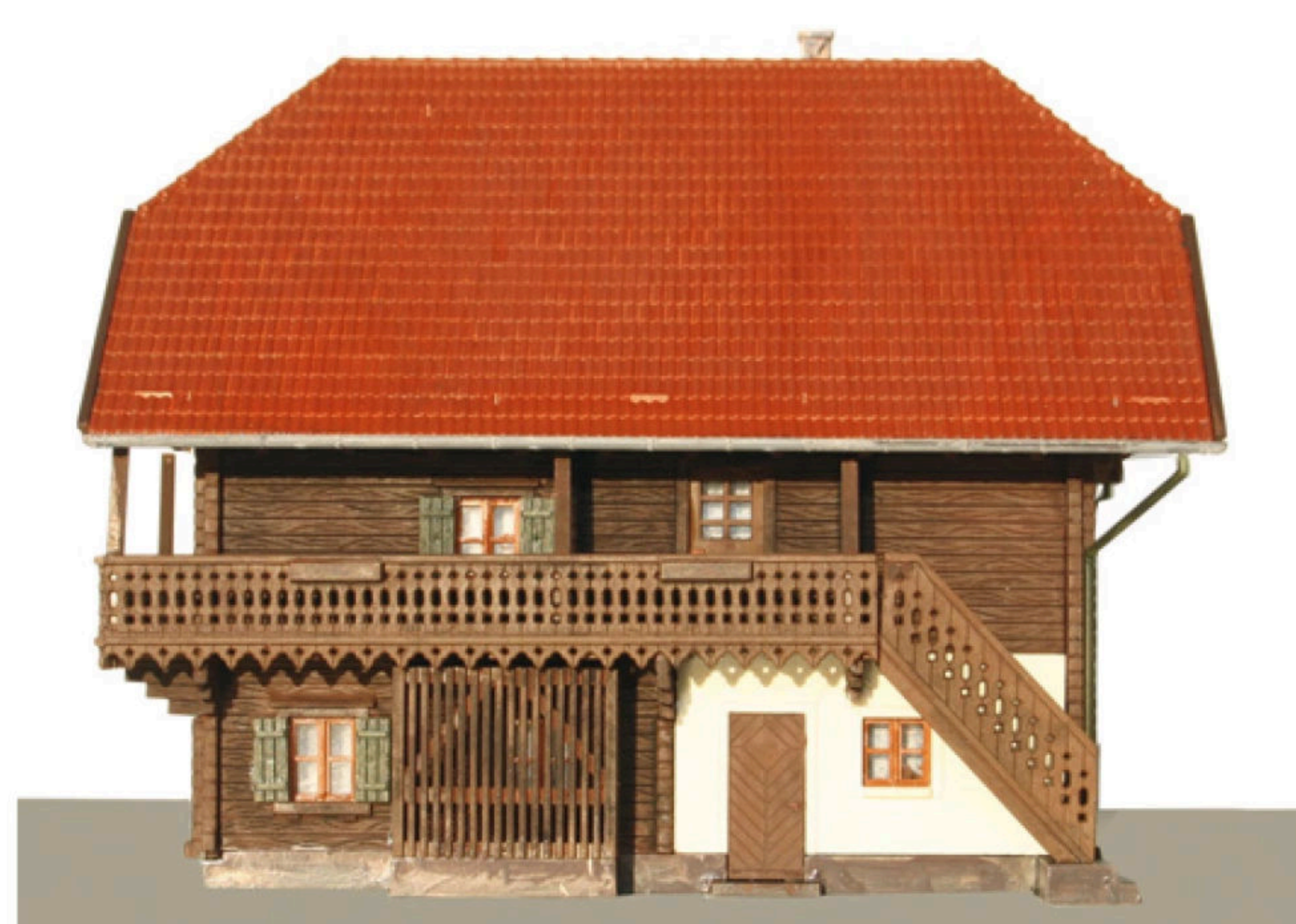
De toegangstrap naar de galerij rust op een stenen fundament.
