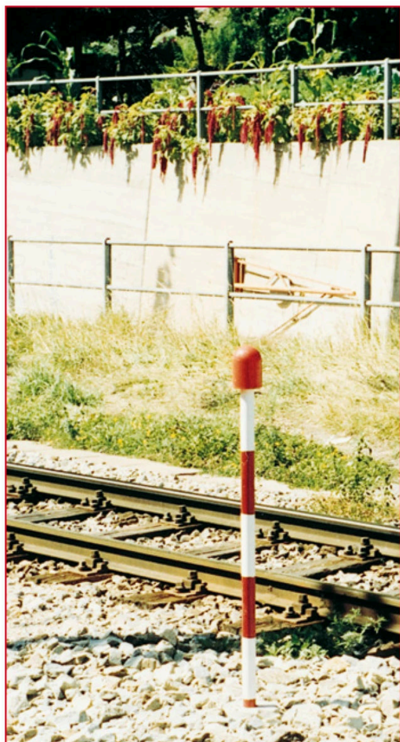
Ook in verband met de sneeuwhoogte staat deze pyloon bij de Matterhorn Gotthard Bahn op een rood/witte paal.
