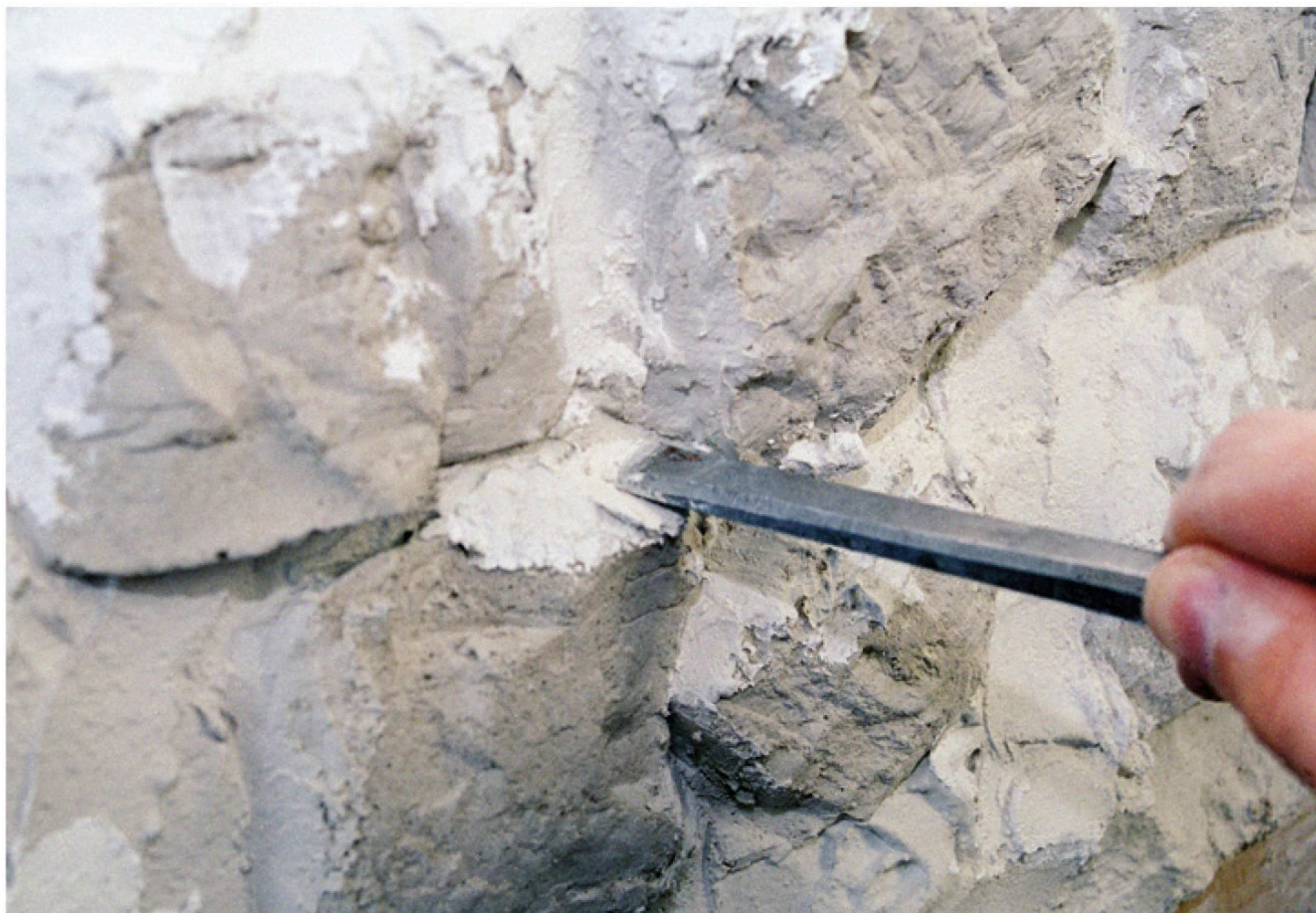
Met een paletmes klodder je het gips lekker dik over het gaas heen. Wanneer het gips droog is, is de dunne schil keihard.
