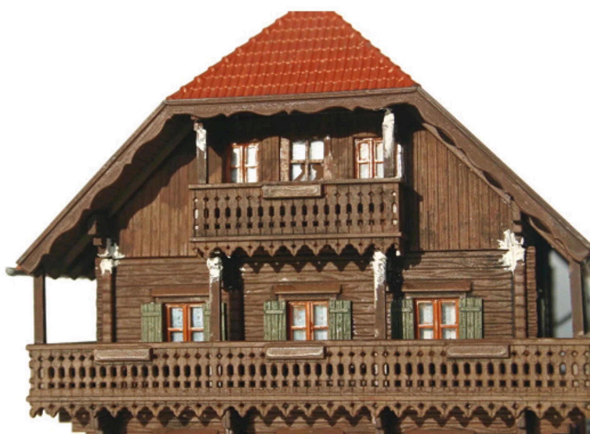
Lakplamuur brengt de te korte staanders op lengte.
