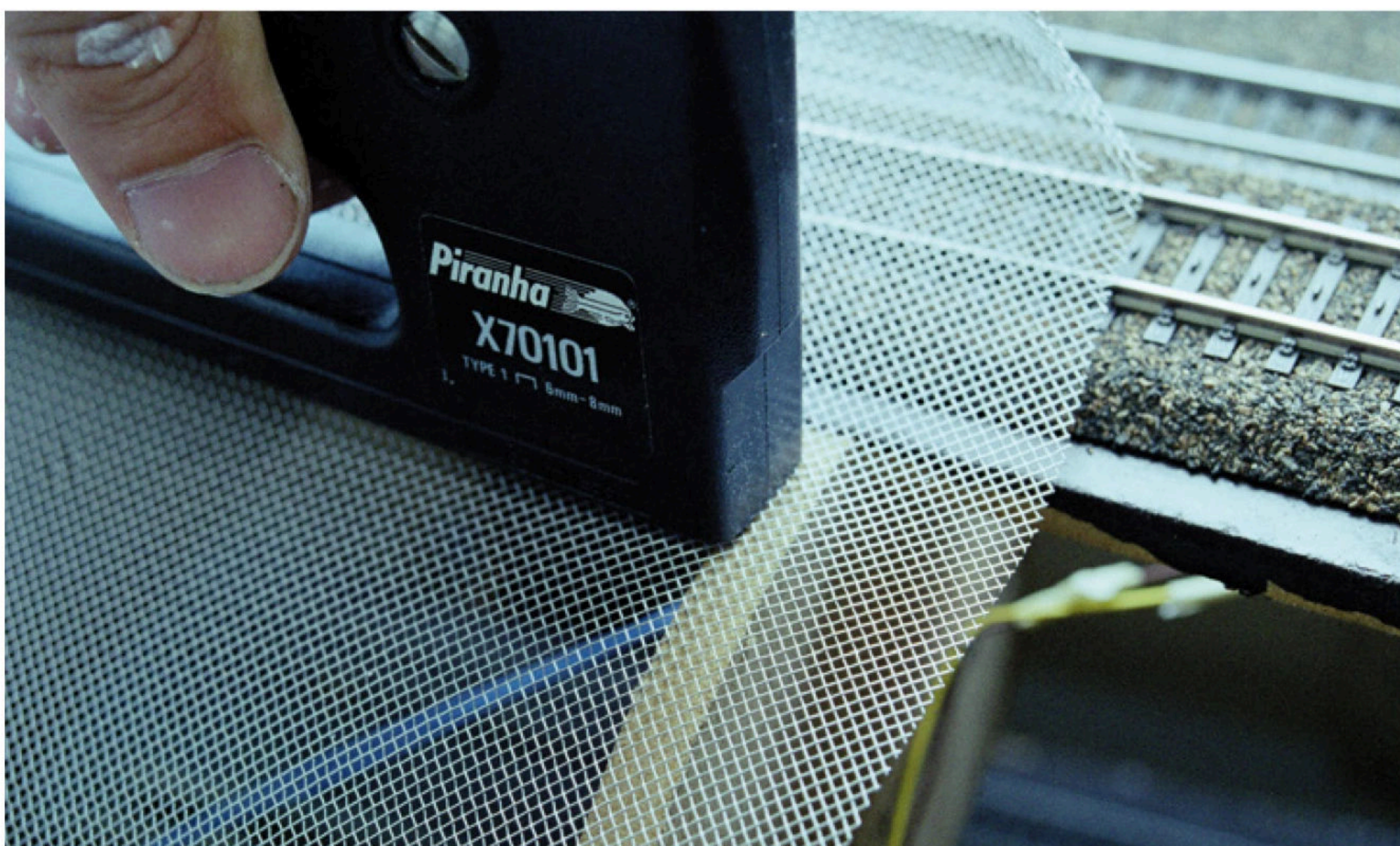
Het aluminiumgaas niet je met een tacker vast op de spanten.
