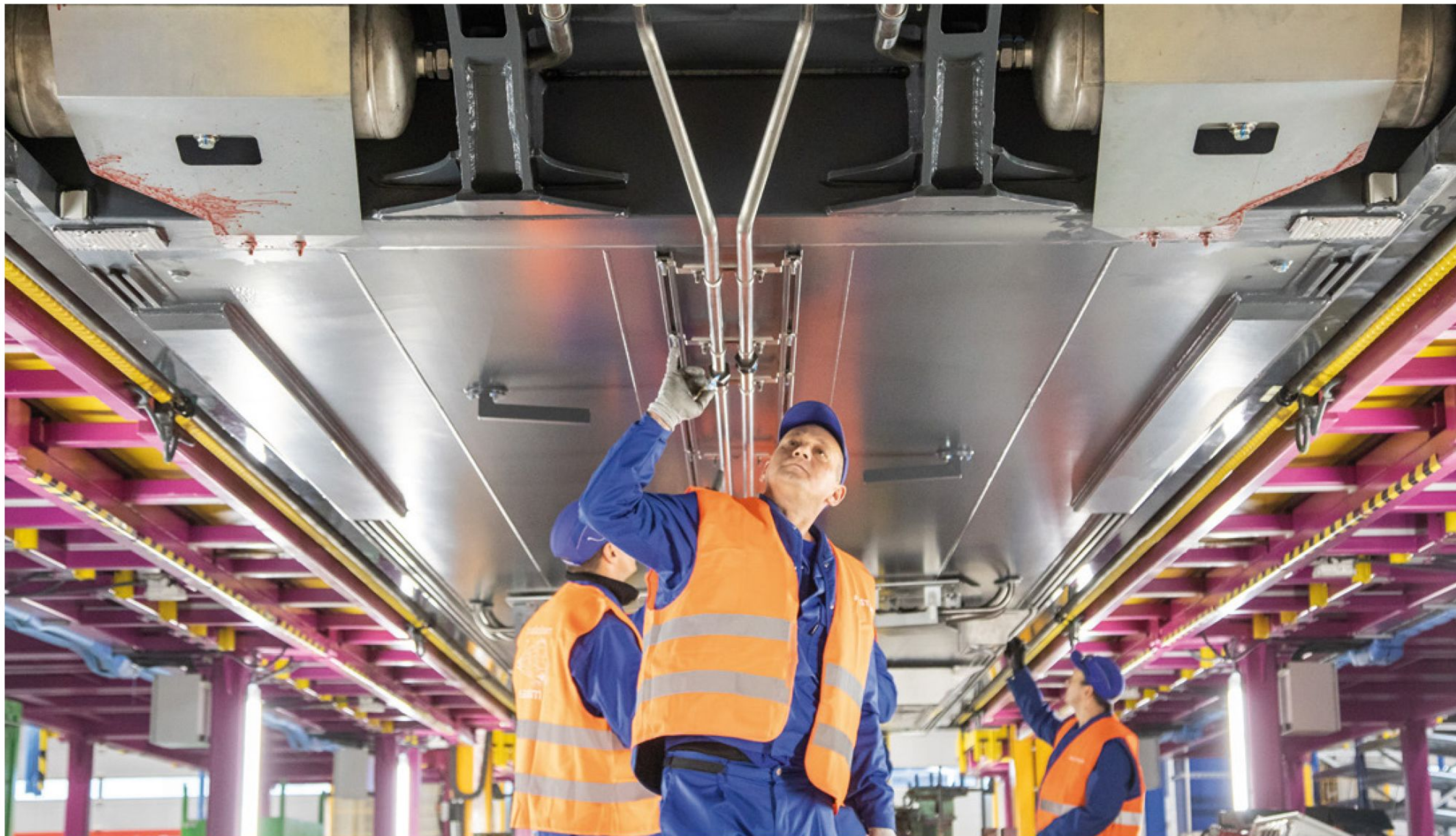
Bij een tussenbak wordt aan de onderkant gewerkt.
