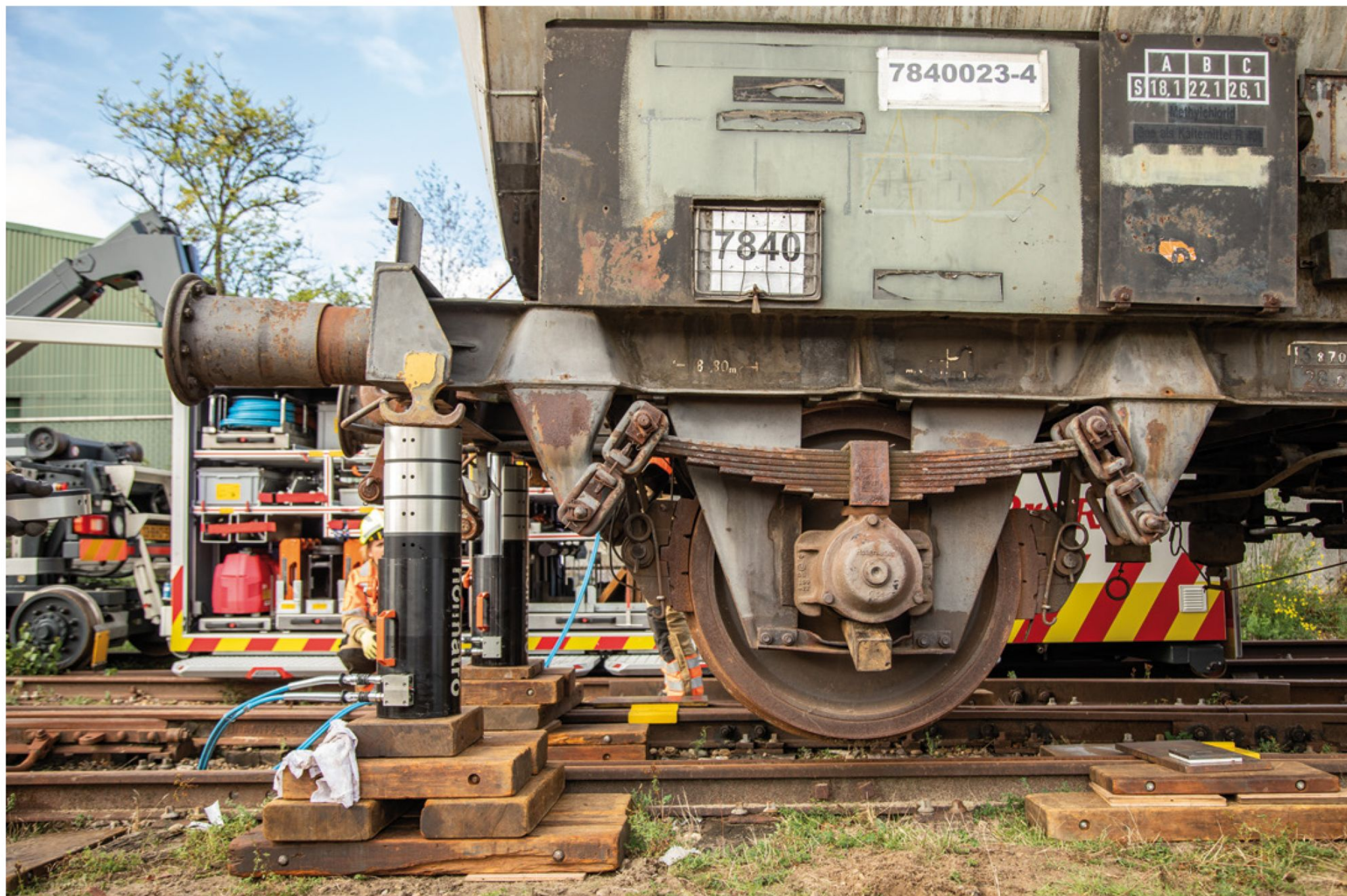
De herspoormethode waarbij twee hydraulische vizels op een houten ondergrond worden geplaatst.
