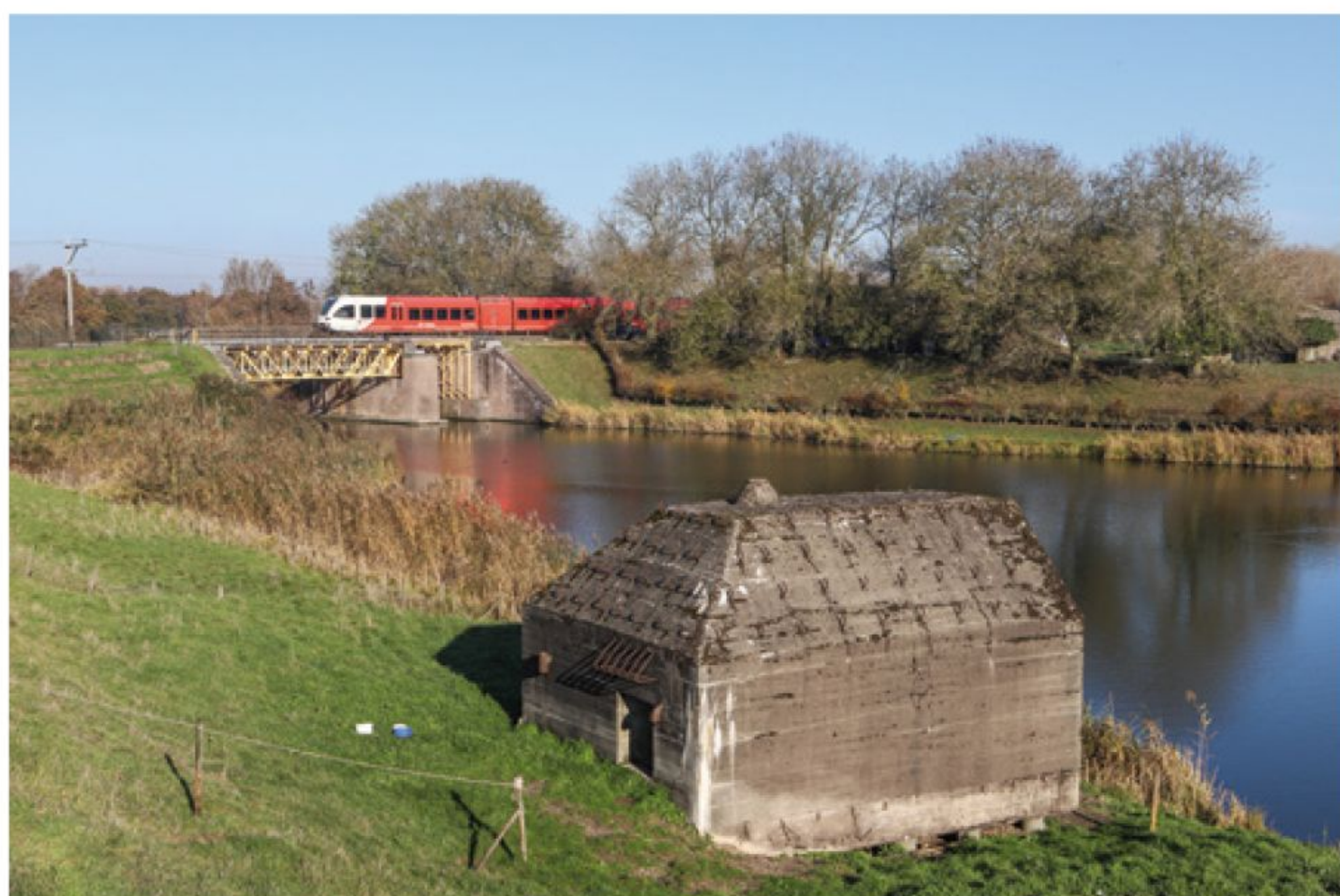
Een Arriva-stel rijdt over de brug bij Werk op de Spoordijk, op de voorgrond een groepsschuilplaats.
