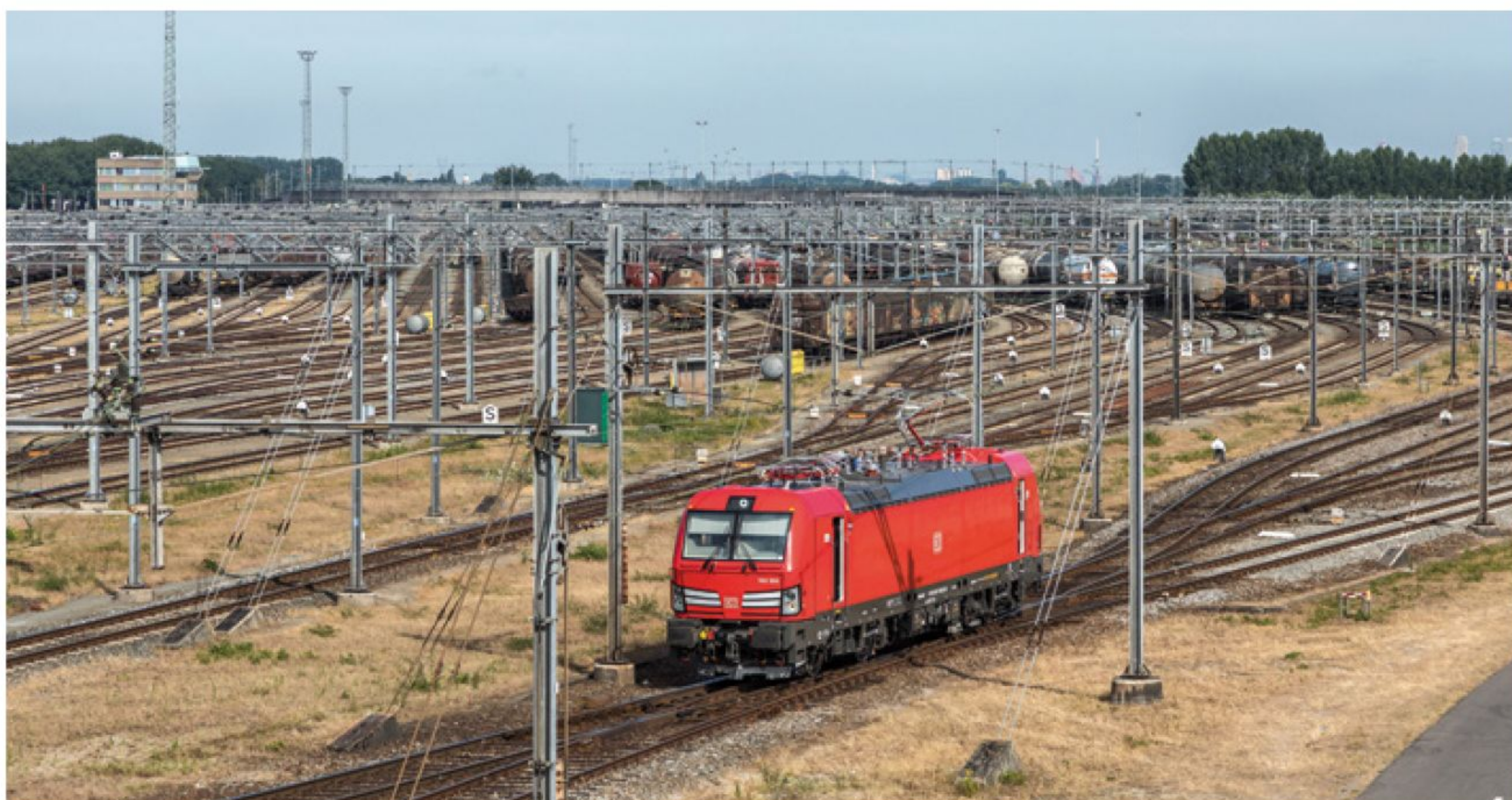
Pas nadat de veiligheid is verbeterd kunnen de onderhoudswerkzaamheden op Kijfhoek worden hervat. (foto Aad de Meij)
