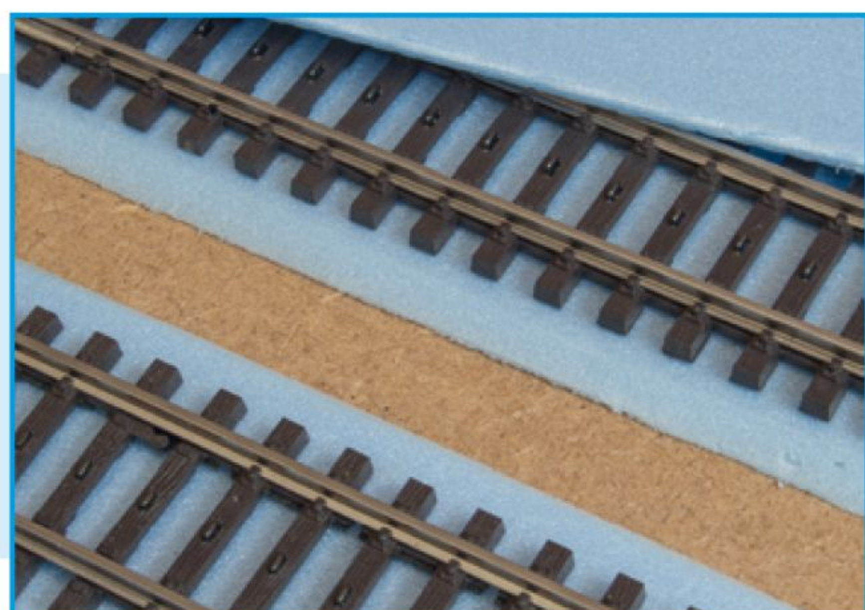
Bevestig het isolatiematerieel met houtlijm aan de ondergrond.
