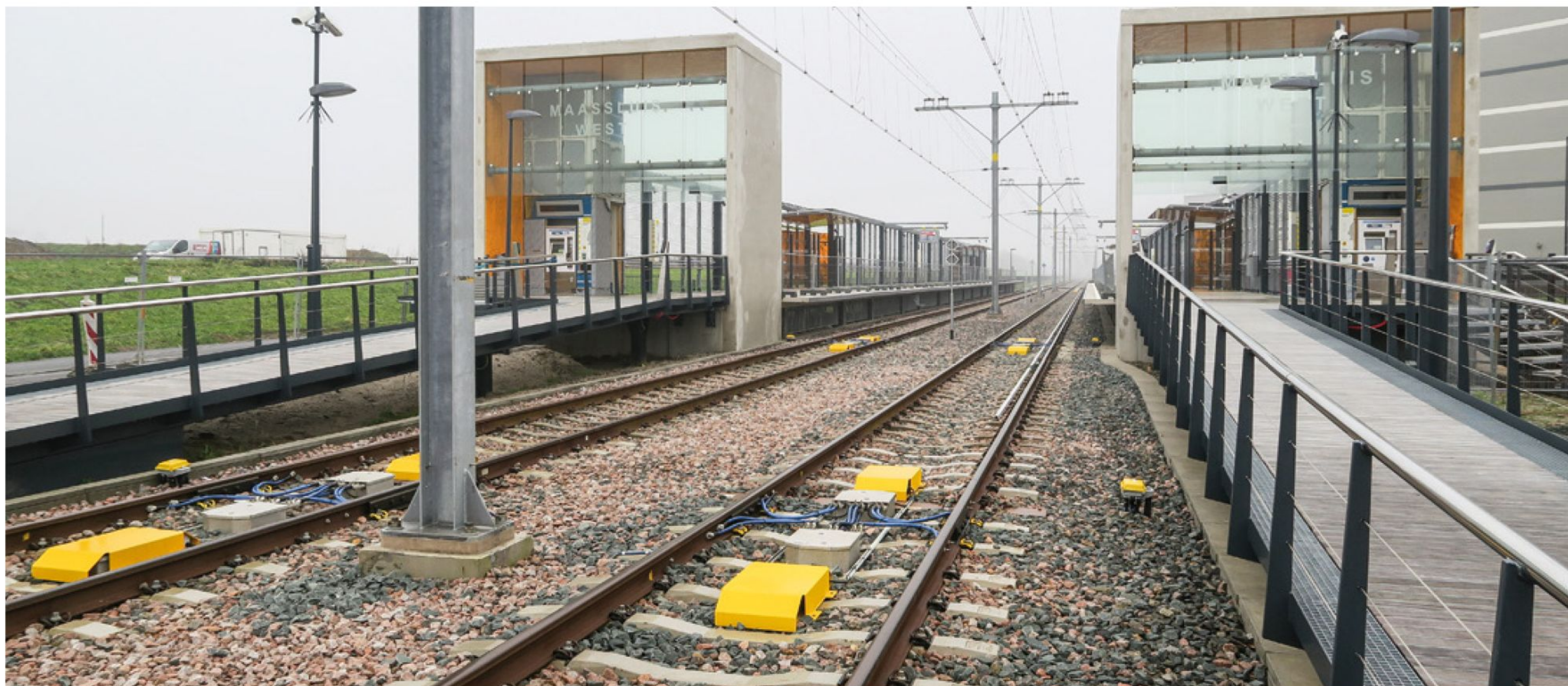
Een balise in het spoor voor de nieuwe spoorbeveiliging. (foto Ton Oosterom)
