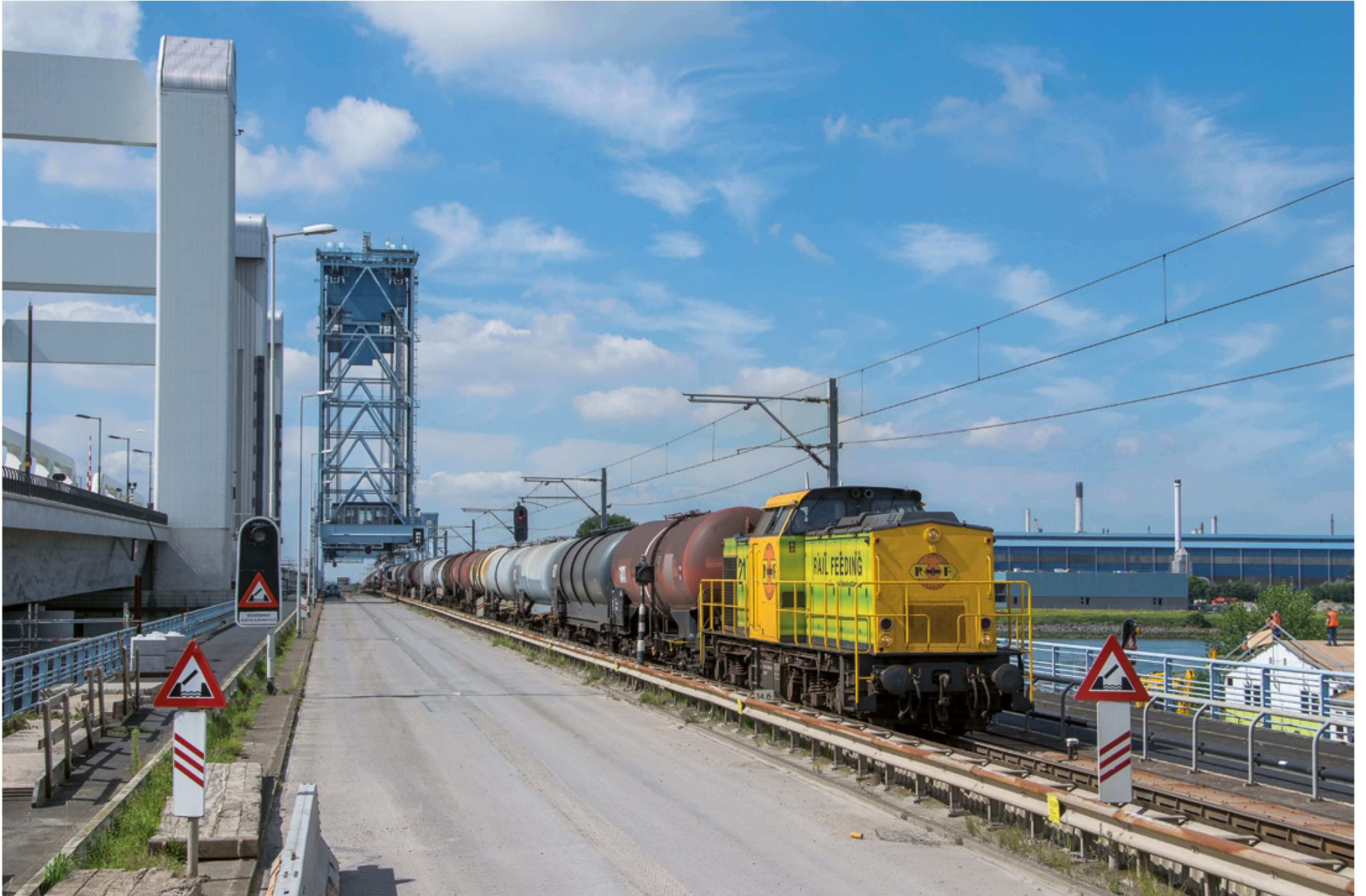
RRF 21 rijdt met een lege keteltrein op 21 augustus 2017 als één van de laatste treinen over de oude Botlekbrug.
