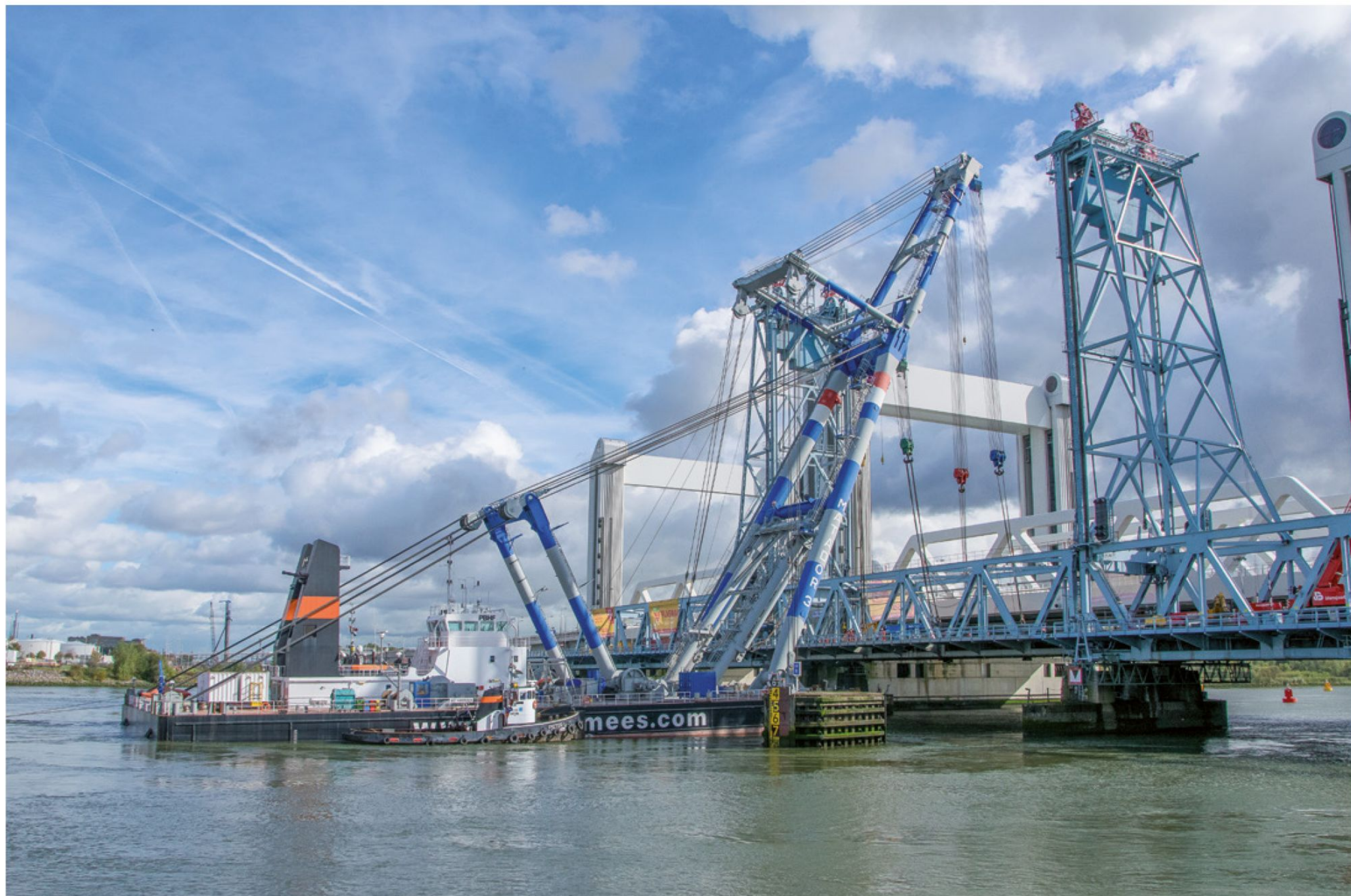
Het uithijsen van het val van de Botlekbrug door de drijvende bok Matador 3.
