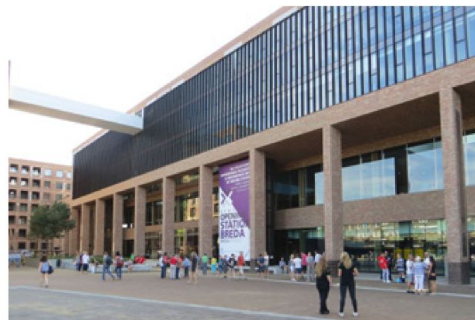
De toegang aan de noordzijde, het parkeerdek is via de witte traverse bereikbaar. (foto Ton Oosterom)
