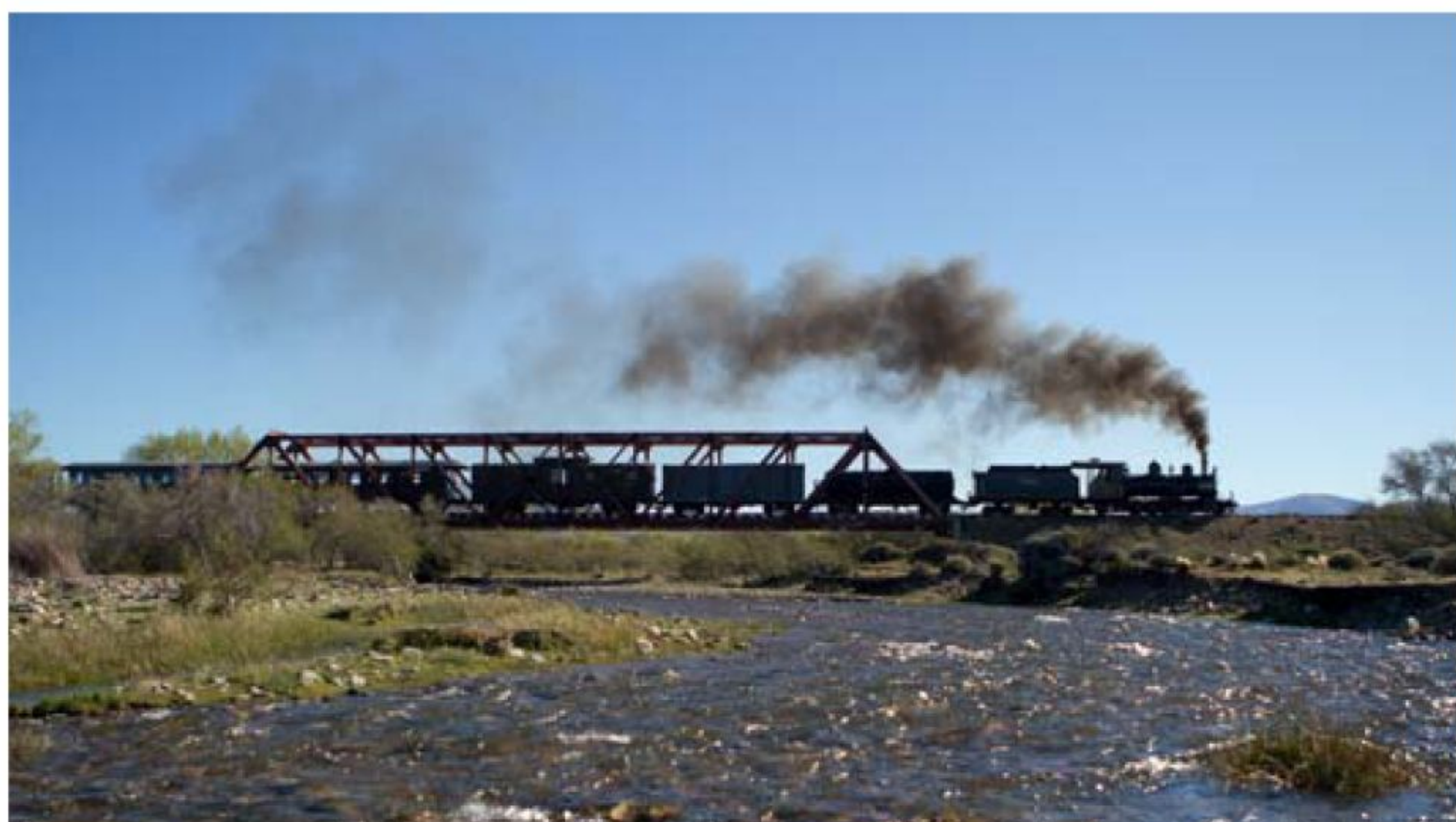
Tussen Mayoco en Lepá passeert loc 4 een van de weinige stalen vakwerkbruggen op de lijn tussen Esquel en Ing. Jacobacci. 23 oktober 2014.
