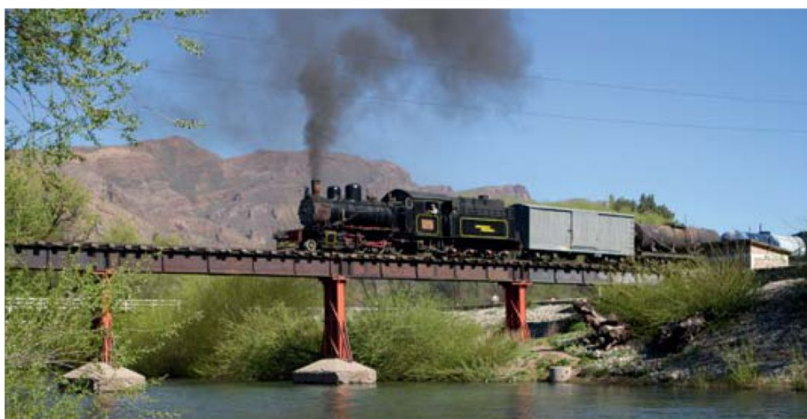
Loc 101 is vertrokken uit El Maitén en passeert de brug over de Chubutrivier. Die markeert de grens tussen de provincies Chubut en Rio Negro, 24 oktober 2014.
