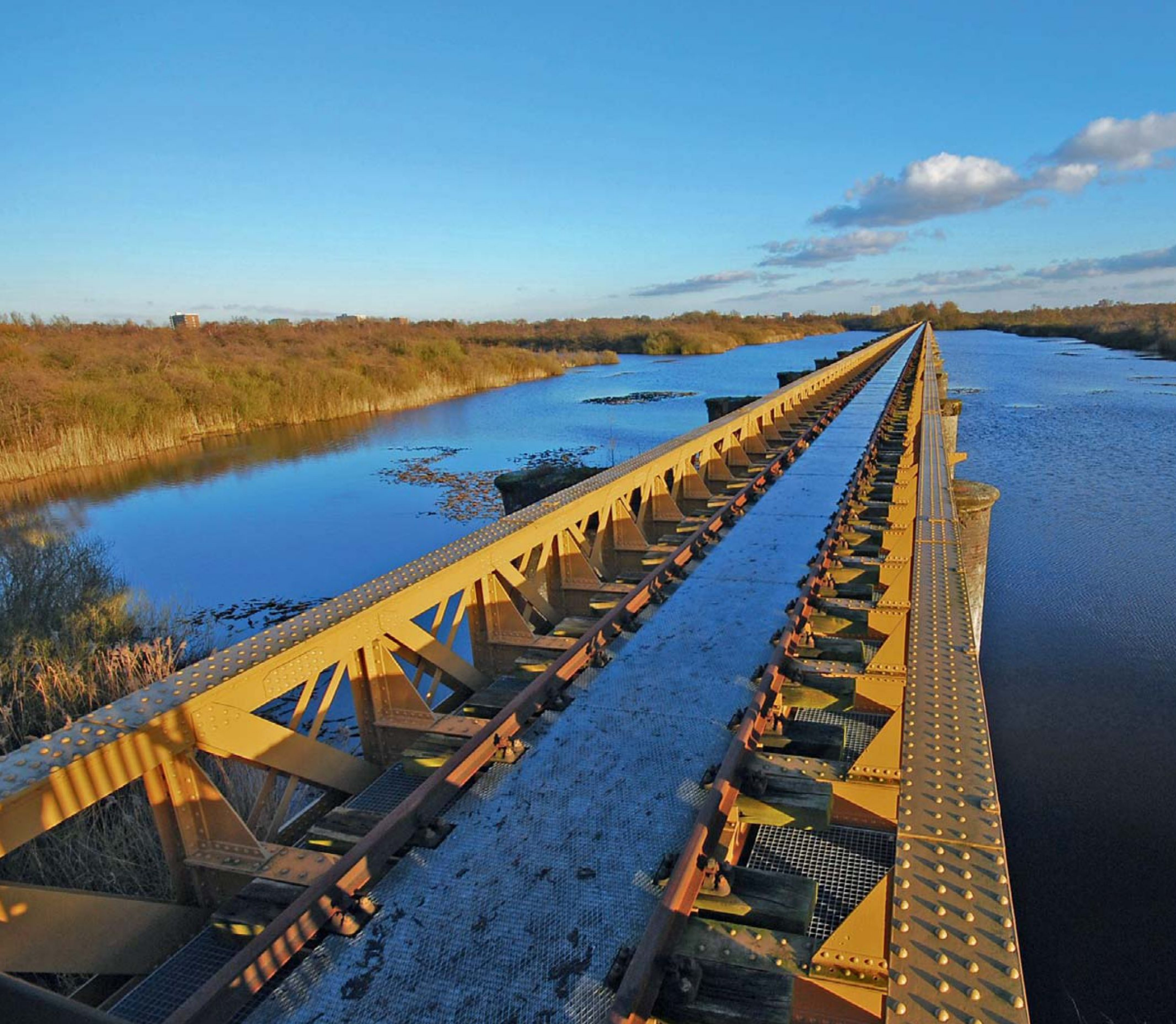
De Moerputtenbrug door het Bossche Inundatieveld, 10 februari 2008.
