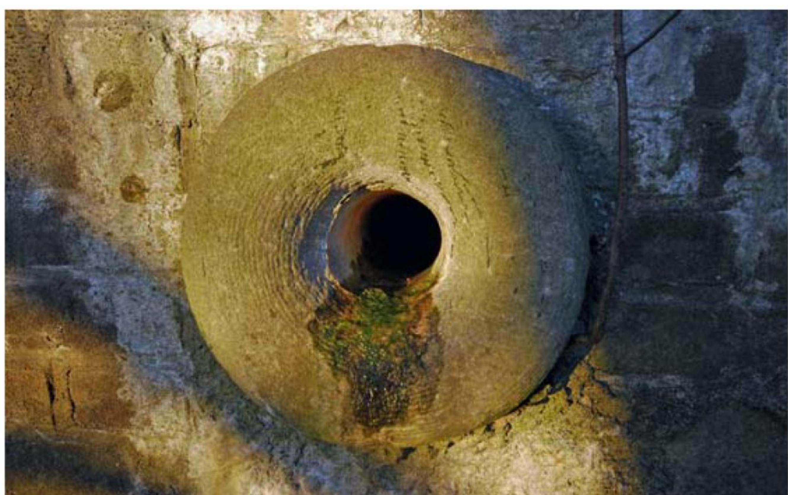
In de details herkennen we het vakmanschap en de zorgvuldigheid waarmee alle objecten voor de Langstraatspoorweg zijn ontworpen, zoals deze 'druipsteen' in een van de landhoofden van de Venkantbrug, waarlangs ingesijpeld hemelwater afgevoerd kan worden, 12 januari 2008.
