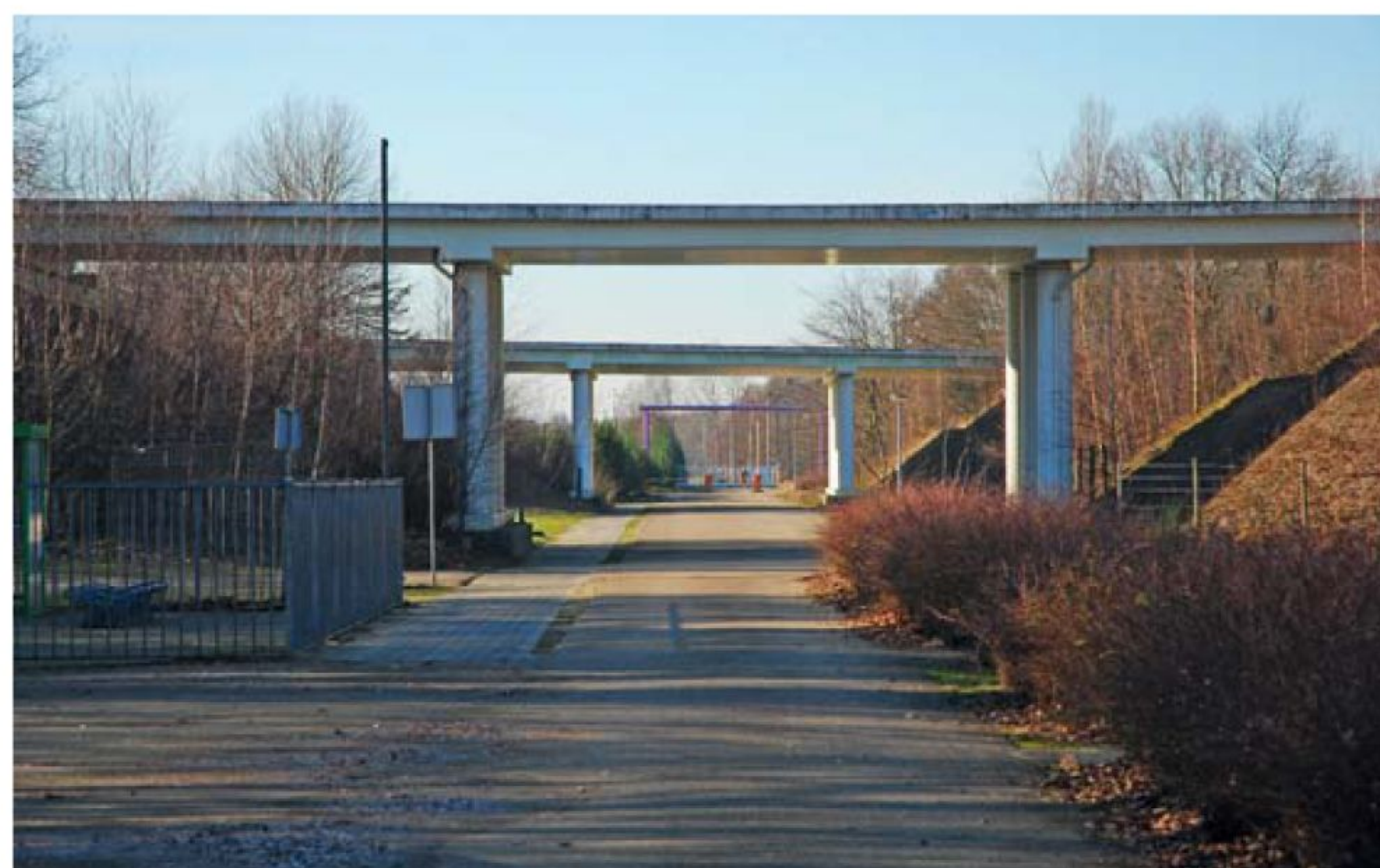
Het verlegde en nooit als zodanig gebruikte spoortracé langs het Land van Ooit bij Drunen, met de twee viaducten van de N267 die evenmin enig doel gediend hebben, 10 februari 2008.
