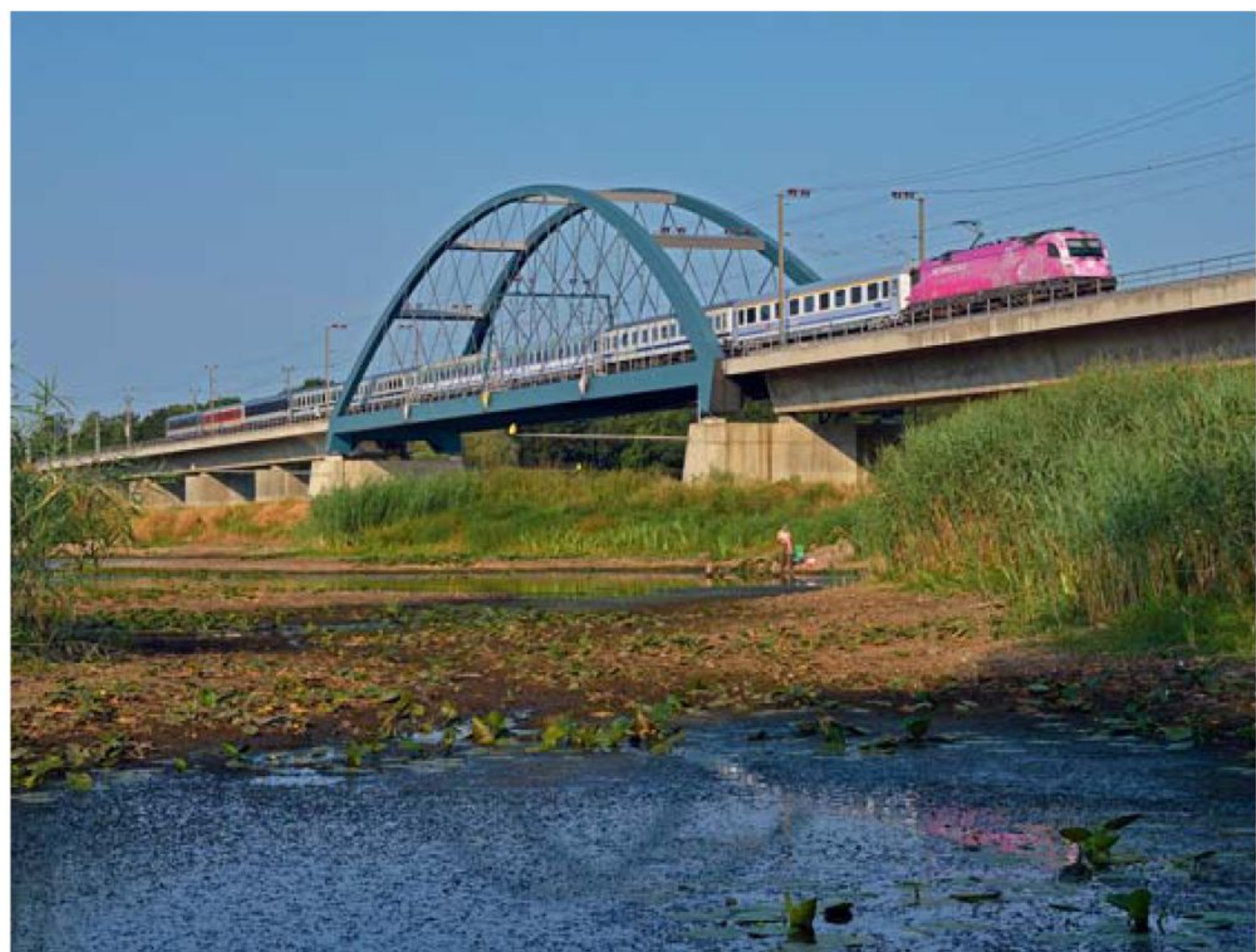
De Oderbrücke werd in 2008 geheel vernieuwd. De kosten werden volledig door Duitsland gedragen. Vanaf de Poolse oever gezien steekt een EuroCity naar Warschau de brug over. De slaaprijtuigen van de EuroNight bevinden zich achterin de trein.
