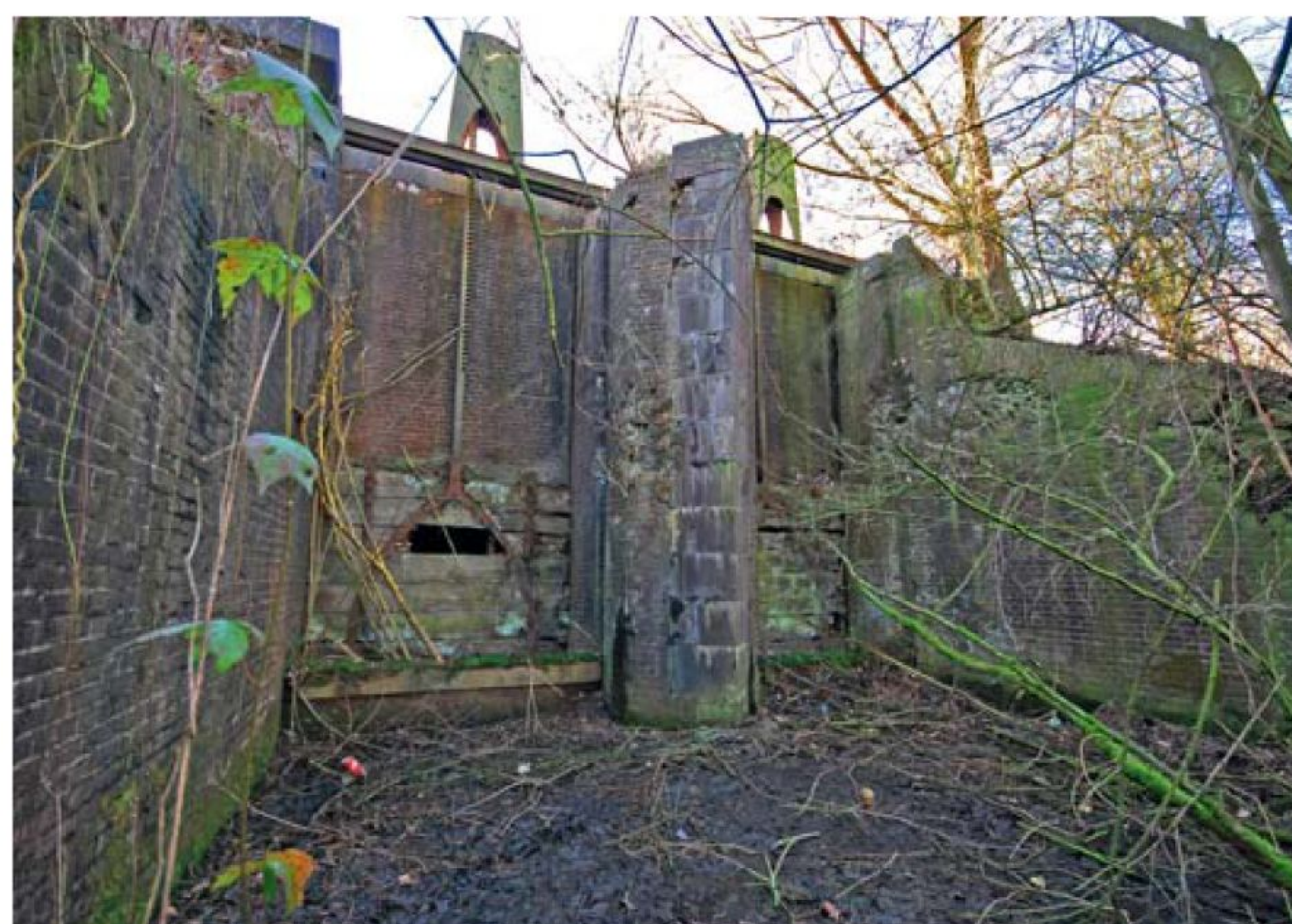
Helaas is enkele jaren geleden dit fraaie kunstwerk bij Den Bosch door de aanleg van de Randweg verloren gegaan: de 'waterkerende duiker in de Jachtsloot' waarmee een groot gebied bij Den Bosch onder water gezet kon worden. Het mechaniek voor de bediening van de schuiven stond bovenaan op de spoordijk, 10 februari 2008.
