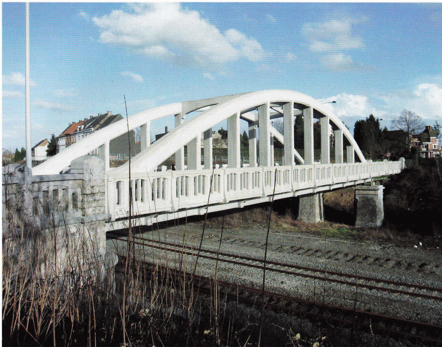
De beschermde Pessemiersbrug werd onlangs gerestaureerd.
