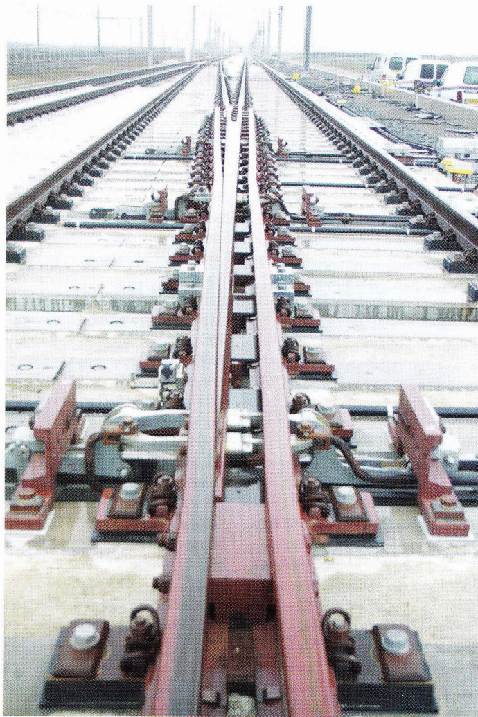
Een wissel met beweegbaar puntstuk in de HSL Zuid. Prima voor de Thalys, maar niet voor de tram.
