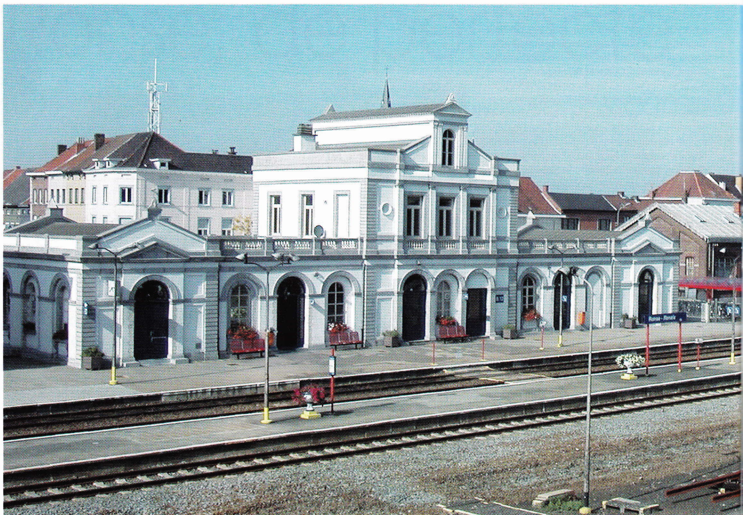
Het stationsemplacement in zijn huidige staat. Achteraan staat de reusachtige goederenloods.
