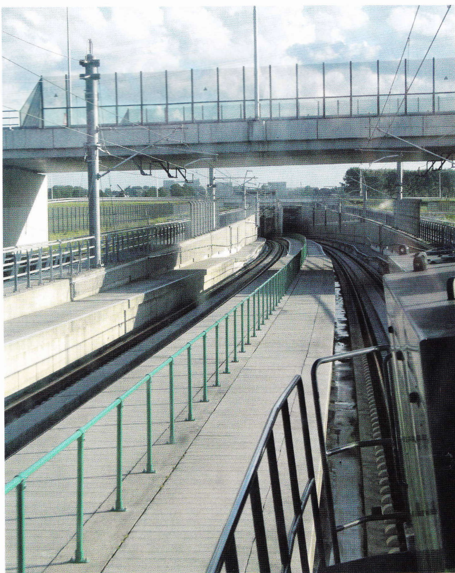
Zicht vanaf de bijrijderstoel in de MaK G1206 tijdens het naderen van de Groene Hart tunnel richting Rotterdam.
