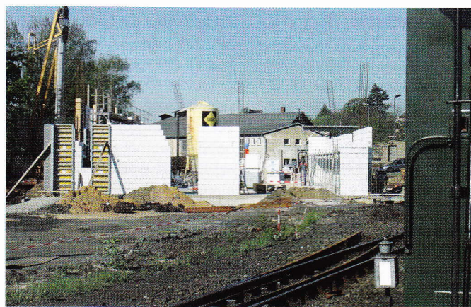
Tussen station en locloods in Zittau wordt een nieuwe hal voor de smalspoorrijtuigen gebouwd. (foto Guus Ferrée)
